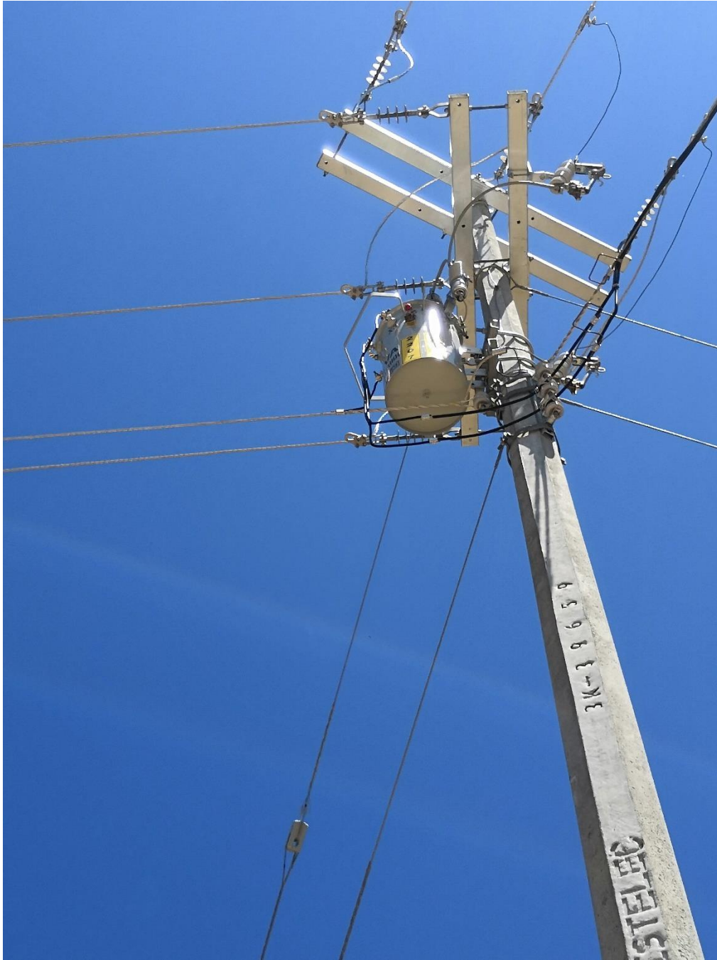
Fig. A.11 Vestido de Estructura de un Poste en M.T. Tipo RD30/RD3, tres Fases para 13.2 KV. e instalación de transformador de 10KVA
