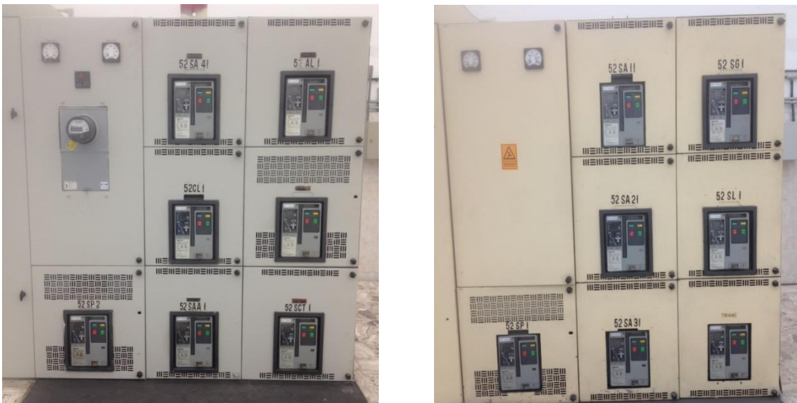
Fig.2.4 Gabinete de servicios propios U-1 y U-2 de izquierda a derecha.
