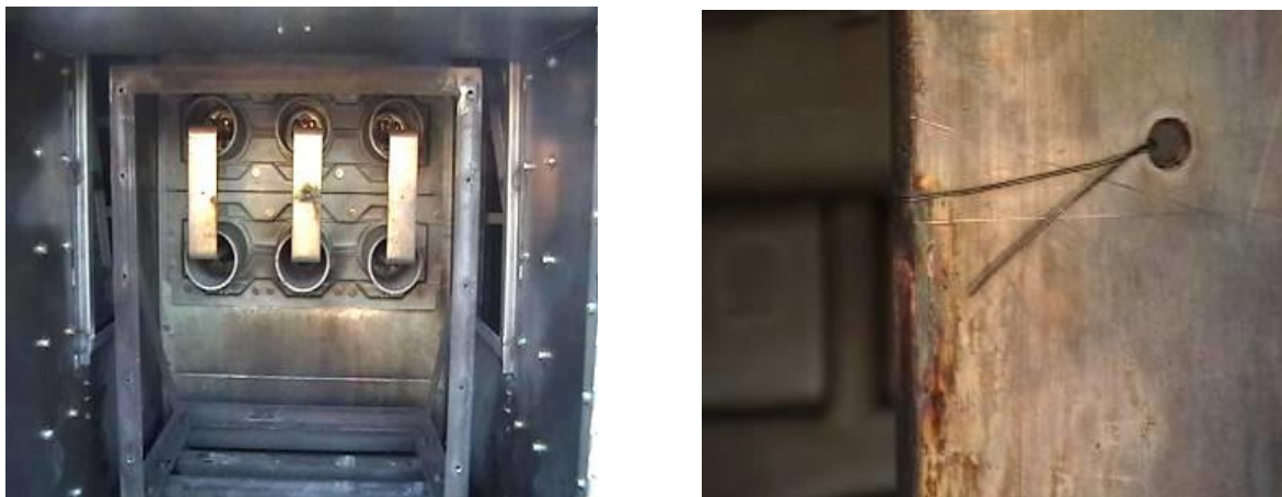
Fig. 2.16 Pruebas de arco eléctrico de 50kA a 500 ms con protección de arco.
