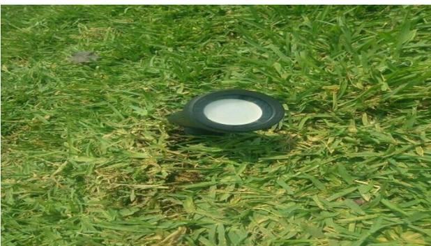
Figura 3.1.11 Reflector LED tipo estaca
