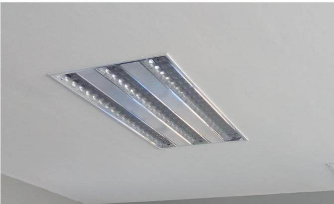
Figura 3.1.7 Lámpara LED de techo
