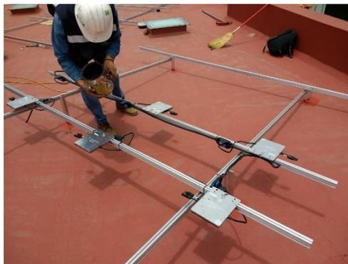
**Fig.3.18** Instalación de micro-inversores
