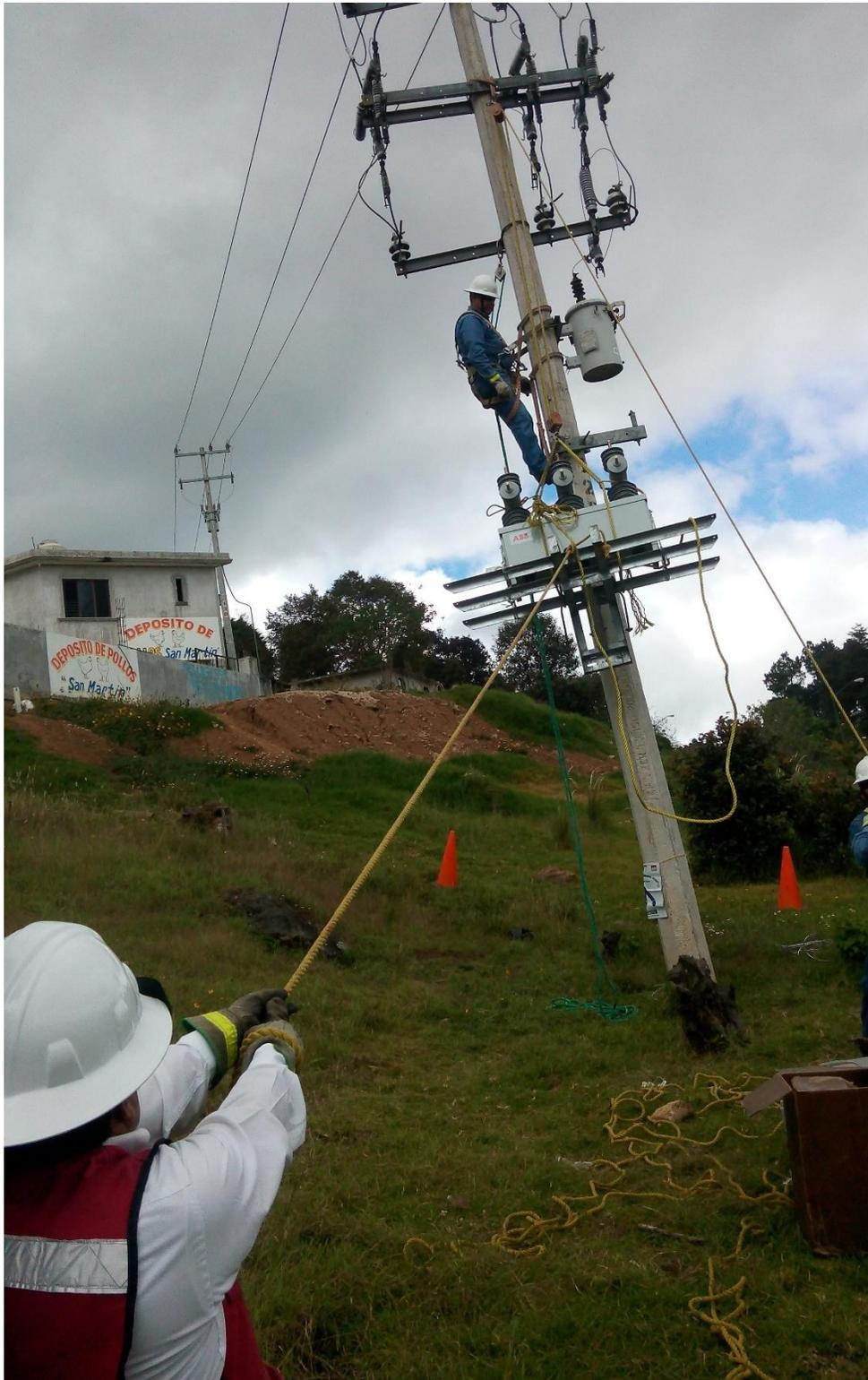
**Fig. C.3** *Instalación del restaurador.*
