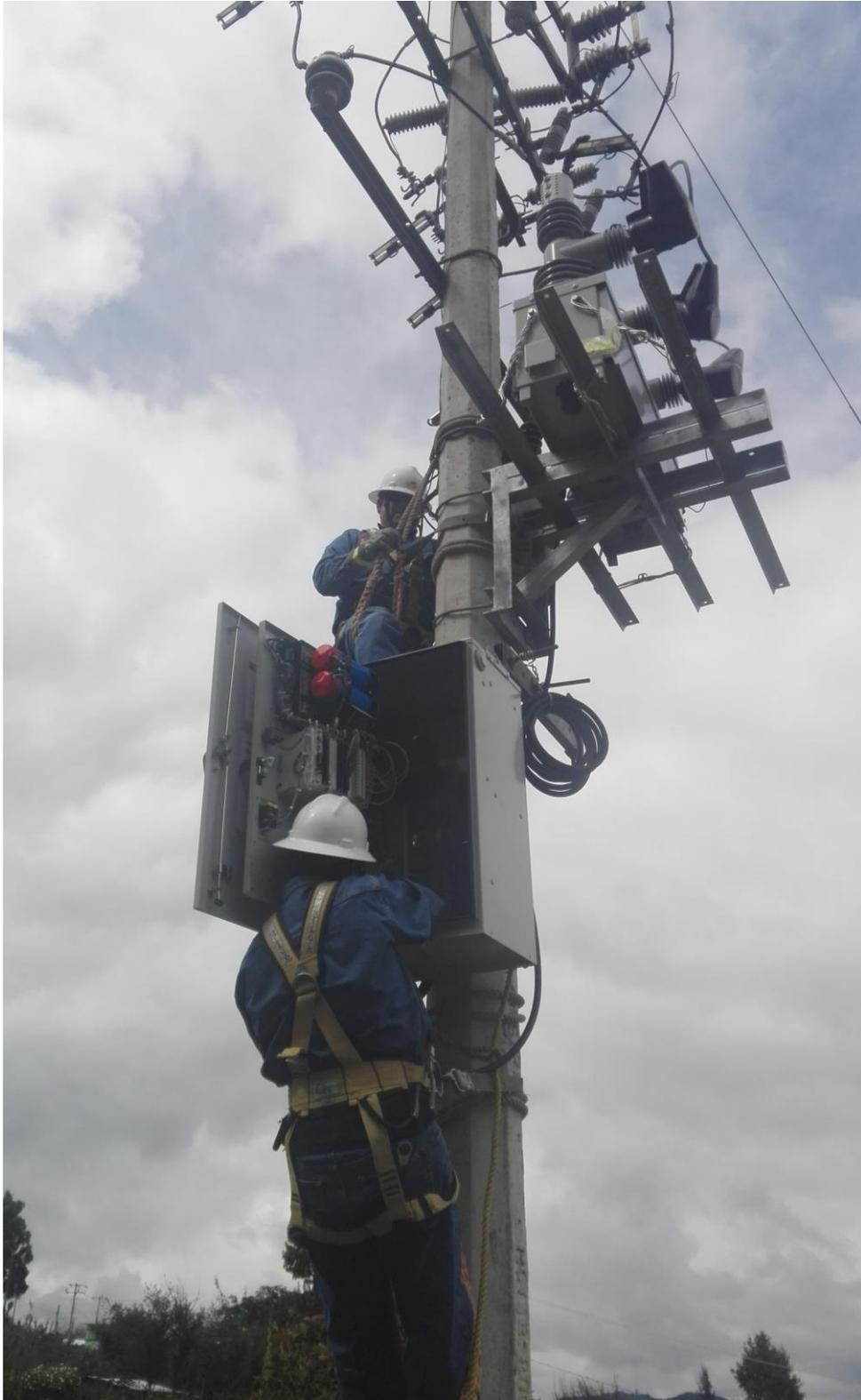
**Fig. C.5** *Programación del control del restaurador.*
