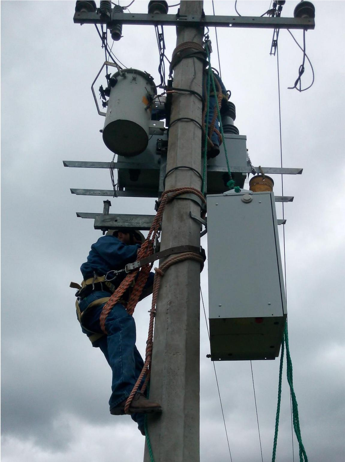
**Fig. C.4** *Instalación de la caja de control del restaurador.*
