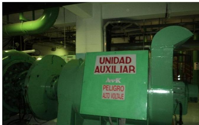
Figura 15: Unidad auxiliar ubicada en piso de turbinas.
