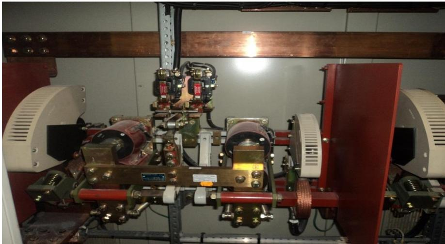
Figura 6: Gabinete Parte interior Quebradora de campo.
