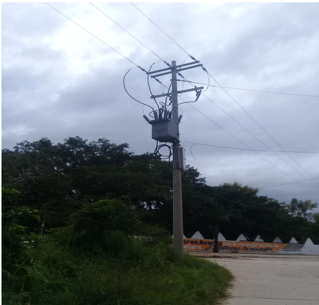
Figura No.12 Restaurador La Calzada.
