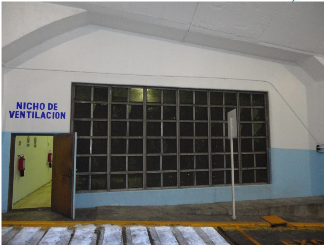
Figura 3.3.1.1 Foto del nicho de ventilación de la central
