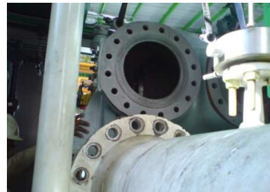
Figura 3.10 Colocación de compresor de alta presión
