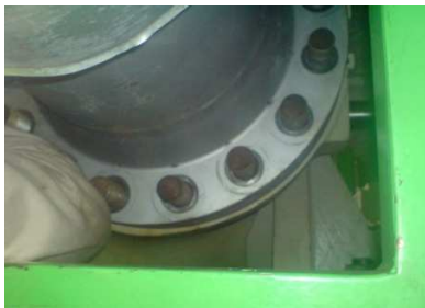
Figura 3.3 Desmontaje de compresor
