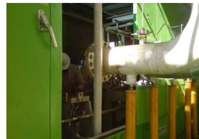
Figura 3.8 Preparación del área para instalación del compresor nuevo.
