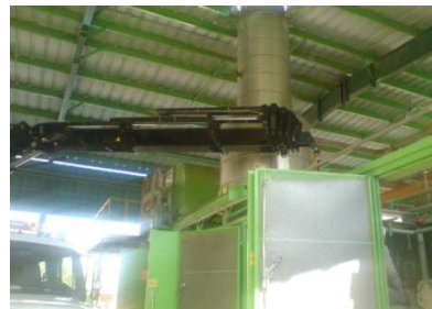
Figura 3.4 Izado de compresor
