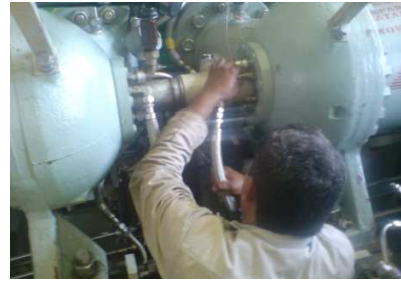
Figura 3.14 Reconexión de tubos de alimentación de aceite.
