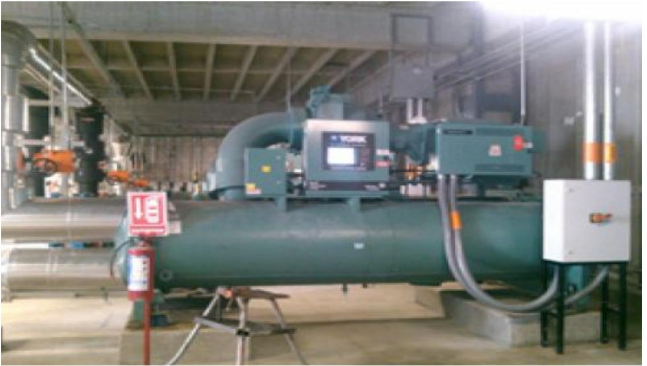
**Chiller con compresor tipo centrífugo**
