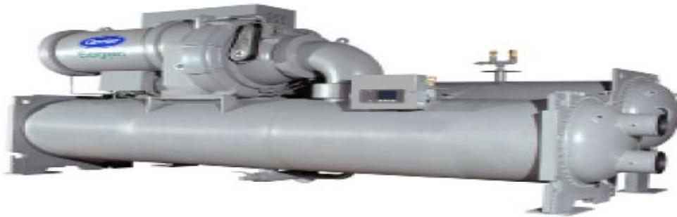
Chiller con compresor centrífugo y condensador enfriado por agua
