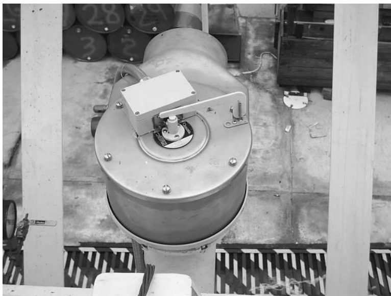
Fig. 24 Válvula de Sobrepresión.
