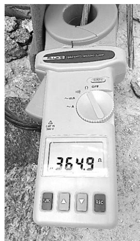
Fig. 4.2 Medición del sistema de tierra de la estructura 136.
