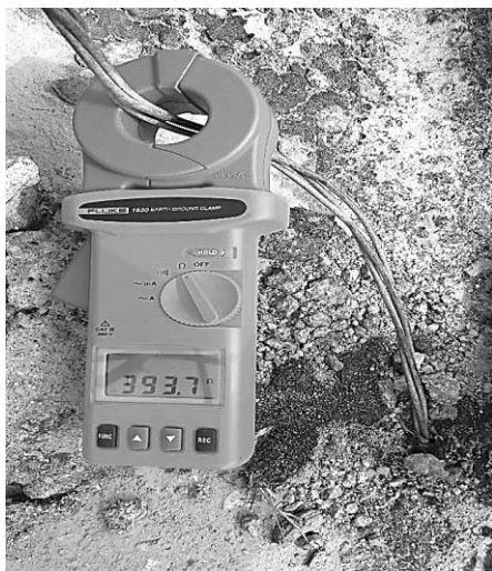
Fig. 3.17 Lectura Pata 3 de la estructura.
