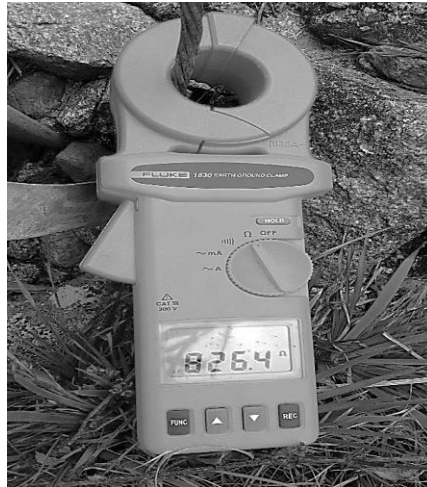
Fig. 3.16 Lectura Pata 2 de la estructura.
