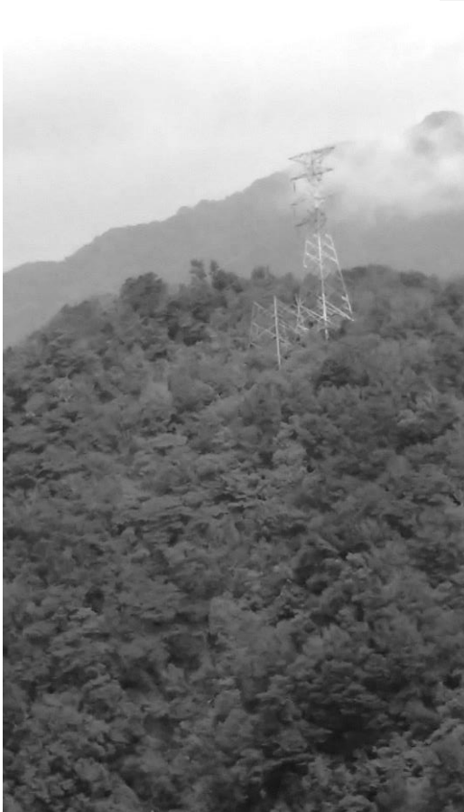
Fig. 3.8 ingreso a la estructura vía aérea.
