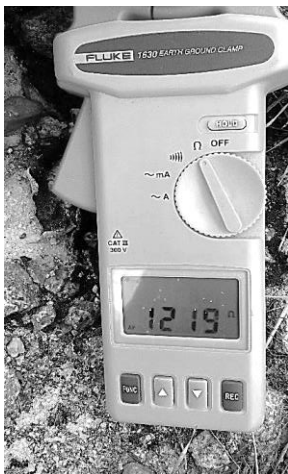
Fig. 4.1 Medición del sistema de tierra de la estructura 235.
