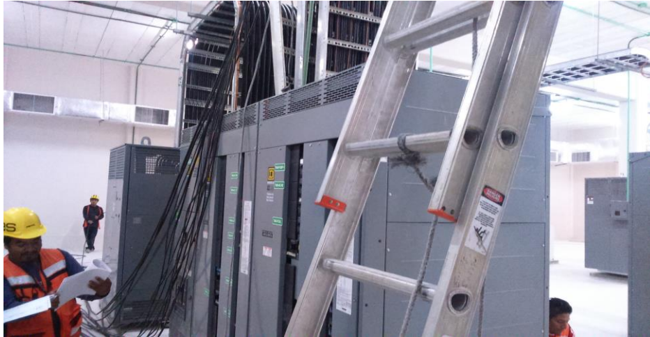
Imagen 31.- Instalación del Tablero General que va conectado al transformador 4.
