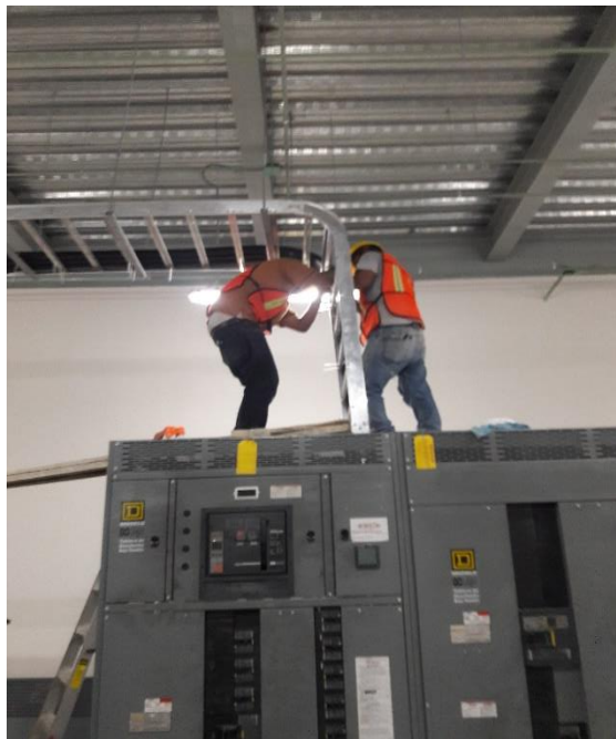
Imagen 36.- Colocación de Charola porta cable desde el transformador a su trayectoria.
