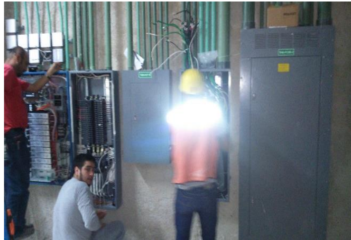
Imagen 43.- Cerrando Tableros terminados con los cálculos correspondientes.
