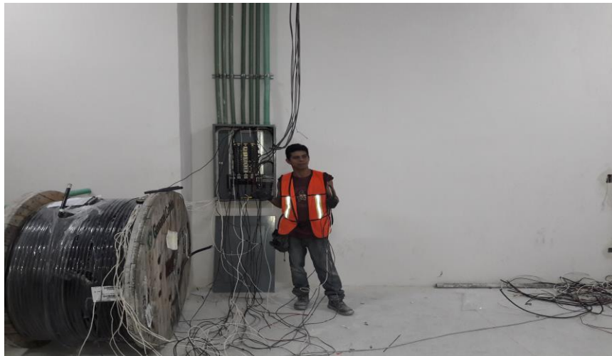
Imagen 14.- Cable Condumex siendo Instalado en un tablero de distribución en el Hotel Moon Grand Palace, Cancún, México.
