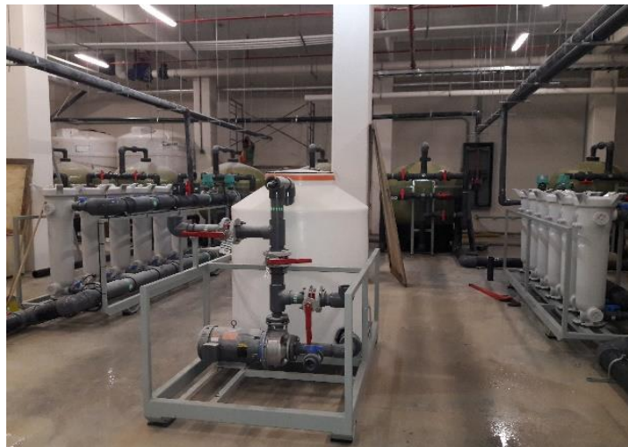
Imagen 37.- Área de osmosis lugar donde se ocupó muchos motores por lo que necesito tableros más grandes.
