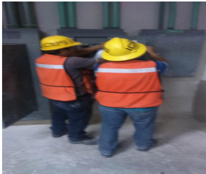
Imagen 18.- Instalación del Tablero NF en el Hotel Moon Grand Palace.
