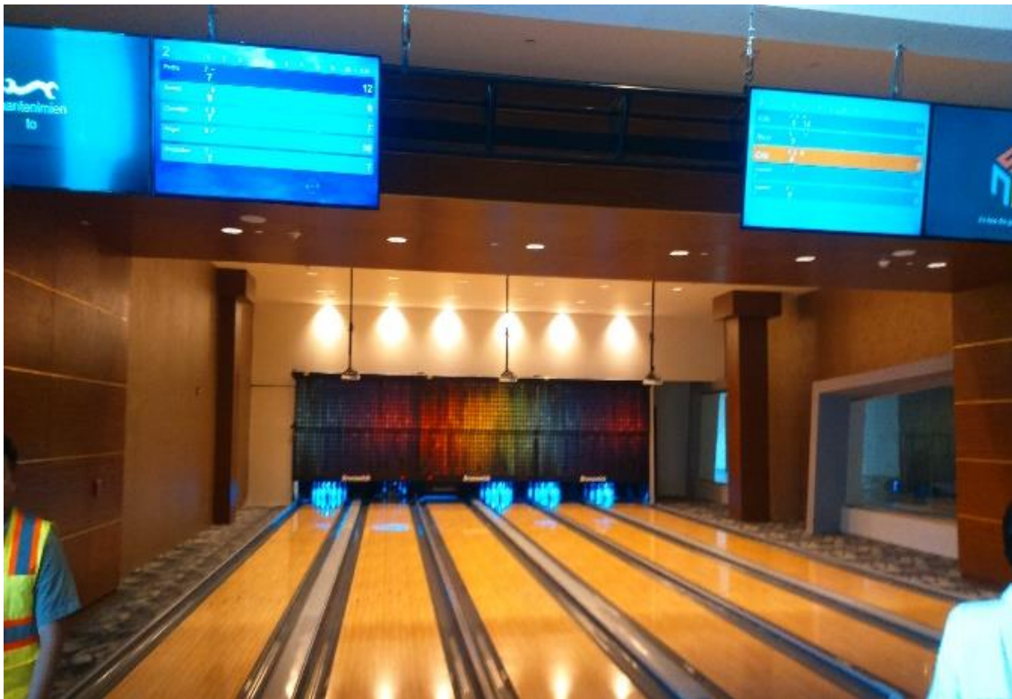
Imagen 52.- Área de Boliche alimentada eléctricamente y puesta en marcha.
