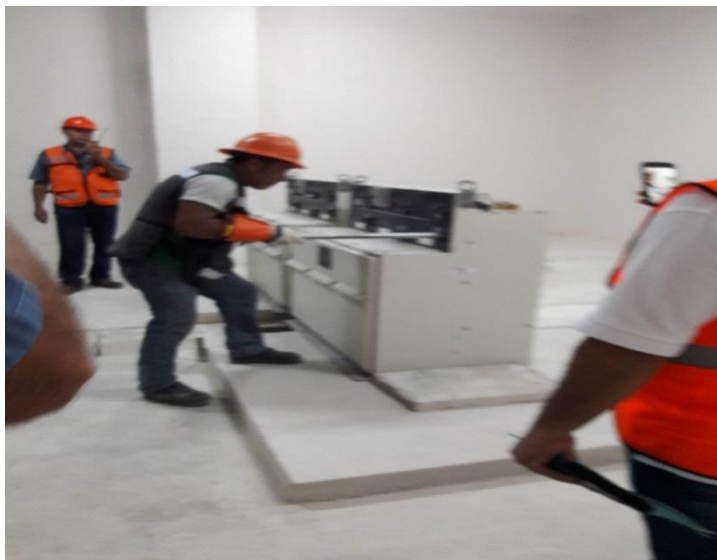
Imagen 29.- Energizando el primer Seccionador en la obra.
