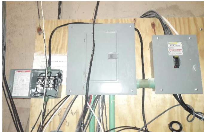
Imagen 28.- Uso de tableros de Emergencia o Apoyo en áreas que se requiriera.
