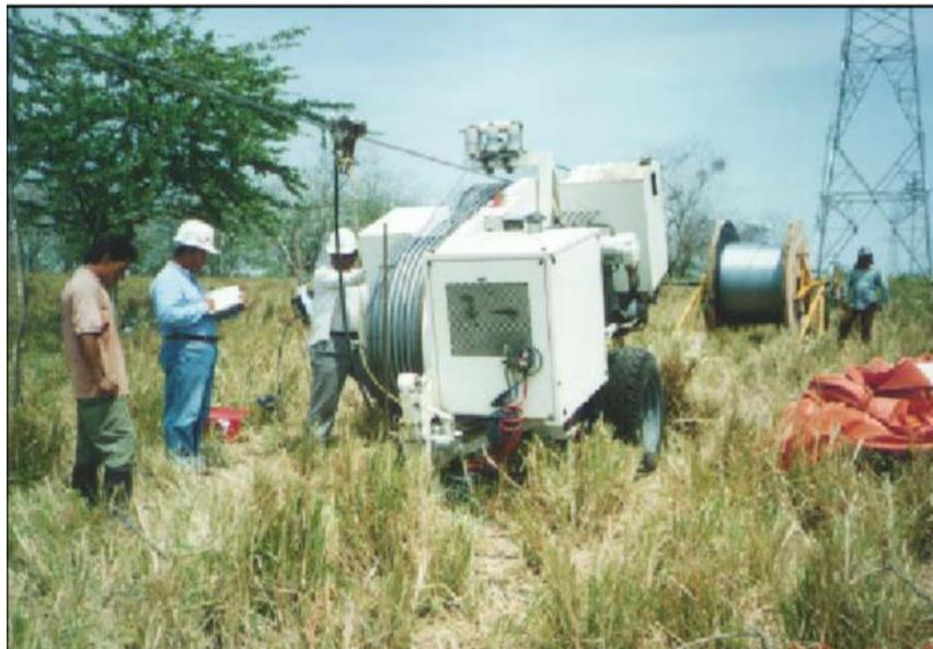
Fig. 31 Tendido de conductores de fase.
