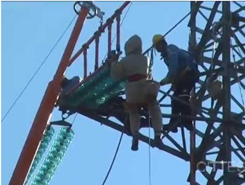
Fig. 34 Puesta de la cadena de aisladores en la LST.
