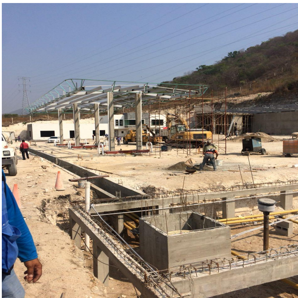
FIG.B.2: CONSTRUCCION DE OBRA CIVIL, HIDRAULICA Y ELECTRICA DE ISLA DE ESTACION DE SERVICIO.
