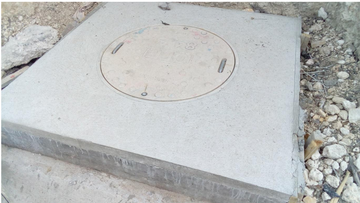
FIG.B.1: REGISTRO MT PREFABRICADO PARA INTALACION SUBTERRANEA.
