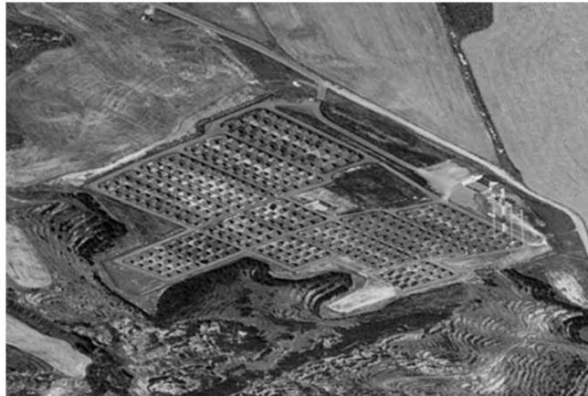
Figura 5.89 Planta fotovoltaica de Tudela (1.18 MW).
