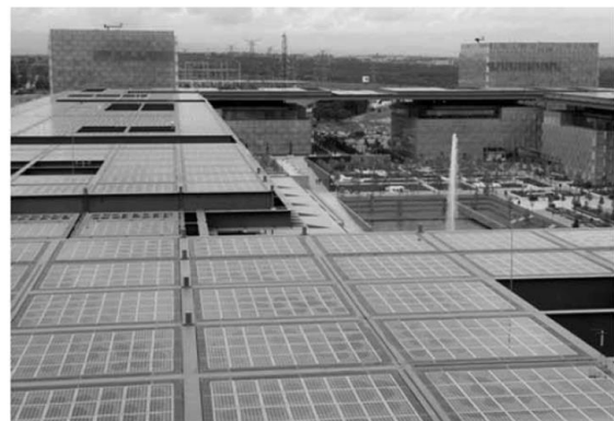
Figura 5.78 Detalles módulos de la instalación fotovoltaica del edificio de Telefónica en Madrid (Distrito C).
