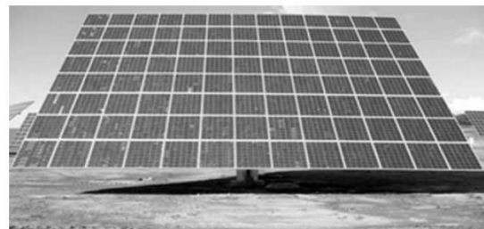
Figura 5.88 Con seguimiento Buskil K18 de Acciona.
