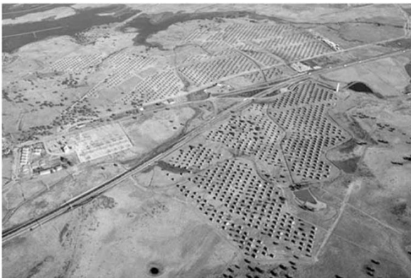
Figura 5.79 Planta solar fotovoltaica de Almaraz de 20 MW.
