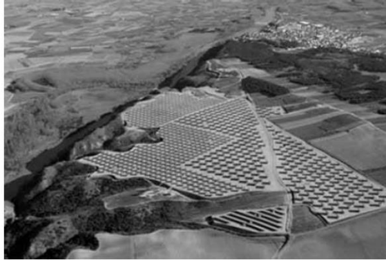
Figura 5.7 Huerta solar de Milagro (Navarra), 7243 kW. [Cortesía de Acción Energía].
