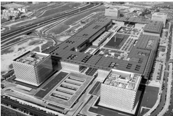
Figura 5.77 Vista aérea de la instalación fotovoltaica del edificio de Telefónica en Madrid (Distrito C).
