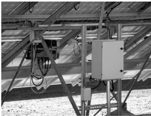
Figura 5.57 Inversor debajo de la estructura y cuadro de conexionado. Distancia entre paneles valor de k en función de la latitud del lugar.
