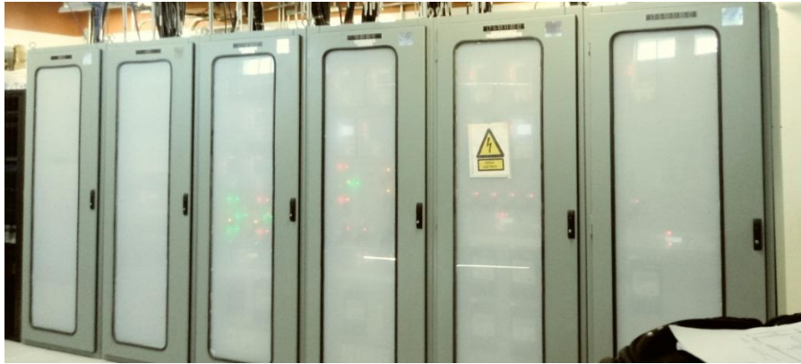
Figura. 23 Colocación del Tablero de PCM nuevo al extremo lado derecho junto a los demás Tableros PCM
