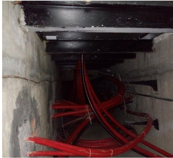
Figura. 25 Colocación de conductor XLP cal 1000 kcm 15 kV en trinchera debajo de los tableros Metalclad con gas SF6
