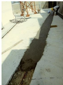
Figura. 17 Encofrado de Banco de Ductos 3 vías tipo arroyo.
