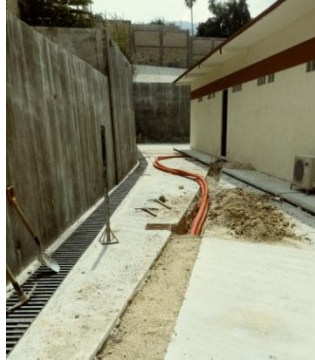
Figura. 16 Encofrado de Banco de Ductos 3 vías
