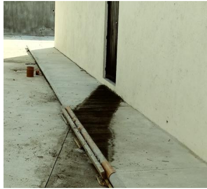
Figura. 18 Encofrado de Banco de Ductos 3 vías tipo banqueta
