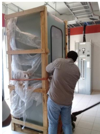
Figura. 22 Fijación de Tablero PCYM en caseta de control
