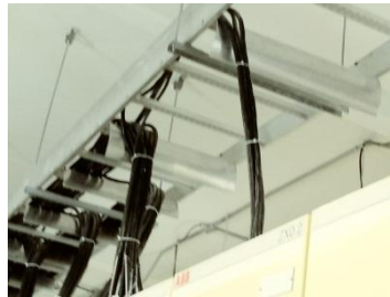
Figura. 27 Instalación de cable de control del tablero Metalclad sobre trinchera aérea hacia el tablero PCM
