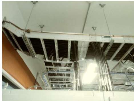
Figura. 28 Instalación de Cable de control de bajada hacia el tablero PCM
