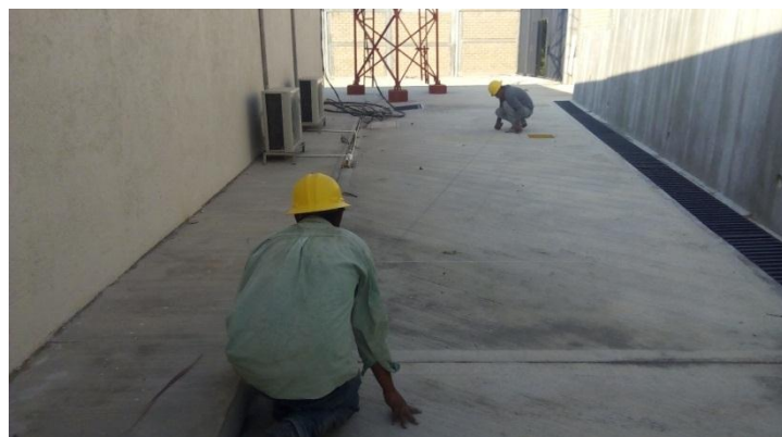
Figura. 13 Trazado del área de excavación.
