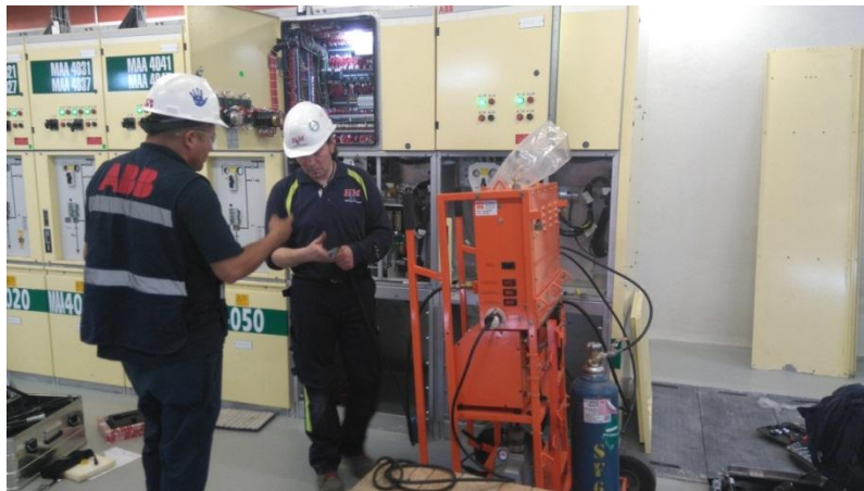
Figura. 26 Instalación de cable de control en tablero Metalclad de 15kV e instalación de gas SF6.
