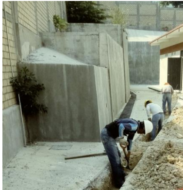
Figura. 14 Excavación para banco de ductos
