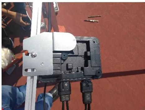
*Fig. 3.14 Micro inductor Enphase modelo IQ6+.*
