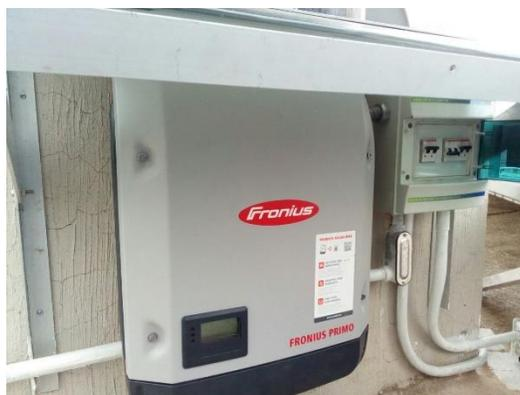
*Fig3.13 Inversor central de la marca Fronius.*
