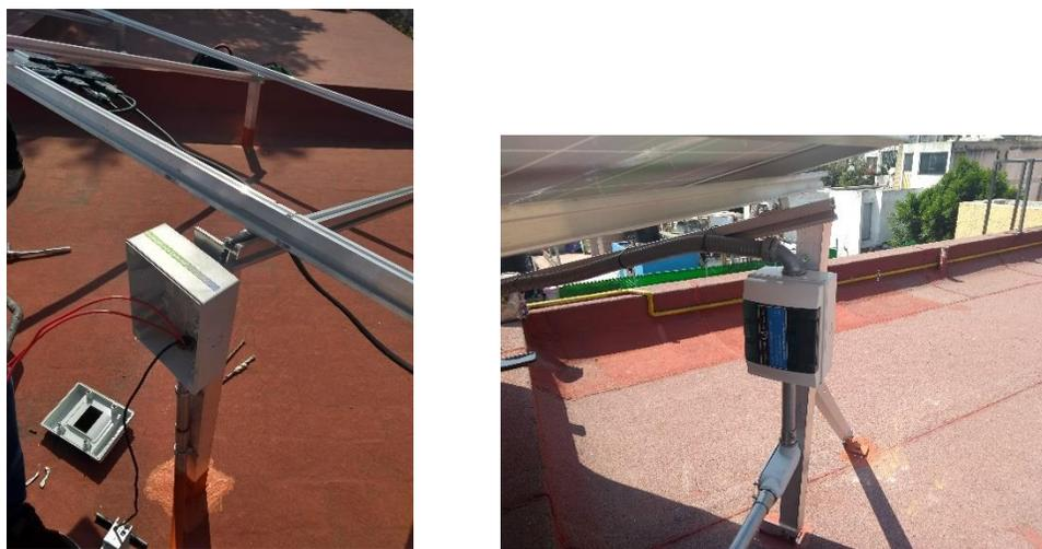
*Fig. 3.10 Caja mistral para 7 módulos solares.*
