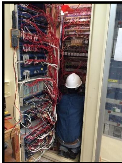
**Fig.3.21** Cableado de las corrientes y voltajes.
