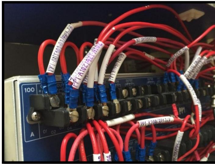
**Fig.3.28** Cableado del relevador SEL421 tarjeta E/S 100A entradas.
