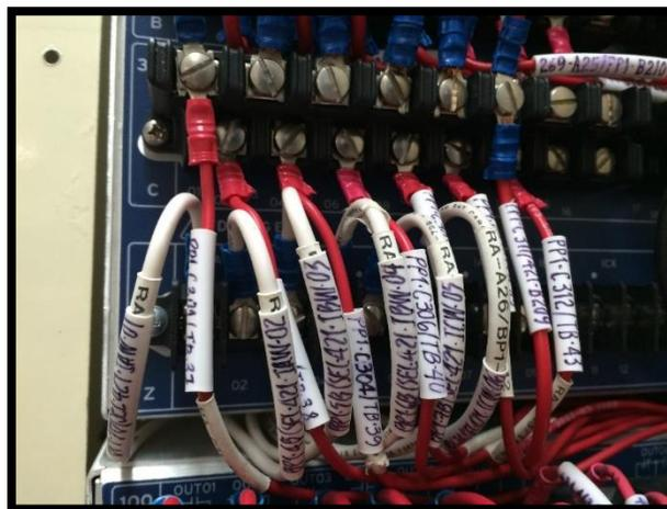
**Fig.3.31 (b)** Conexionado de la tarjeta E/S 300C del relevador SEL421.
