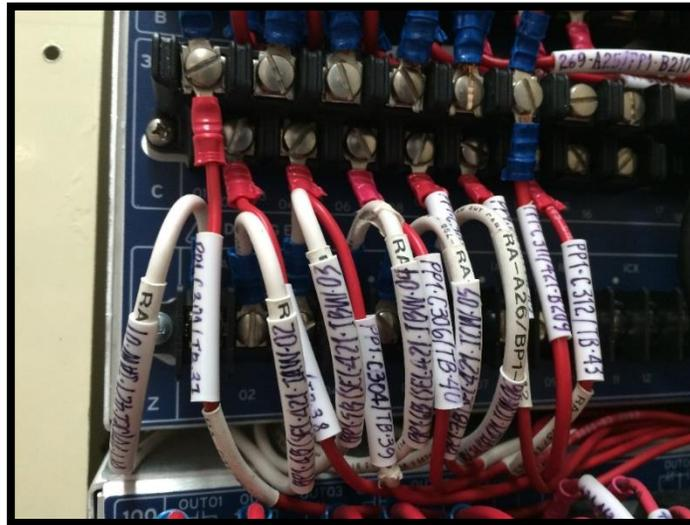
**Fig.3.34 (b)** Conexionado de corrientes de la tarjeta E/S Z del relevador SEL421.
