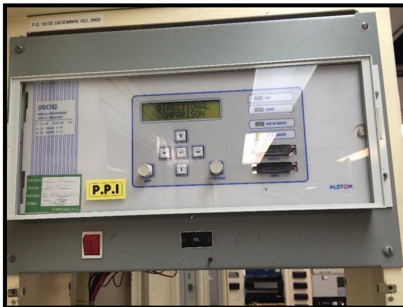
**Fig.3.1** Relevador de comparación direccional LFDC-102 en servicio.
