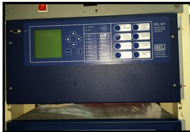
**Fig.3.17** Montaje del relevador SEL421.
