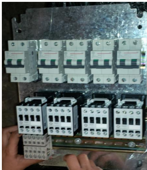
Fig. 3. 10 Colocación de Klemas.
