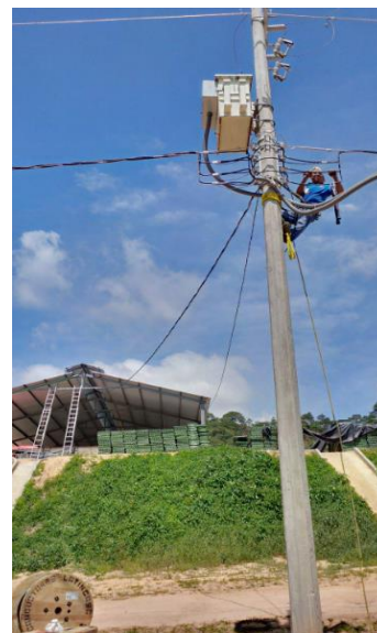
Fig.A1.2 Conexión en baja tensión
