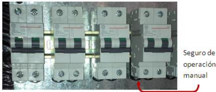
Fig. 3. 8 Fijación de Interruptores Magneto Térmicos.
