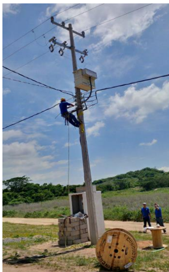
Fig.A1.1 Tendido de acometida
