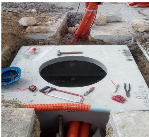
Figura 24 Instalación registro de media tensión arroyo tipo 4
