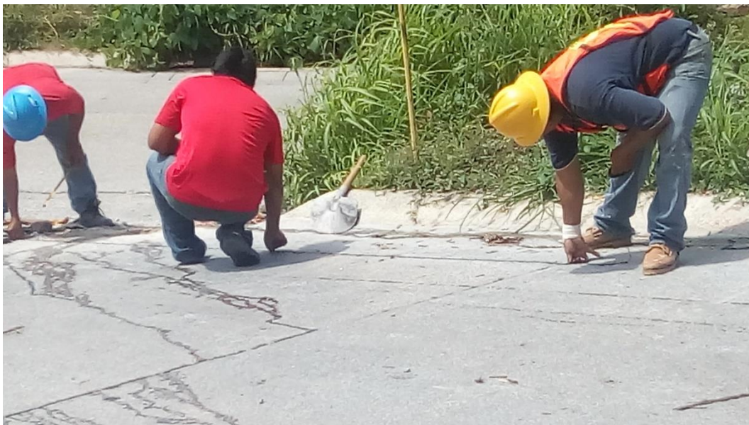
Figura 19 Trazado del área de excavación
