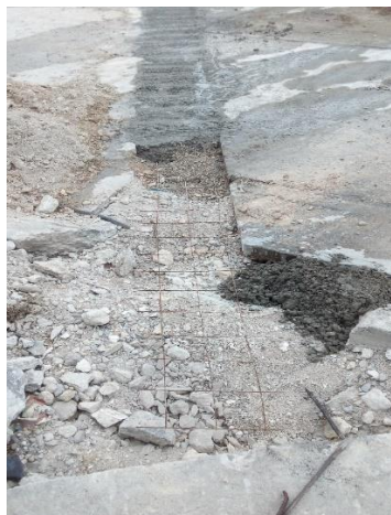
Figura 23 Reposición de Pavimento de Concreto de Arroyo
