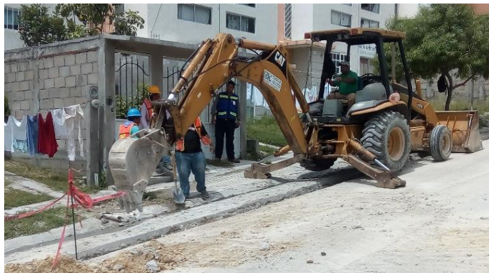
Figura 20 Excavación de cepa de banda de ductos
