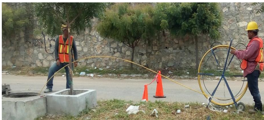
Figura 29 Limpieza, guiado y ratoneado de ductos
