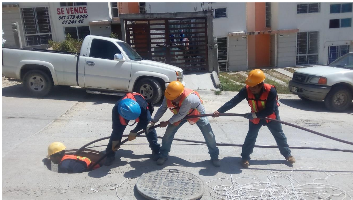
Figura 30 Instalación de cable de energía tipo XLP15 cal 500 kcm de 15 kV.
