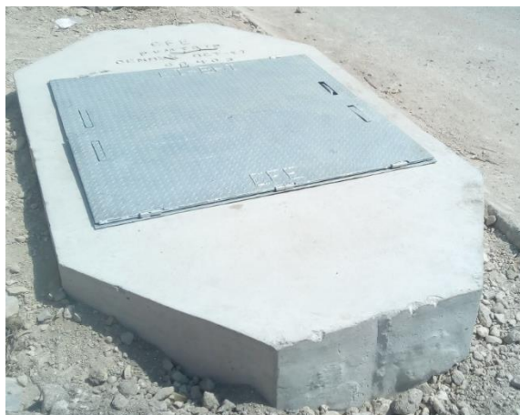
Figura 28 Instalación de tapa abatible de 1.50m. X 1.50m. de lámina antiderrapante
