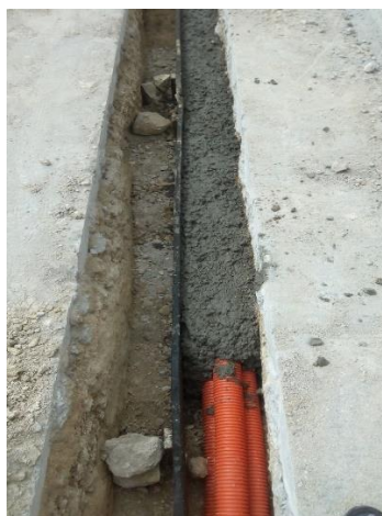
Figura 22 Encofrado de Banco de Ductos 3 vías
