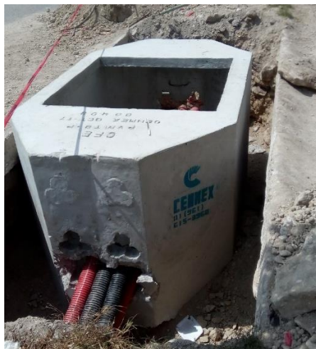
Figura 26 Instalación de pozo de visita de media tensión en banqueta tipo P
