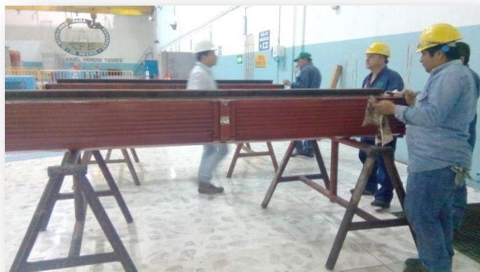
Fig. 3.30. Limpieza a polos desmontados
