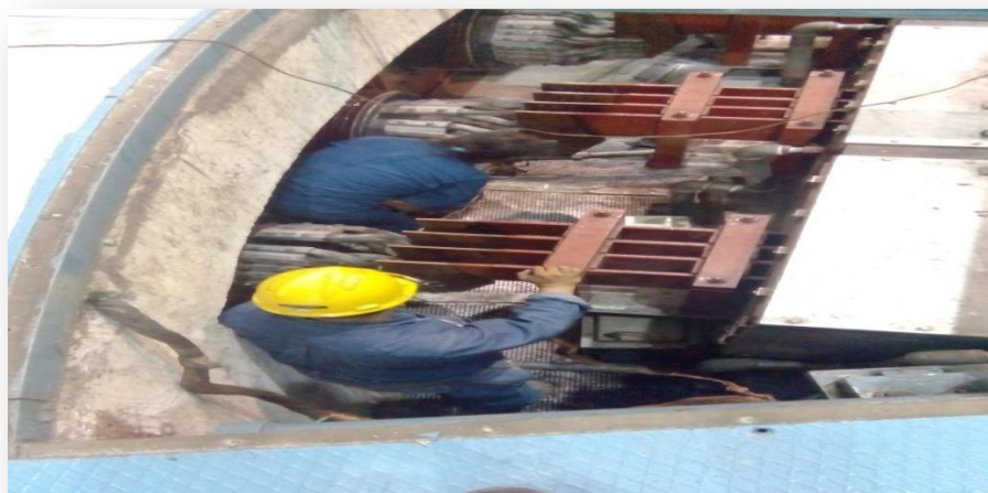
Fig.3.9. Inicio de desconexión de trenzas (fase)
