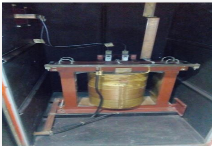
Fig. 3.2. Transformador neutro del generador
