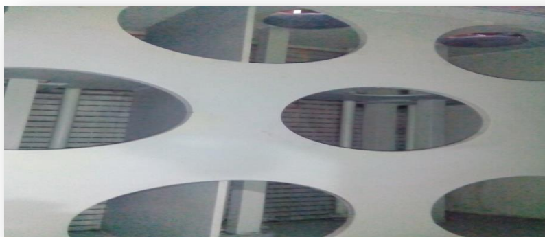
Fig. 3.29. Limpieza huecos de radiadores
