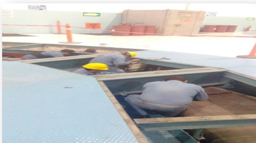
Fig. 3.5. Retiro de tornillos (mampara-tolva)
