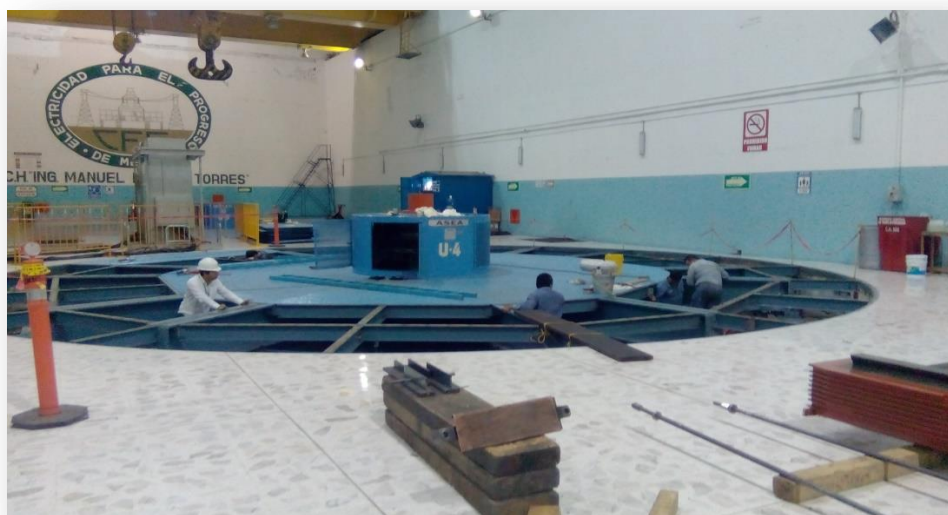
Fig. A.1. Retiro de tapas antiderrapantes
