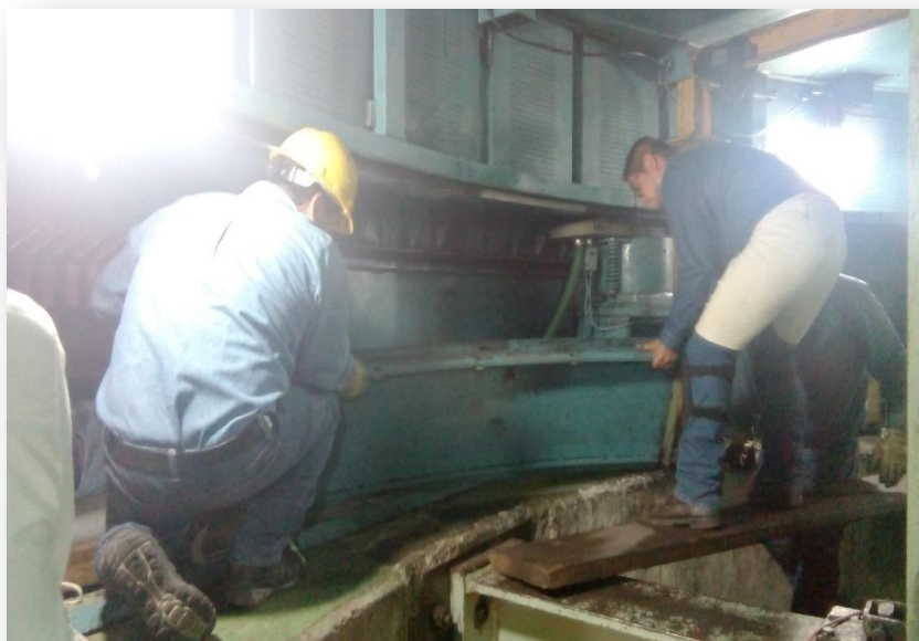
Fig. 3.7. Retiro de mamparas inferiores
