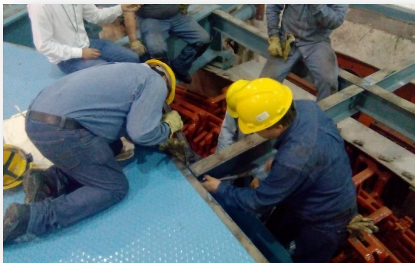
Fig.3.15. Retiro de viguetas
