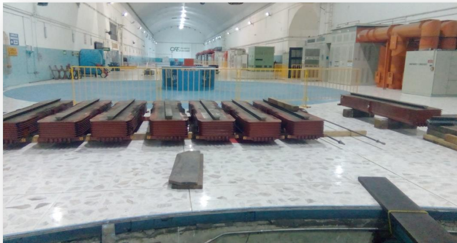
Fig. D.1. Polos desmontados
