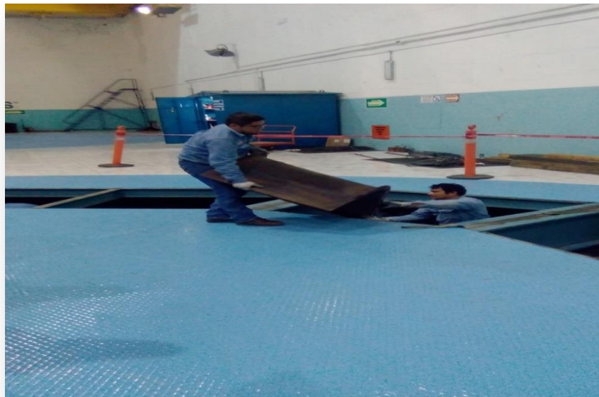
Fig. 3.6. Retiro tolvas superiores
