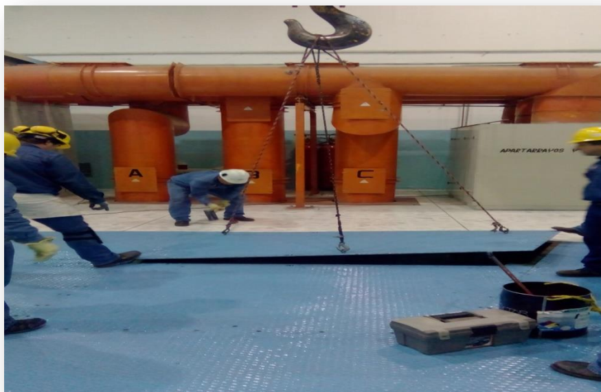
Fig. 3.4. Retiro de tapas antiderrapantes
