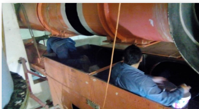
Fig. 4.6. Bus de fase aislada
