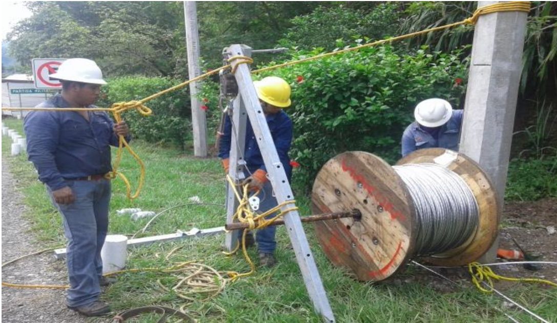
Fig. 3.16 Tendido de líneas
