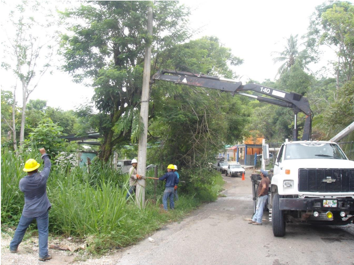
Fig. 3.9 cara y plomeado de poste
