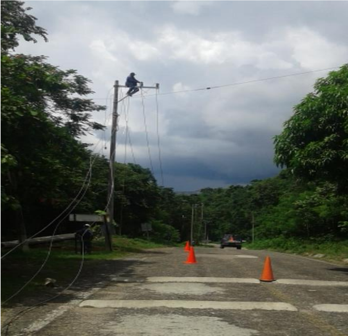
Fig. 3.18 Tendido de líneas
