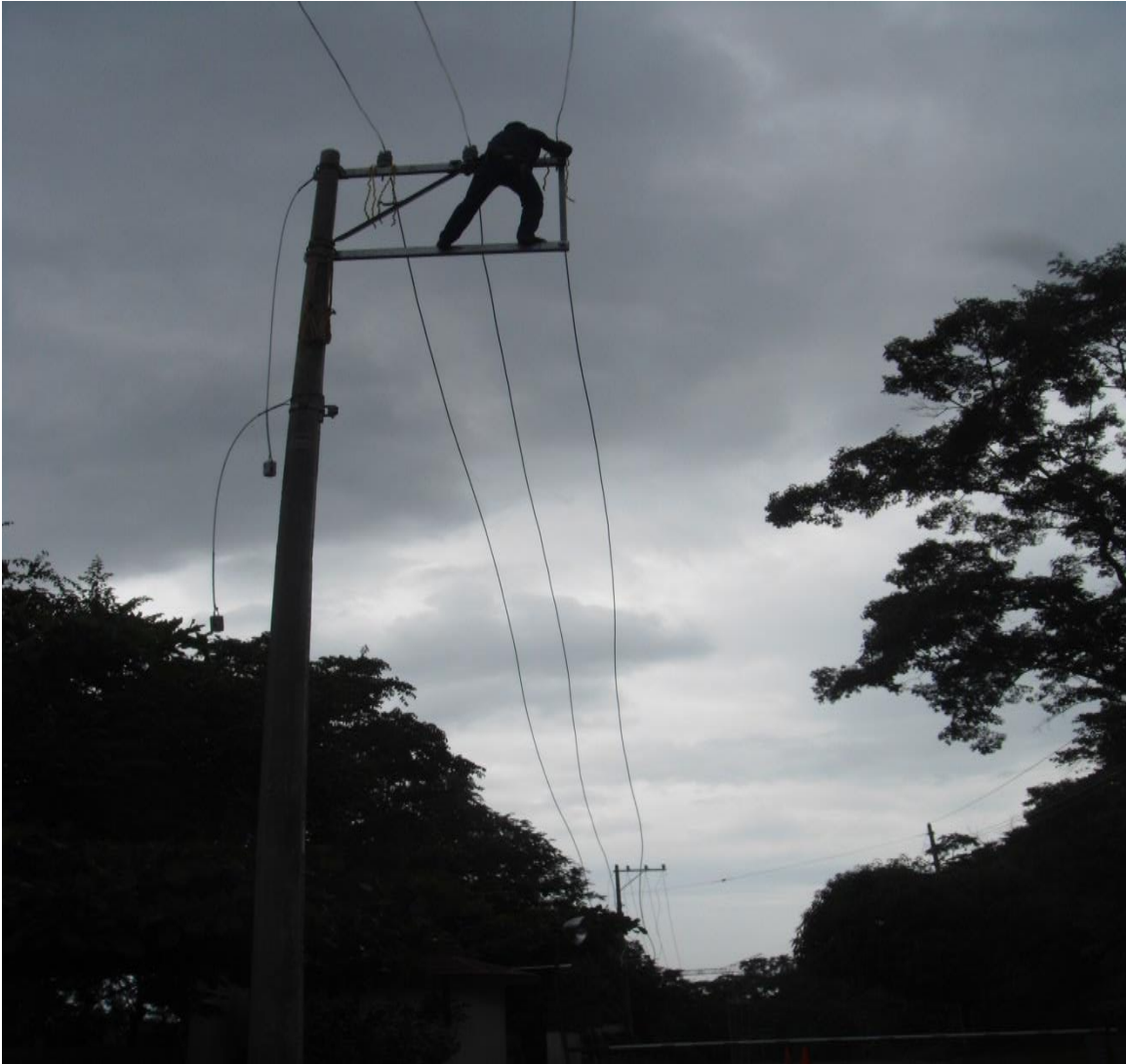
Fig. 3.19 Tendido de líneas
