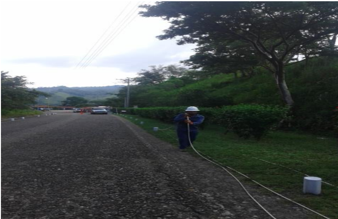
Fig. 3.17 Tendido de líneas
