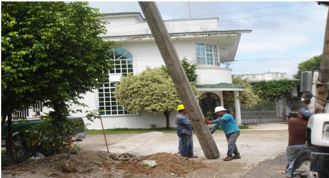
Fig. 3.8 colocación de postes
