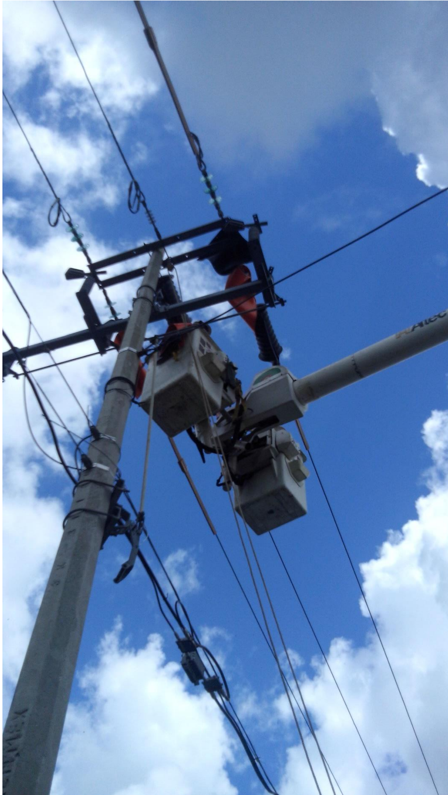
Fig. A.4 cubriendo líneas para cumplir con el reglamento de seguridad.
