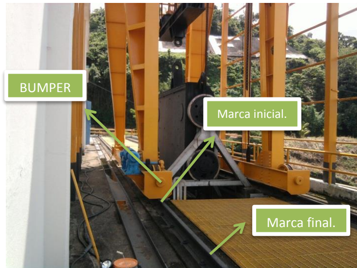
Ilustración 20. Marcas de referencia para la medición de la velocidad de traslación del pórtico.
