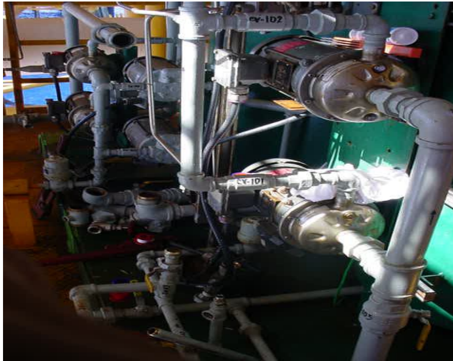
Figura 3.3 bombas de proceso normal
