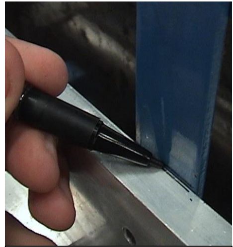
Figura 54. Usar marcador para marcar donde estaban las guías.
