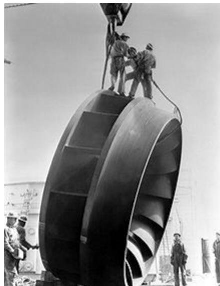
Fig. 2. Rotor de una turbina Francis.
