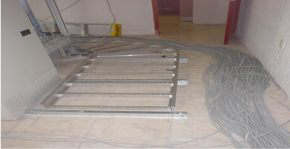
Armado de las escalerillas que se colocaran en la planta alta del edificio.
