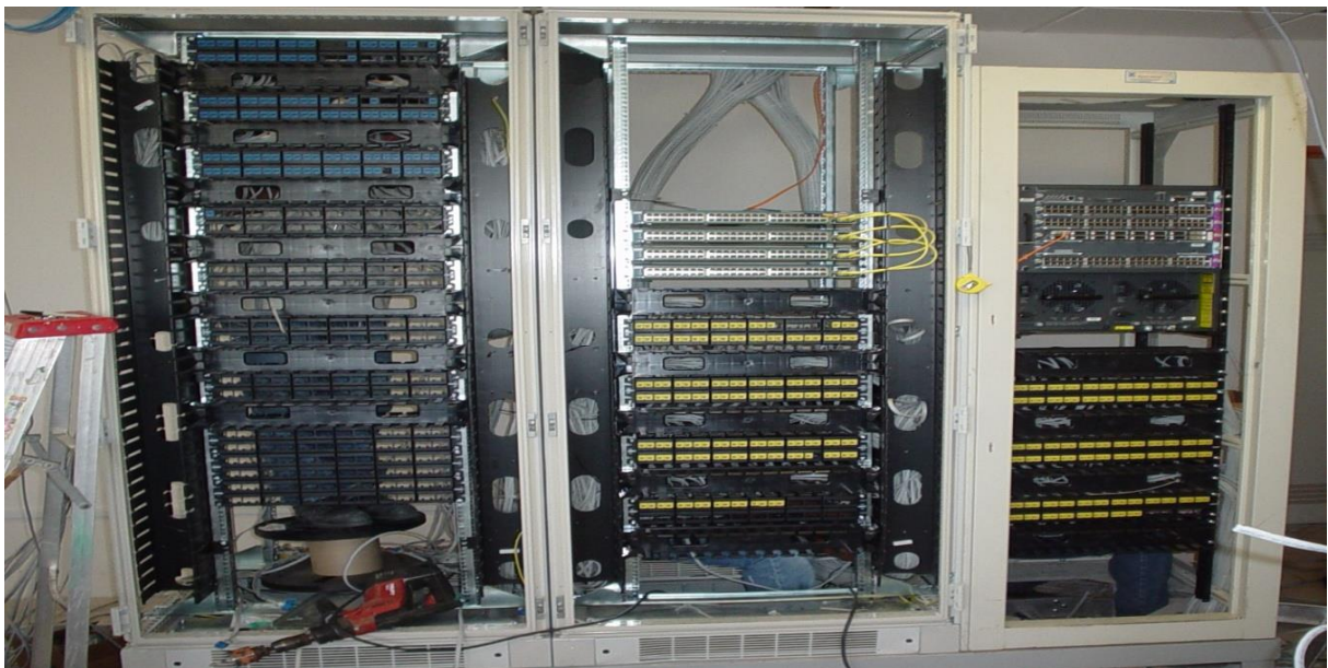
Construcción de los rack en el SITE del edificio.
