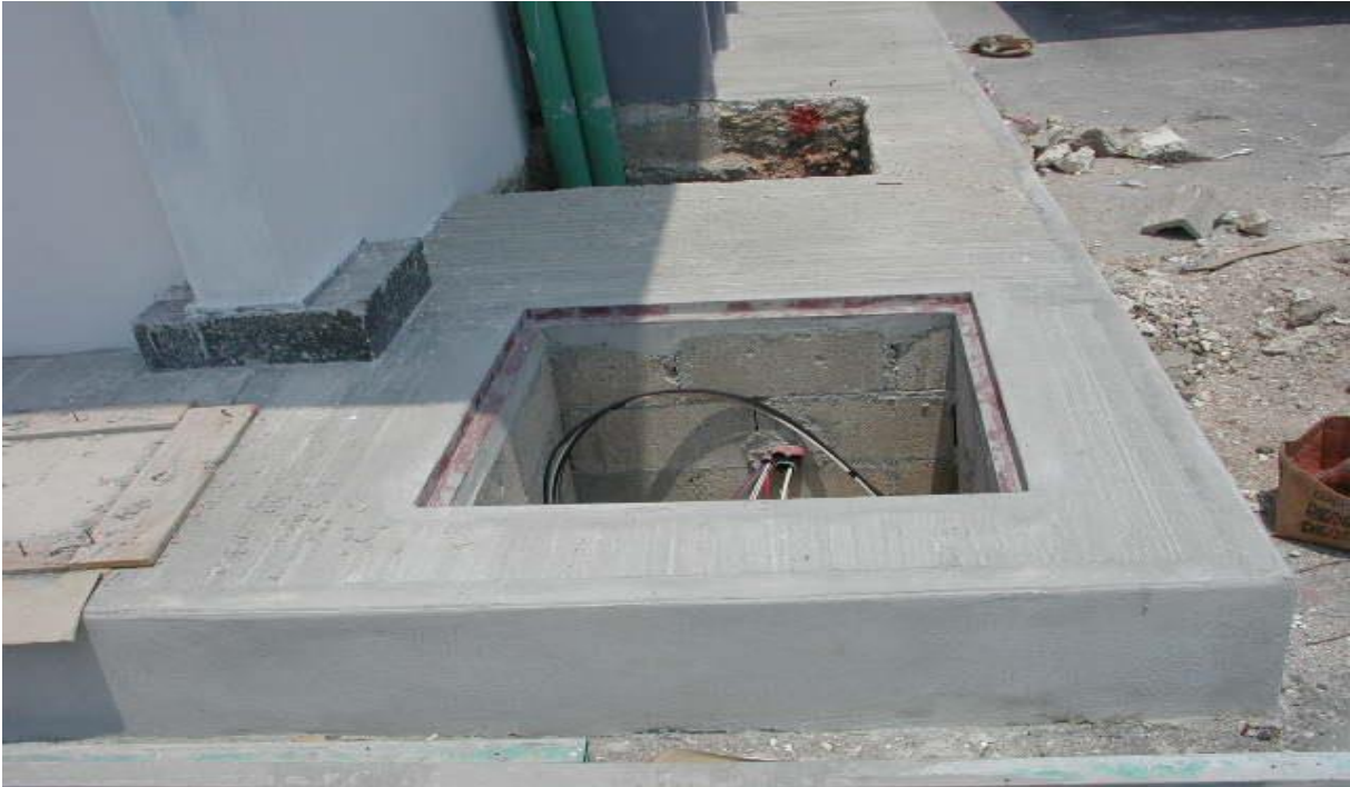
Acceso por donde se introdujo la fibra óptica dentro del edificio.
