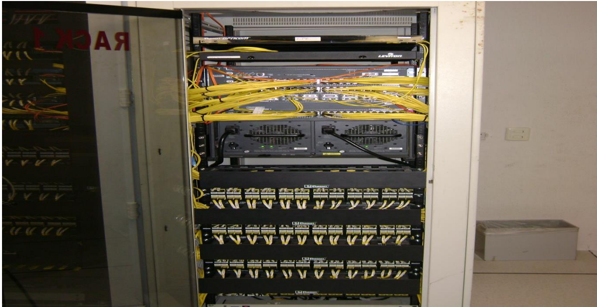
Instalación de los cables en el rack n° 1.
