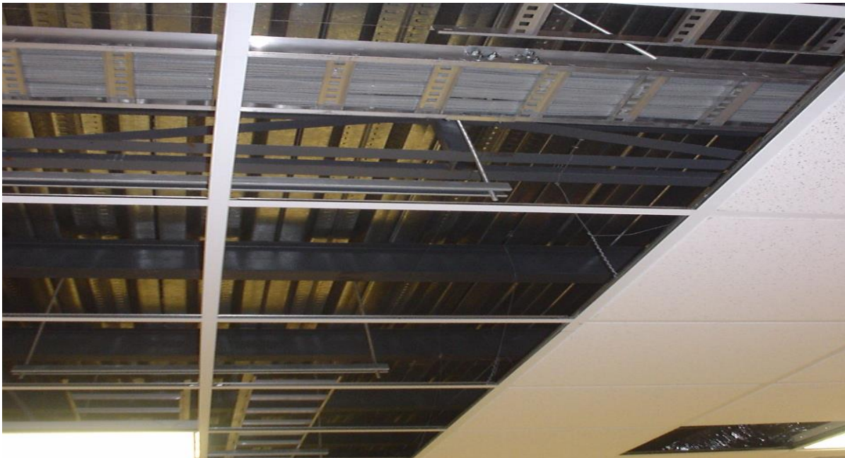
Cables instalados listos para realizar el cableado de las ingenieriza en la planta alta del edificio.
