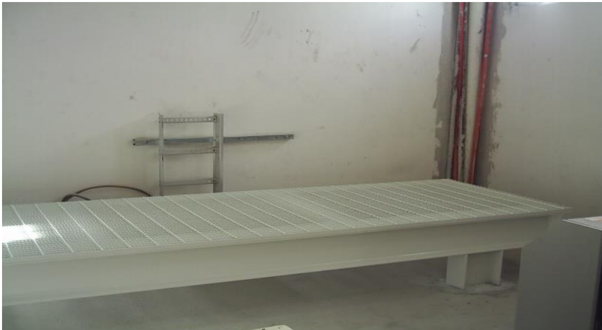
Lado izquierdo de la base en donde será instalado el banco de baterías.
