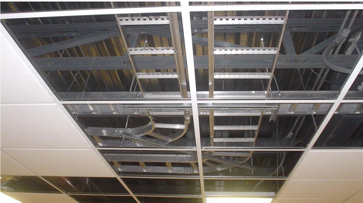
Escalerillas instaladas en el edificio.
