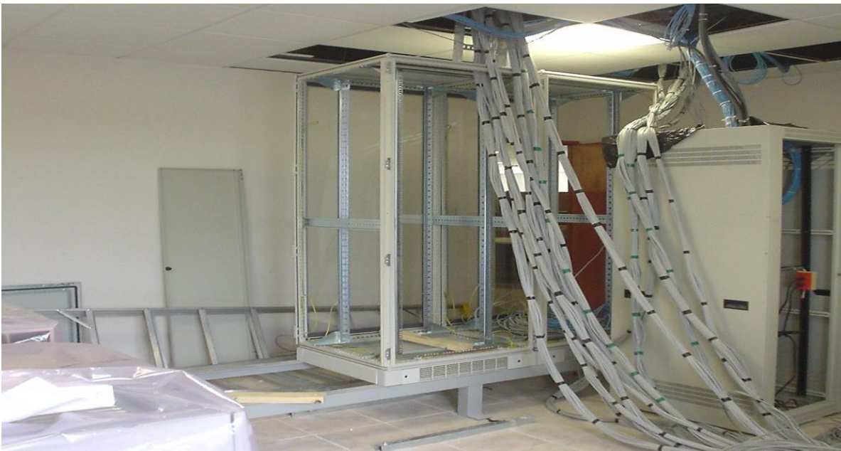
Instalación de los cables ya separados en la escalerilla del SITE
