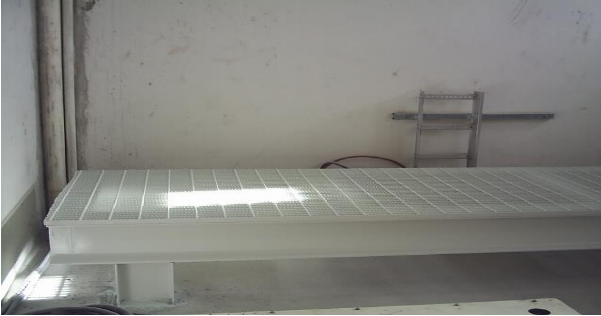
Lado derecho de la base donde será instalado el banco de baterías.
