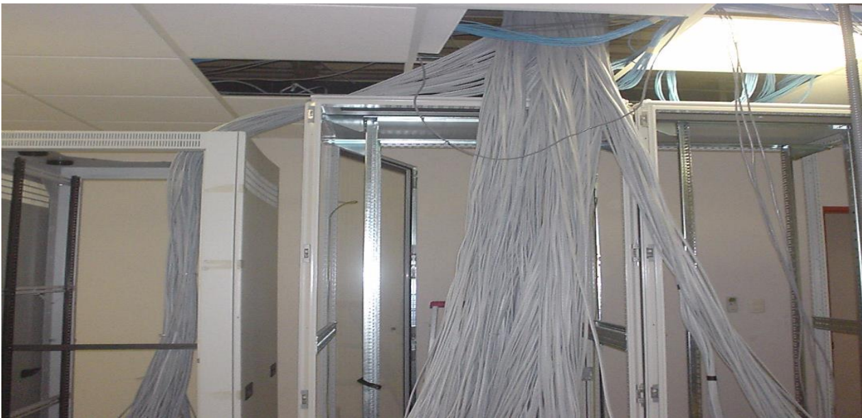
Instalación de los cables en la planta alta.
