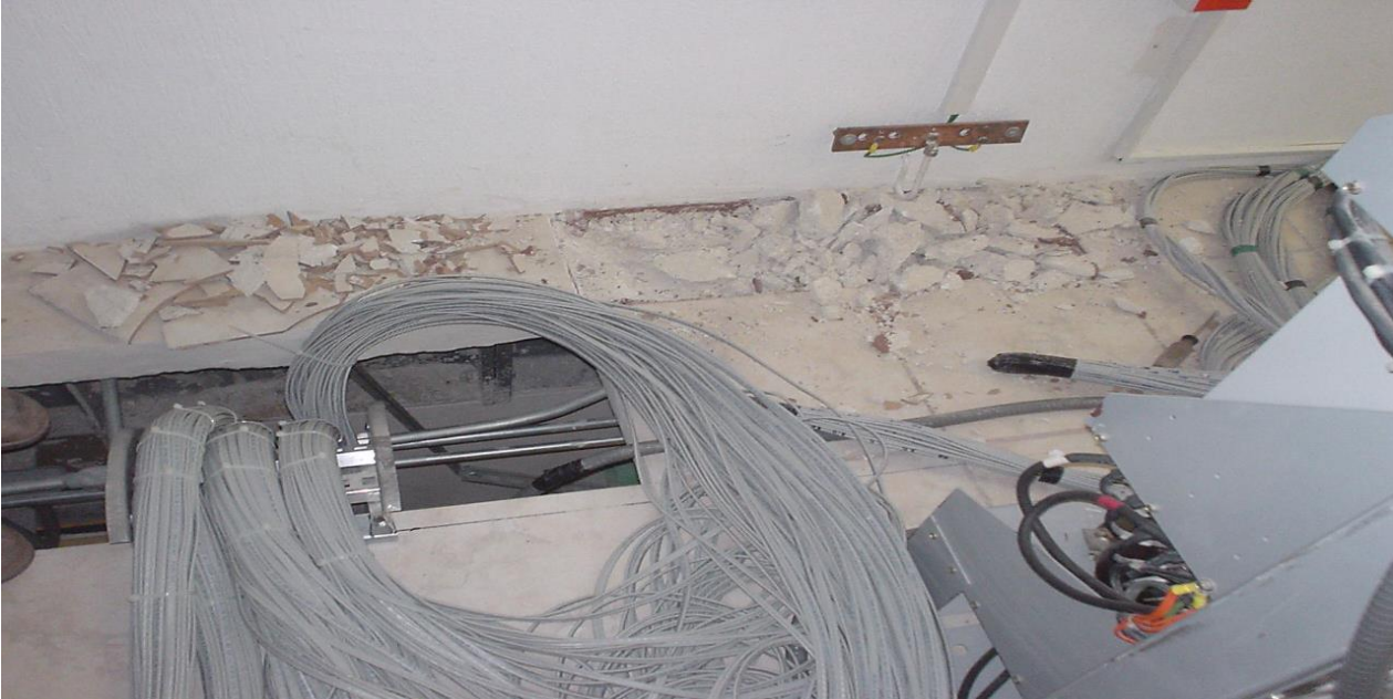
Colocación de los cables hacia la planta baja del edificio.
