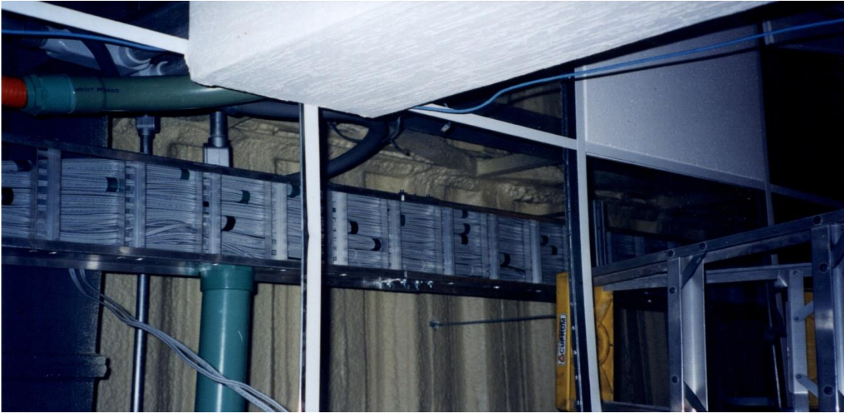
Cables instalados en las escalerillas de la planta baja.
