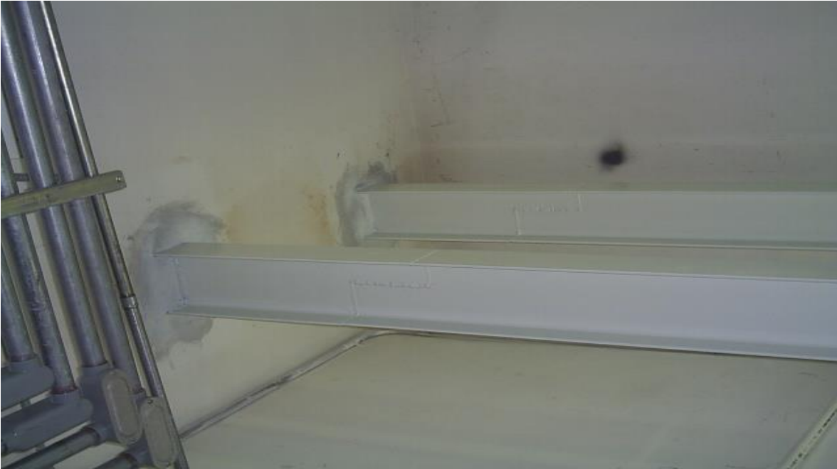
Reforzamiento del área donde será instalado el banco de batería.
