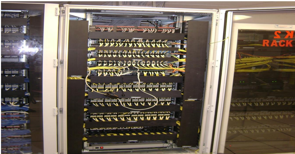
Instalación de los cables en el rack n° 2.
