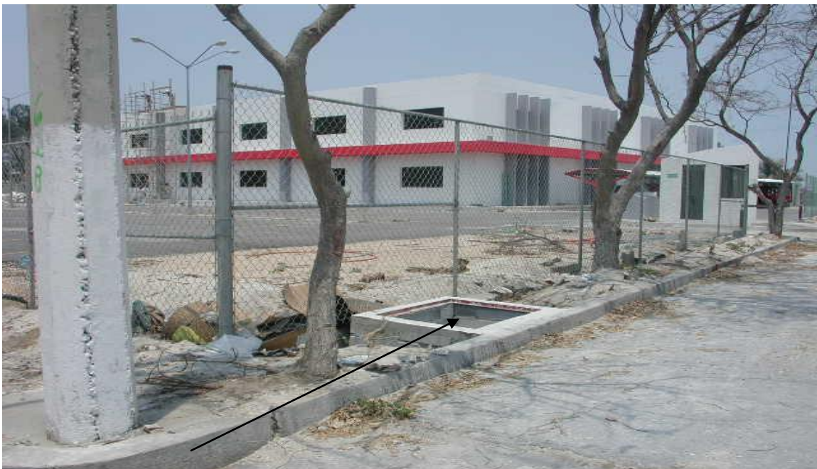
Parte de atrás del edificio por donde se introdujo la fibra óptica.
