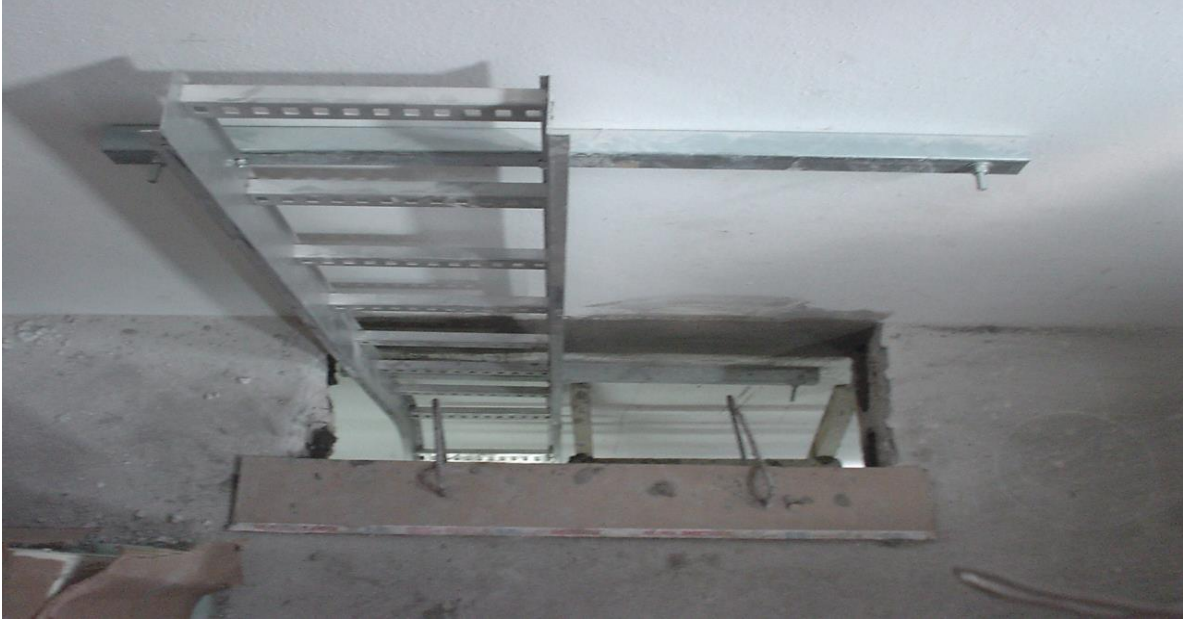
Colocación de las escalerillas hacia la planta baja.
