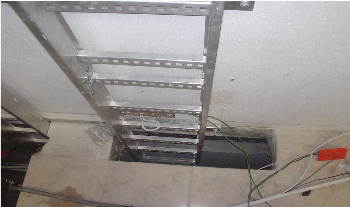
Colocación de las escalerillas de la planta baja.
