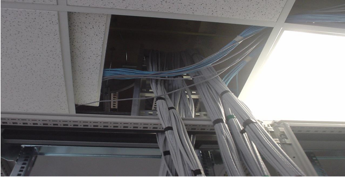
Instalación de los cables utp.
