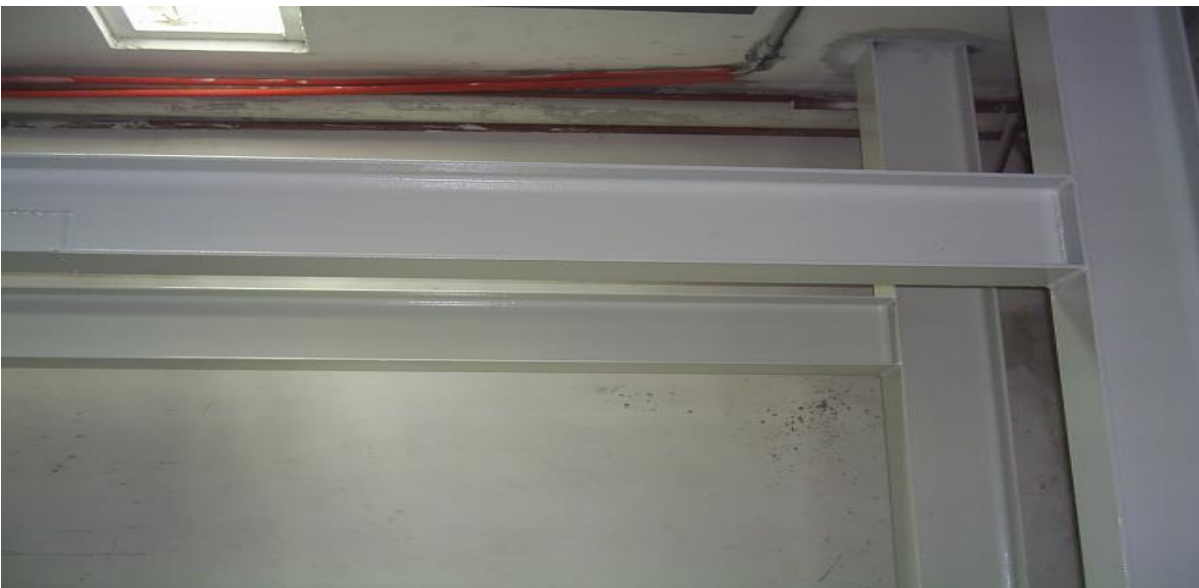
Reforzamiento del área donde será instalado en banco de batería.
