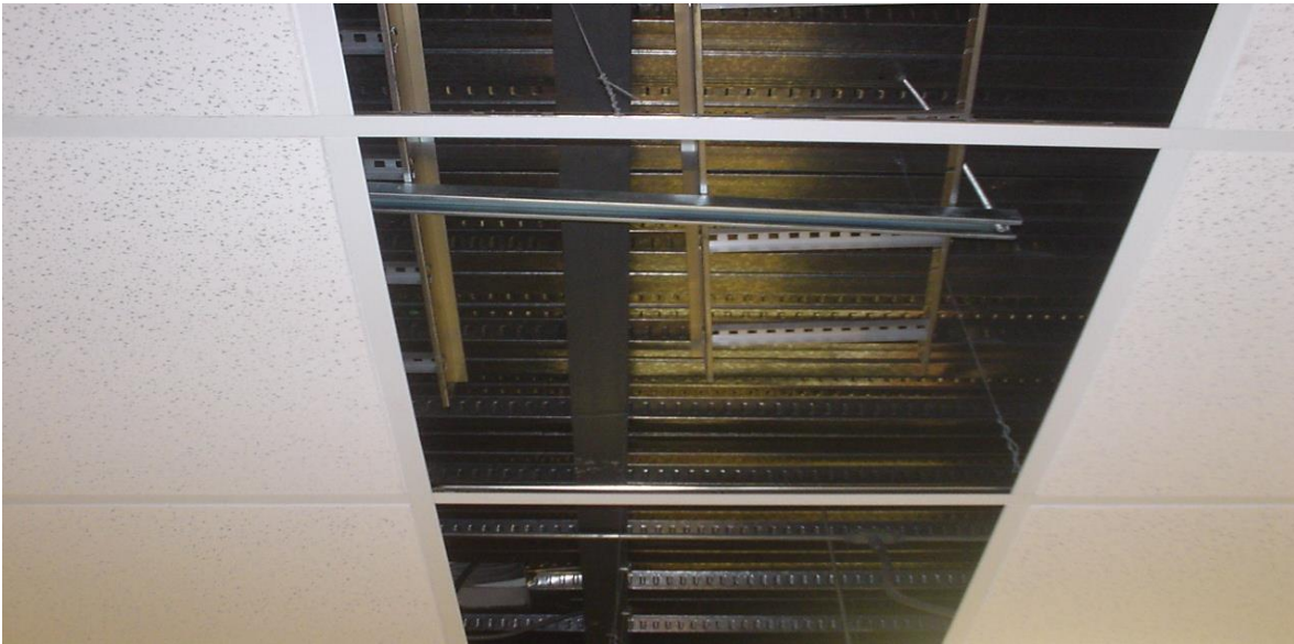
Instalación de las escalerillas en la planta alta del edificio.
