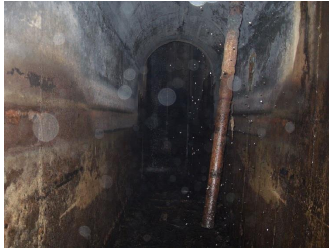
Fig. 6. Galería de inspección del cárcamo segunda etapa
