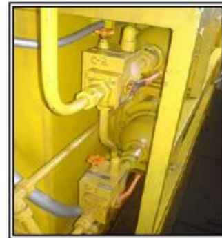
Fig. 4.13 Válvula de seccionamiento 35.2 normalmente
