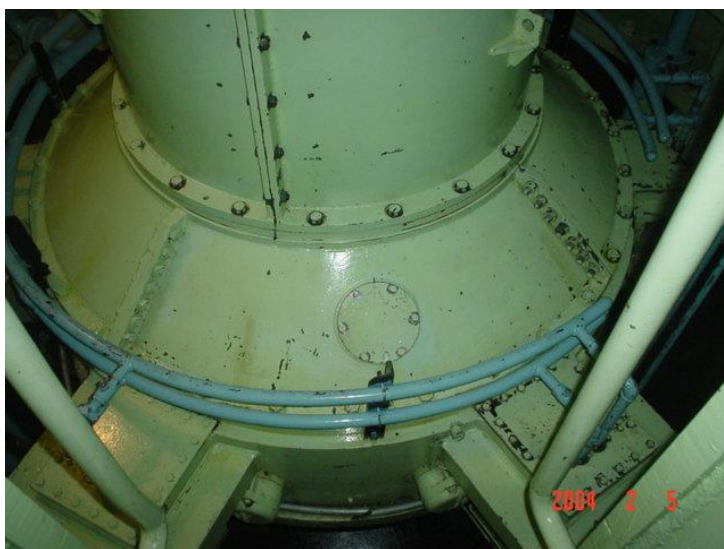
Fig. 3.28 Chumacera guía turbina
