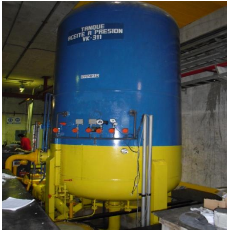
Fig. 3.32 Tanque vk 311(aceite a presión)
