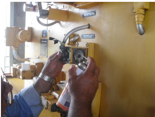
Fig. 4.43 Limpieza a la válvula 12.2 de Max. Presión para apertura
