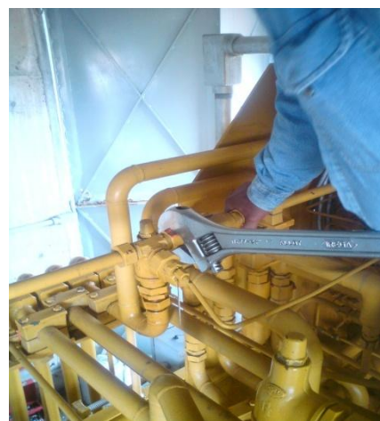
Fig. 4.41 y 4.42 Cambio de válvulas de control de flujo con check integrado
