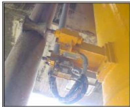
Fig. 4.8 Inicio del izaje de la compuerta
