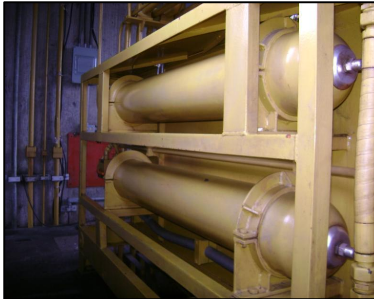
Fig. 4.31 Cilindros n. 3 y 4 del sistema oleodinámico
