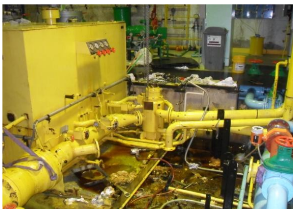
Fig. 3.31 Desmontaje del sistema de regulación de velocidad
