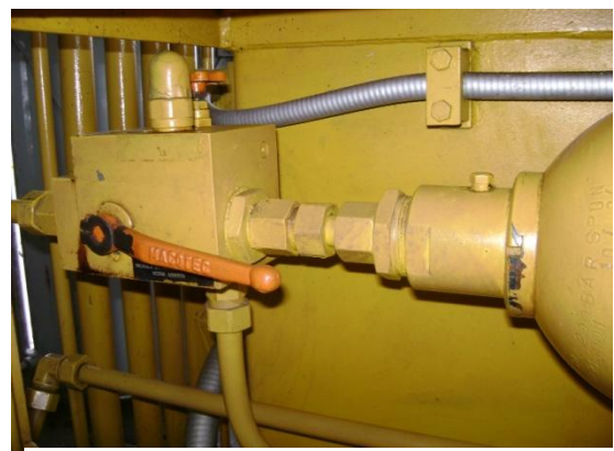
Fig. 4.34 Bloque de cierre del acumulador
