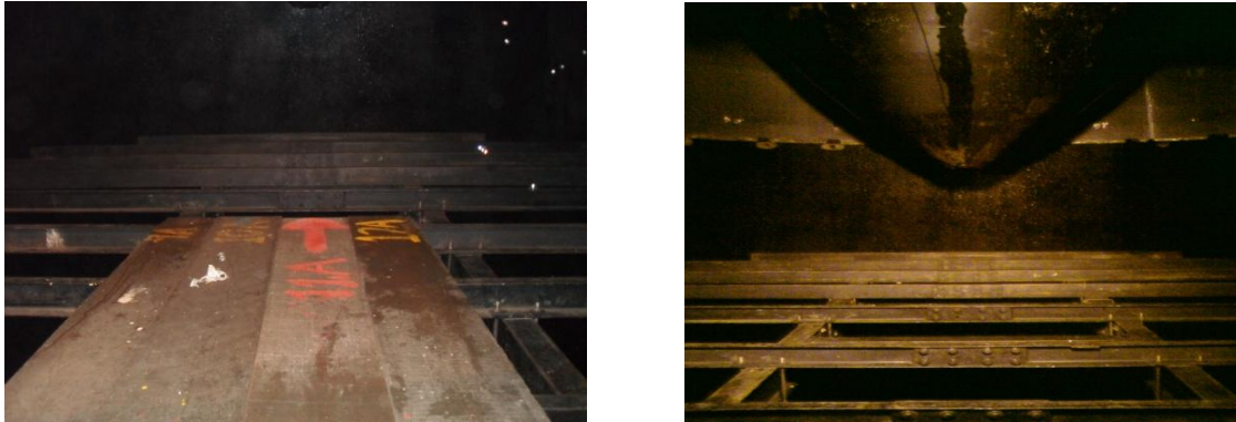
Fig. 3.6 y 3.7 Andamio al interior del foso de turbina
