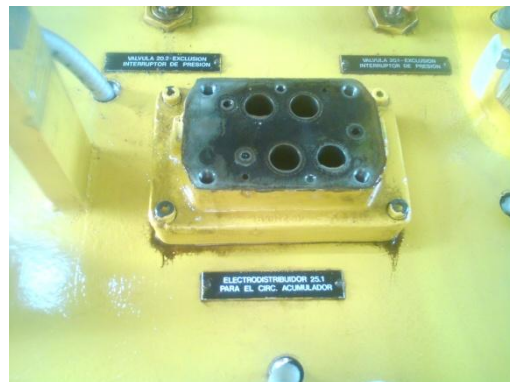
Fig. 4.44 limpieza al electrodistribuidor 25.1
