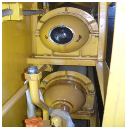
Fig. 4.38 Vista del acumulador Dentro del cilindro
