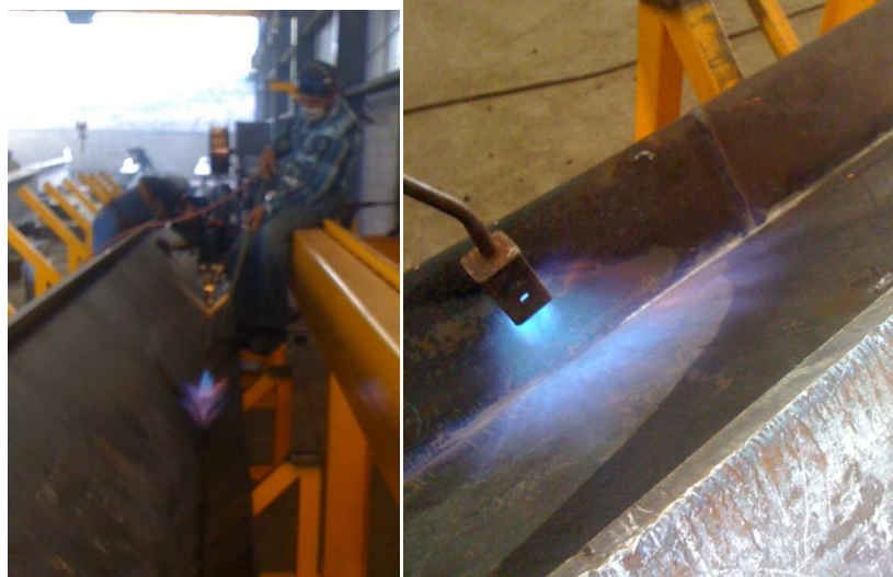
Calentamiento y eliminación de humedad
