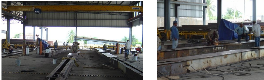
Fig. 7.23. Preparación de las piezas habilitadas para el armado
