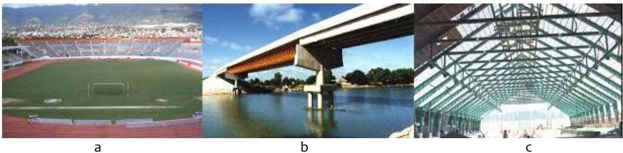
Figura 1. a) estadio de fut-bol, Víctor Manuel Reina, en Tuxtla Gutiérrez b) Puente Paso Chiapaneco, en Villaflores c) Mega bodega BYATSA en Salina Cruz, Oaxaca
