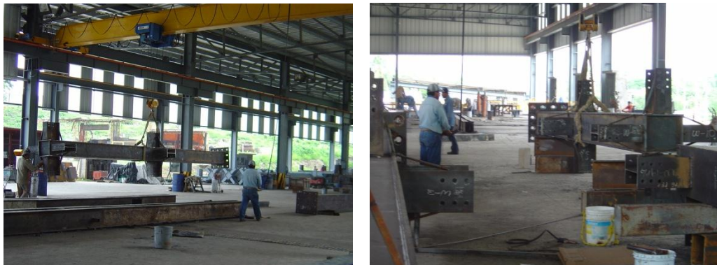
Fig. 7.23. Columna llevada al área de soldadura
