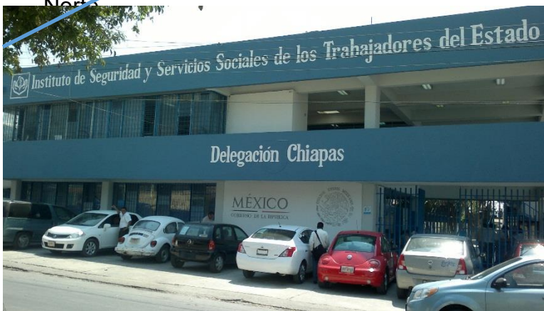
Fig.2 – (Parte superior, Ubicación geográfica de la Delegación ISSSTE Chiapas, Parte Inferior, Edificio de la Delegación ISSSTE Chiapas.)
