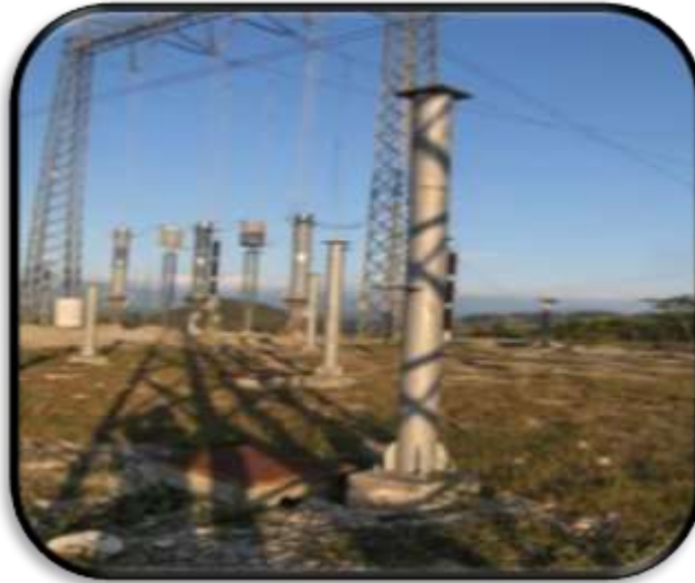
Foto 19. Montaje de base soporte para cuchillas tipo pantógrafos
