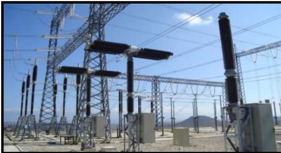
Foto 17. Montaje de interruptores de potencia 400 kV en fases A y B en la bahía A0T30.
