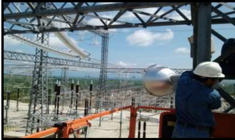
Foto 15. Personal eléctrico de CFE instalando alumbrado a bahía A0T30
