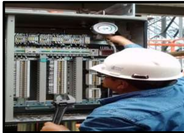
Foto 18. Personal llevando a cabo reposición de gas SF 6
