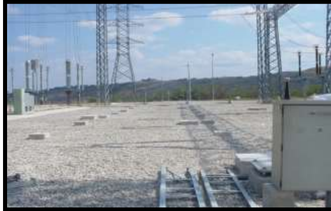
Foto 13. Cimentación y montaje de equipo eléctrico primario en bahía A0T30
