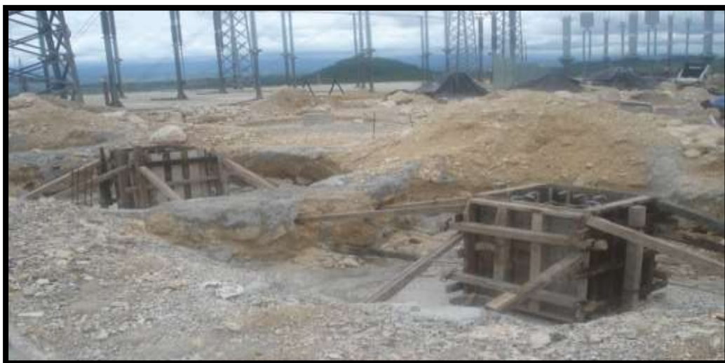
Foto 12. Cimentación para estructuras de bahía A0T30.
