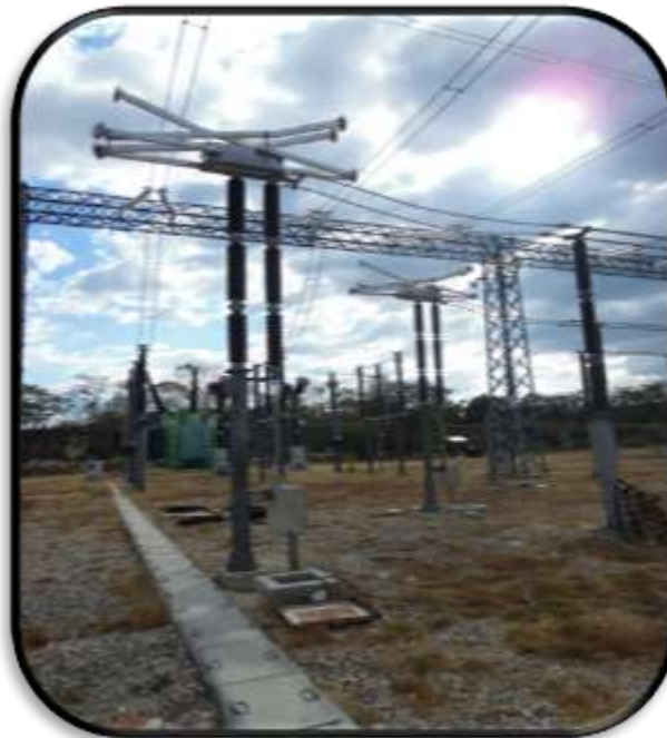
Foto 20. Cuchilla 400 kV tipo pantógrafo montado en bahía A0T30
