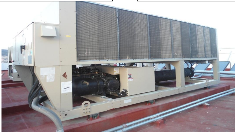
Fig. 8.2.2 Equipo chiller.
