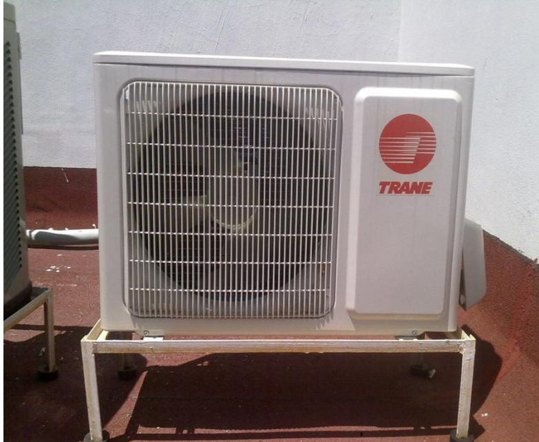
Fig. 8.7.2 Unidad exterior de mini split
