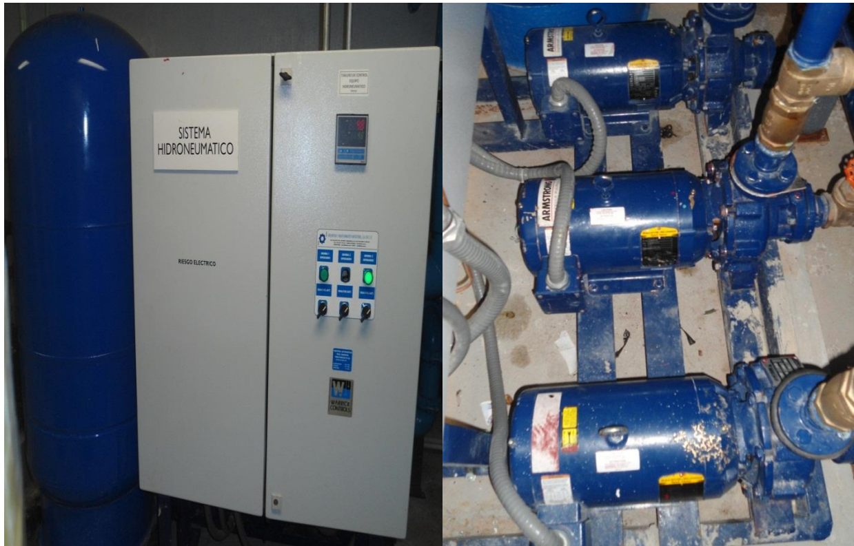
Fig. 8.1.2. Sistema hidroneumático triplex
