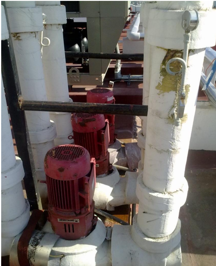
Fig. 8.3.2 Bomba de descarga para los equipos chiller
