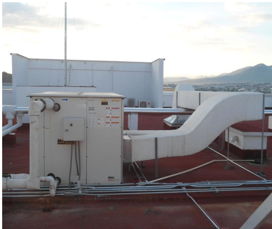
Fig. 8.4.1 Unidad manejadora de aire
