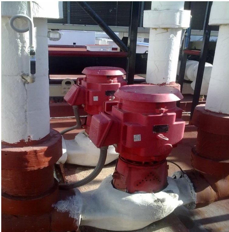
Fig. 8.3.1 Bomba de succión para los equipos chiller.
