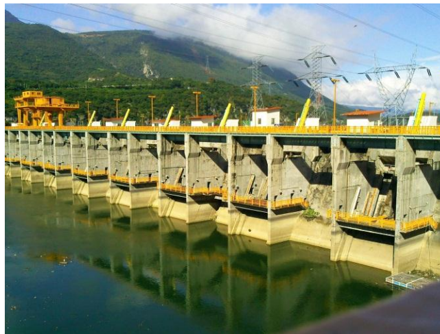
Fig. 1.4 Obra de toma.
