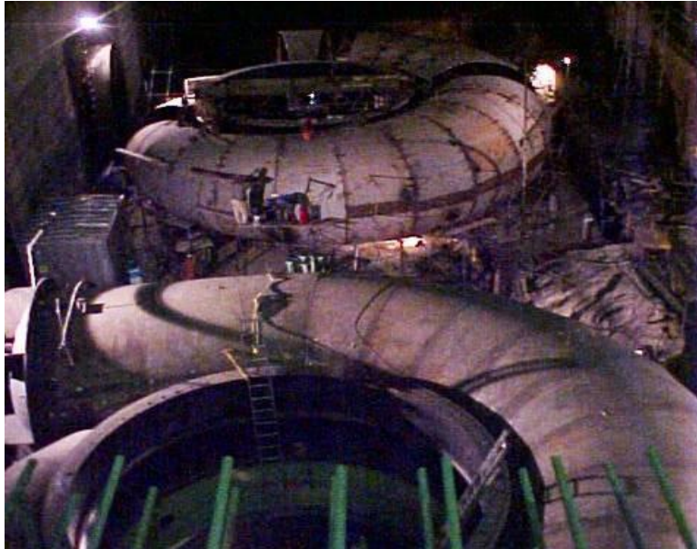
Fig. 1.2 Construcción de la segunda etapa de la C.H. Manuel Moreno Torres.
