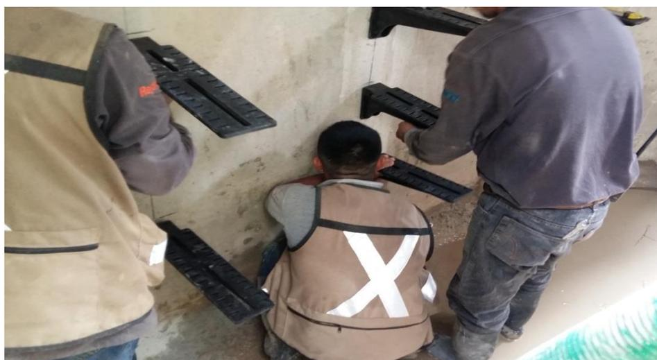
**Fig. 4.14** *instalación de ménsulas*
