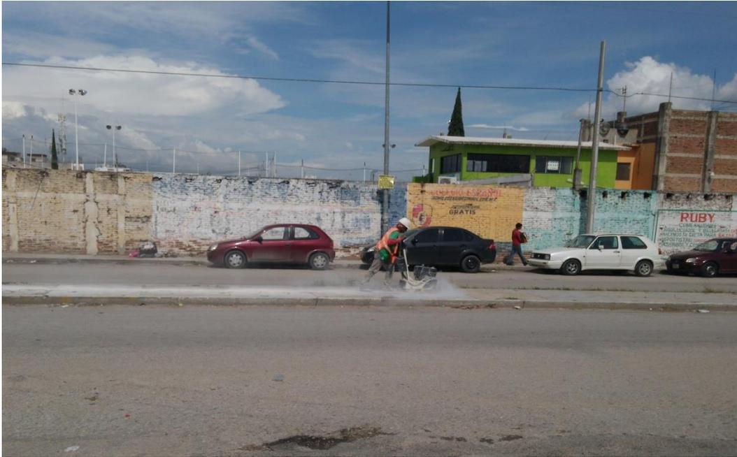
**Fig. 4.6** Corte con disco
