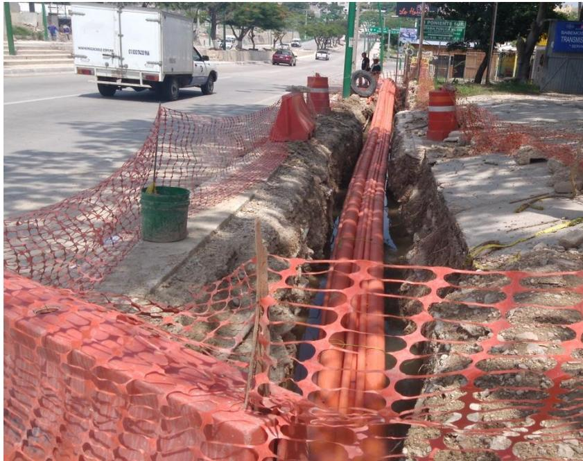
*Fig. 4.1 Ejemplo de una excavación a cielo abierto por medio de zanja*
