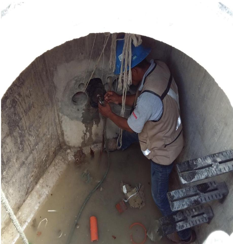
**Fig. 4.15** limpieza de ducto
