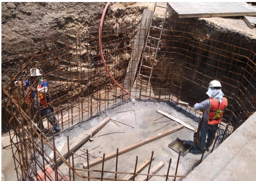
*Fig. 4.11 Montando acero de pozo de visita*
