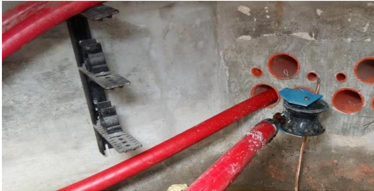
*Fig. 5.9 Jalado de cable pasando por los rodillos*
