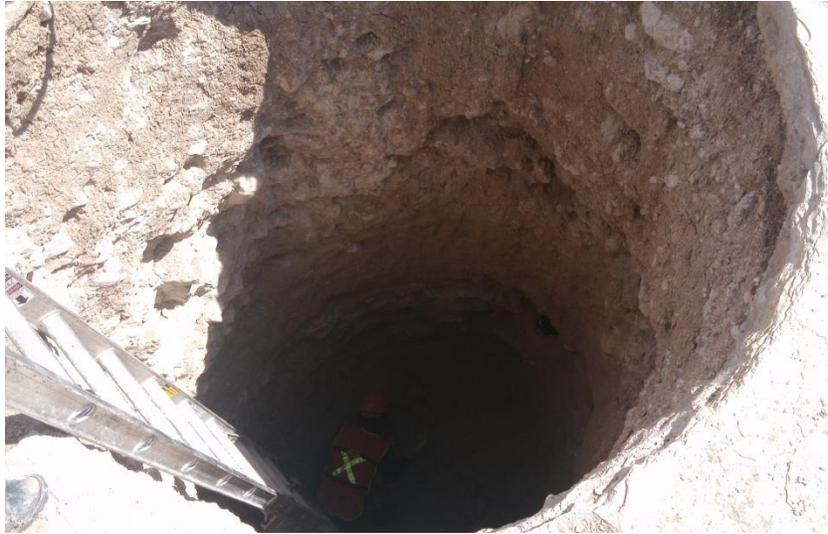
**Fig. 4.17** *Excavación para troncocónico*
