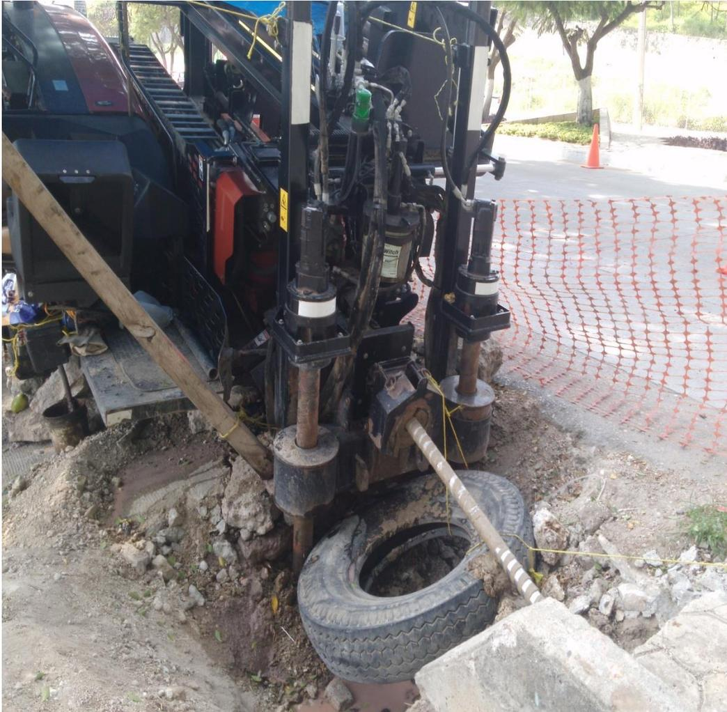
**Fig. 4.5** *Perforación horizontal dirigida*
