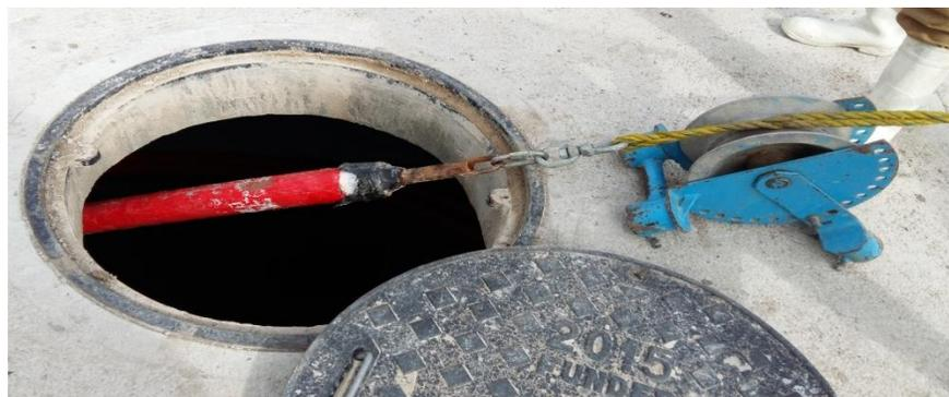
*Fig. 5.8 Jalado de cable por la polea*
