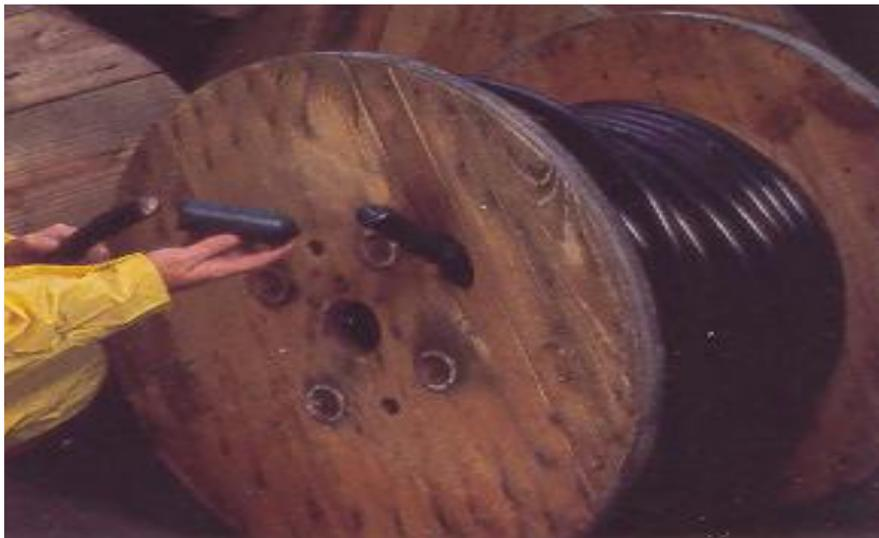
*Fig. 5.1 Verificación del sello termocontráctiles*
