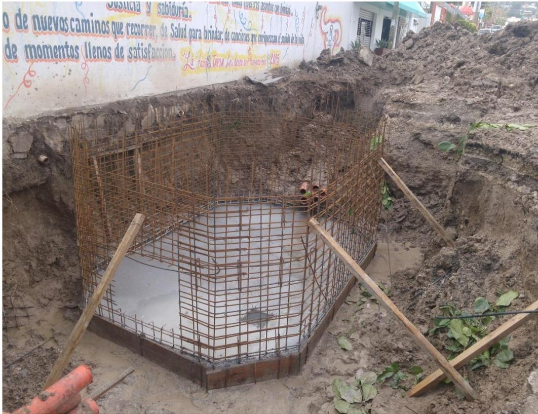
**Fig. 4.8** Registro fabricado en sitio
