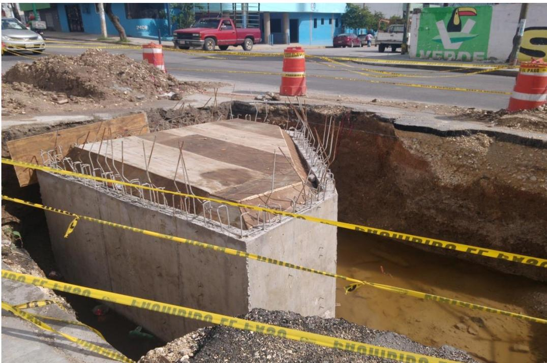
**Fig. 4.9** Registro prefabricado
