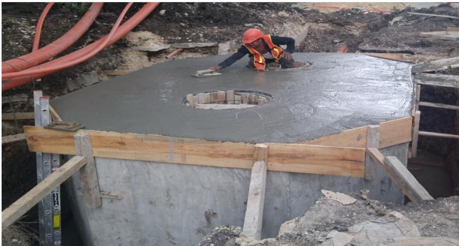
**Fig. 4.13** colado de losa pozo de visita
