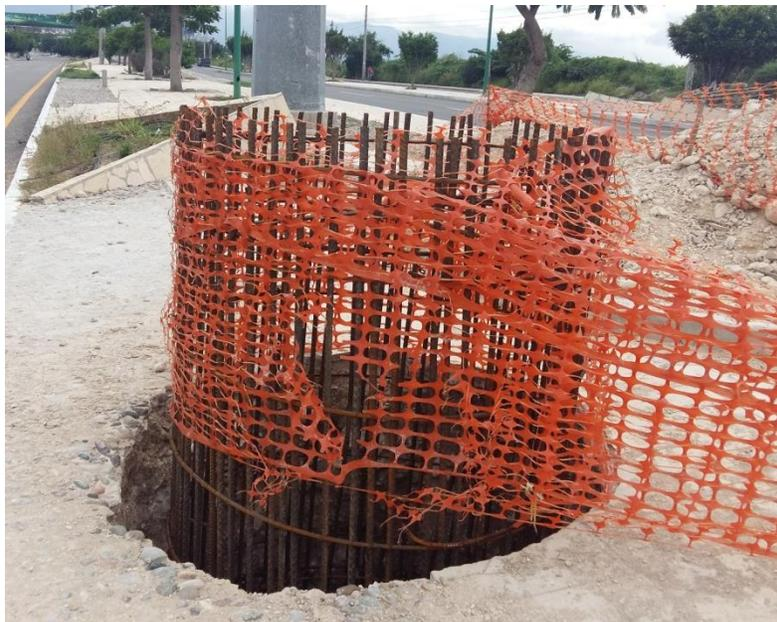
**Fig. 4.18** *Colocación de acero de troncocónico*
