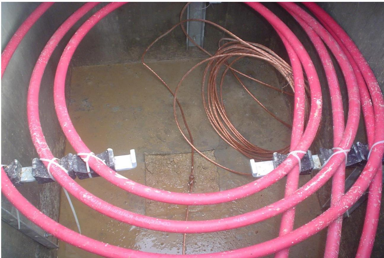
Se utiliza un conductor de polietileno de cadena cruzada (XLP) calibre 1/0 aluminio (AL), 1T-PAD-4, con una configuración de 3F-4H (tres fases cuatro hilos).
