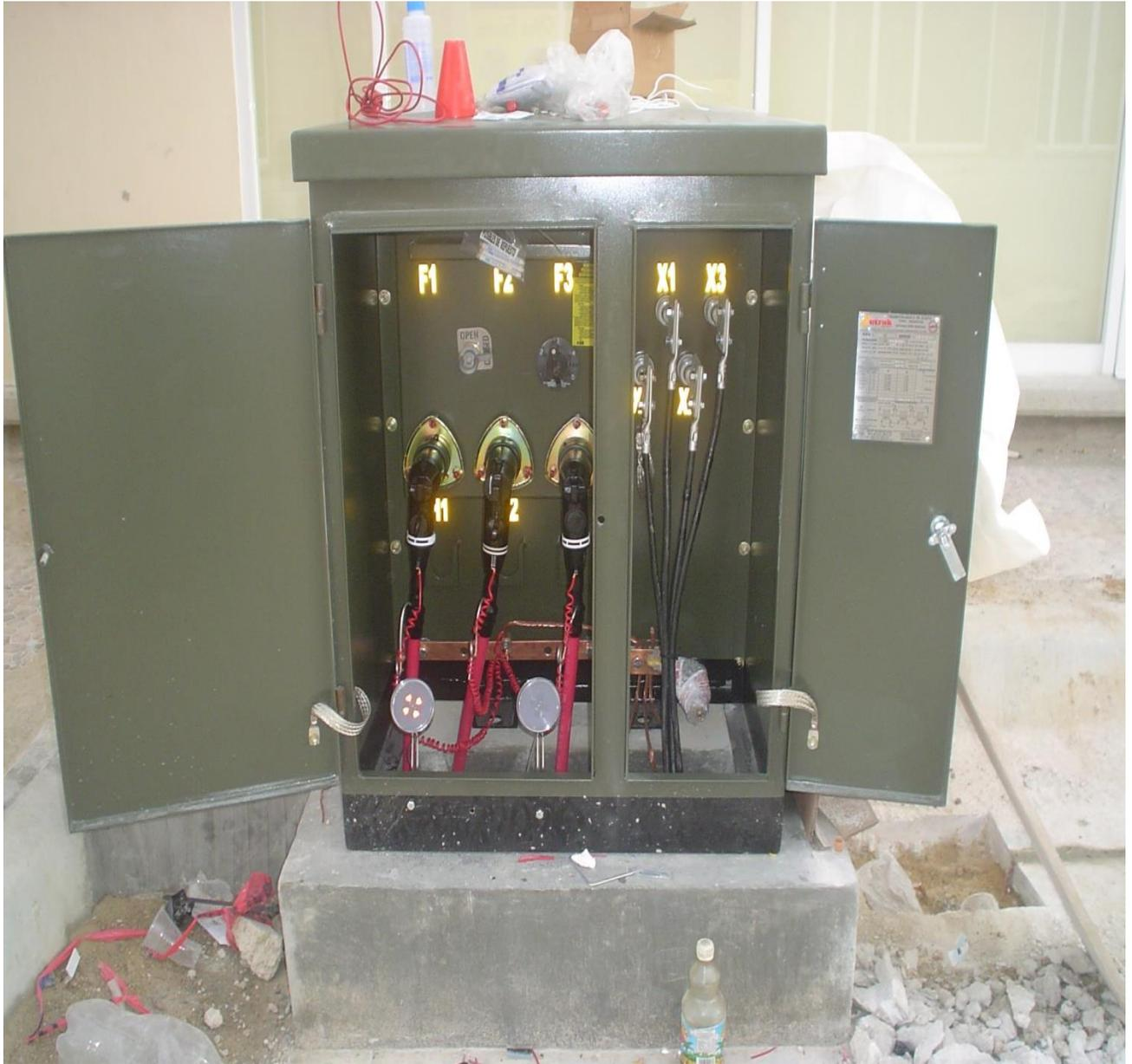
Tenemos como primer elemento en el diagrama unifilar el punto de conexión de entrada que proviene de la línea de media tensión de 13,200 volts, con una configuración de tres fases, tres hilos (3F-3H).
