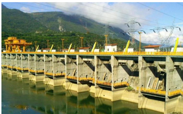
Fig. 1.2 Obra de toma de la C.H. Manuel Moreno Torres
