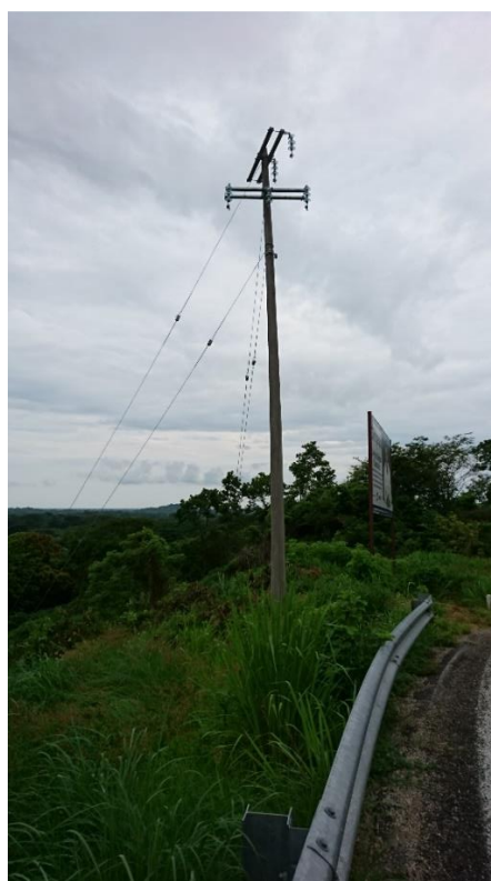
Fig. 4.1.3. Estructura RD3N / RD3.
