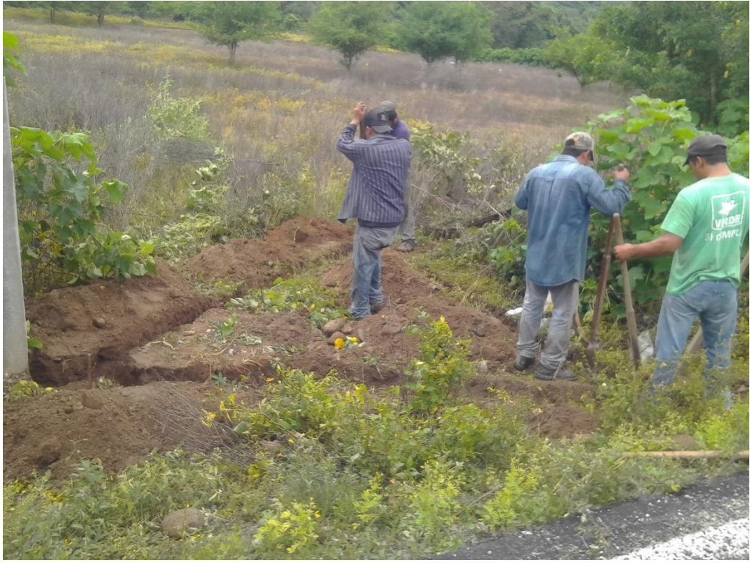
Fig. 14 Delta para colocación de transformador.
