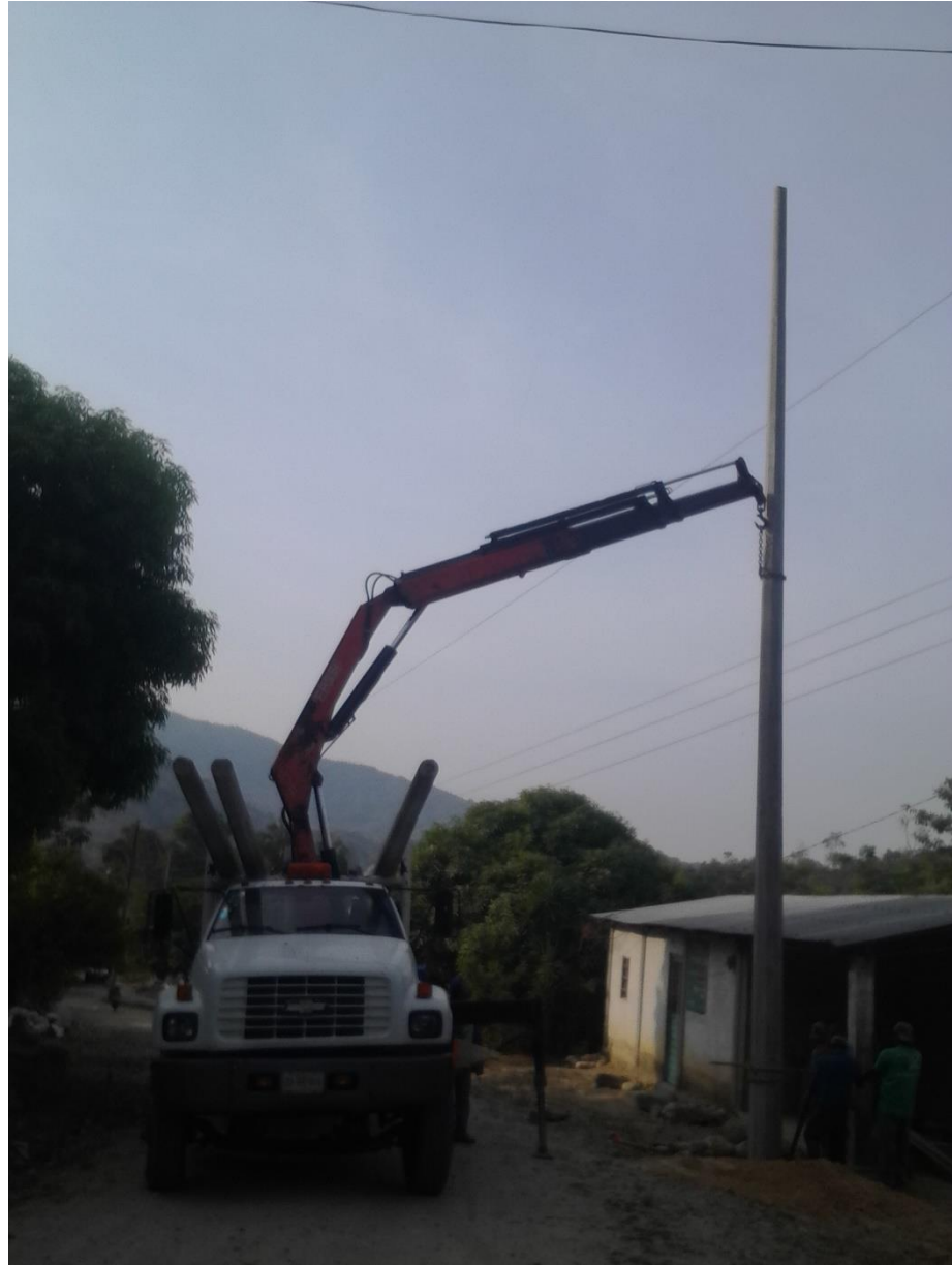
Fig. 5 Parado de poste de concreto reforzado 12-750 con equipo hidráulico.
