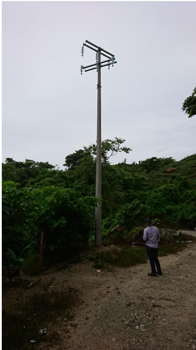
Fig. 7 Estructura RD3N/ RD3.
