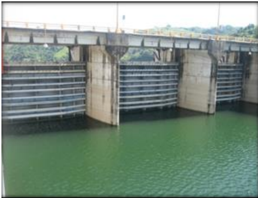
Anexo 6.12 Compuerta de vertedores
