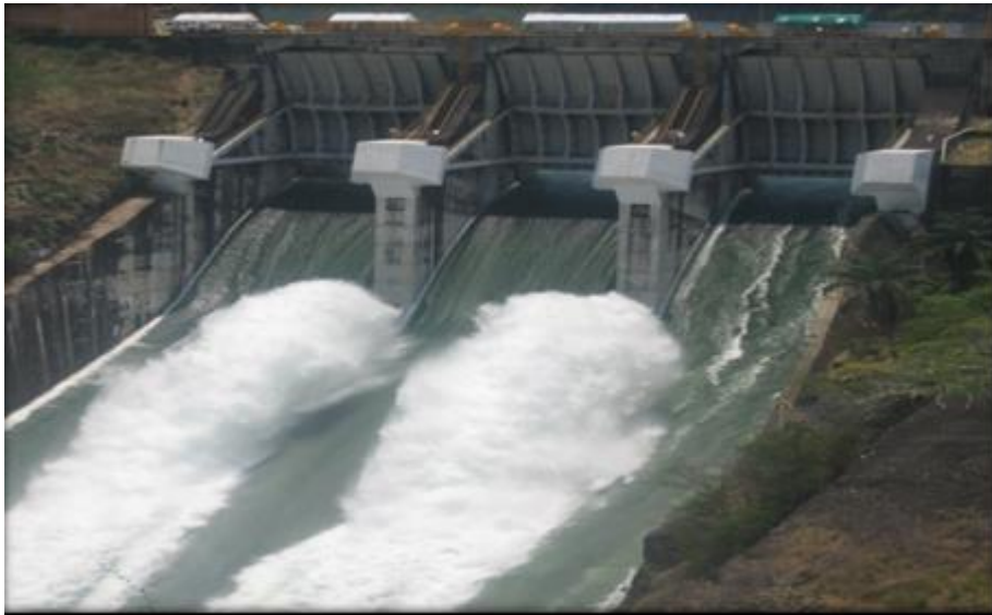
Anexo 6.11 Desfogue de la compuerta
