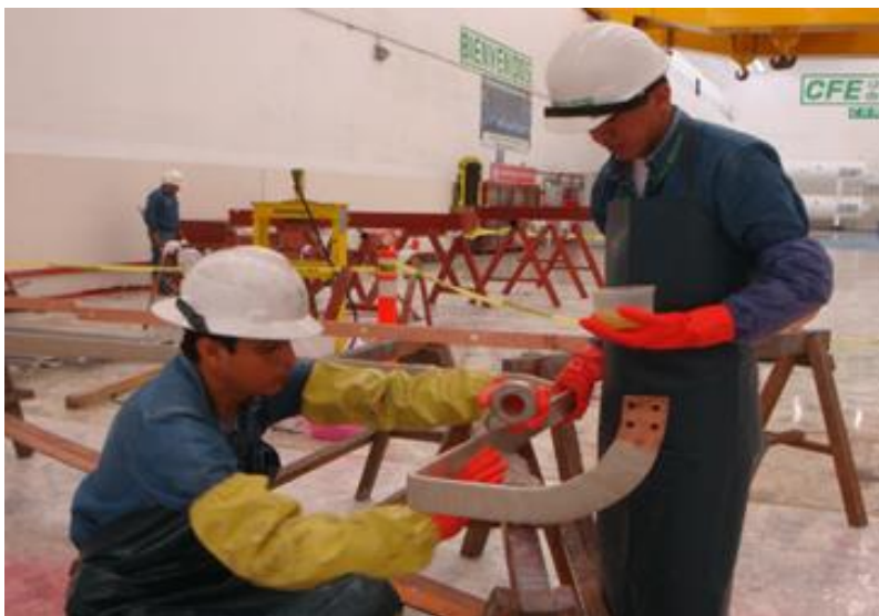
Figura 3.64 Colocación de cinta de mica con resina y cinta de fibra de vidrio.
