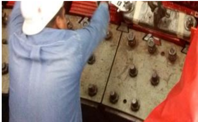
Figura 3.128 Quitando el mecanismo del polo.
