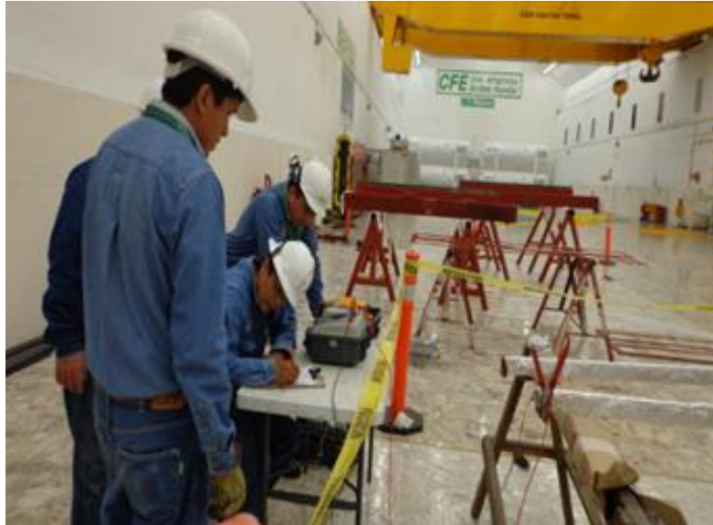
Figura 3.72 Realización de la prueba de resistencia de aislamiento al aislamiento nuevo
