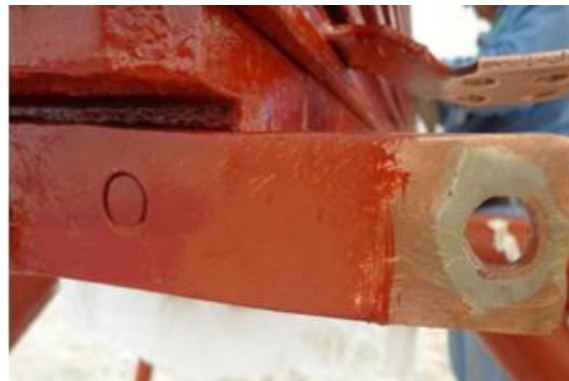
Figura 3.142 Barra amortiguadora rehabilitada
