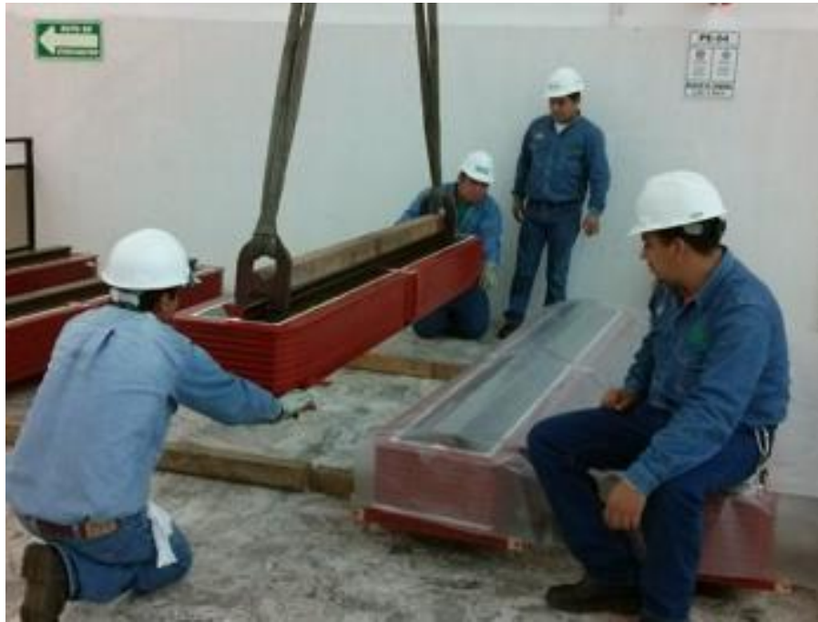
Figura 3.117 Colocación de polo terminado
