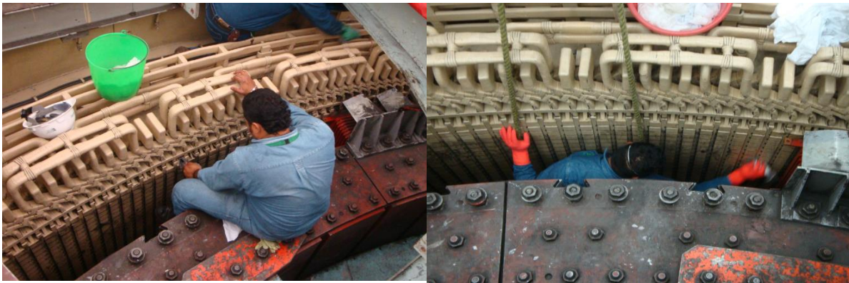
Figura 3.13 Limpiezas con dieléctrol al laminado del estator
