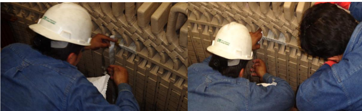
Figura 3.12 Encintado con cinta de fibra de vidrio a partes deterioradas
