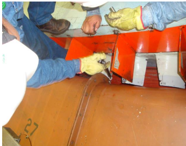
Figura 3.25 Colocaciones de tolvas de fibra de vidrio tanto en la parte superior como la inferior
