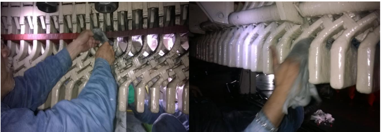
Figura 3.14 Limpieza de cabezales parte inferior
