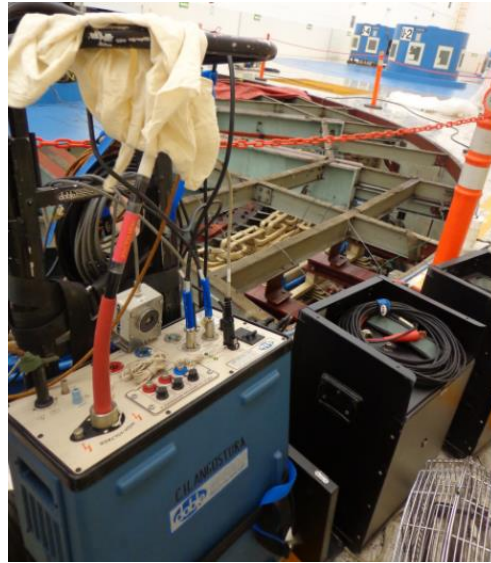
Figura 3.37 Personal de LAPEM realizando prueba al generador
