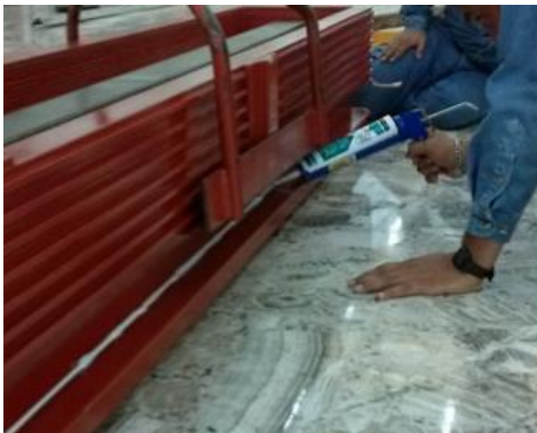
Figura 3.114 Ajuste de polo aplicando el silicón
