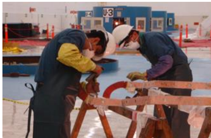
Figura 3.61 Barra de excitación sin aislamiento
