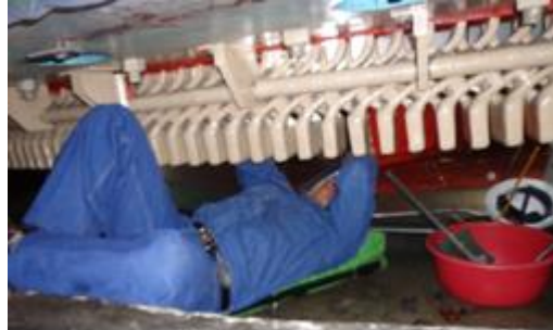
Figura 3.139 Conexión de barras amortiguadoras y orejas polares lado inferior
