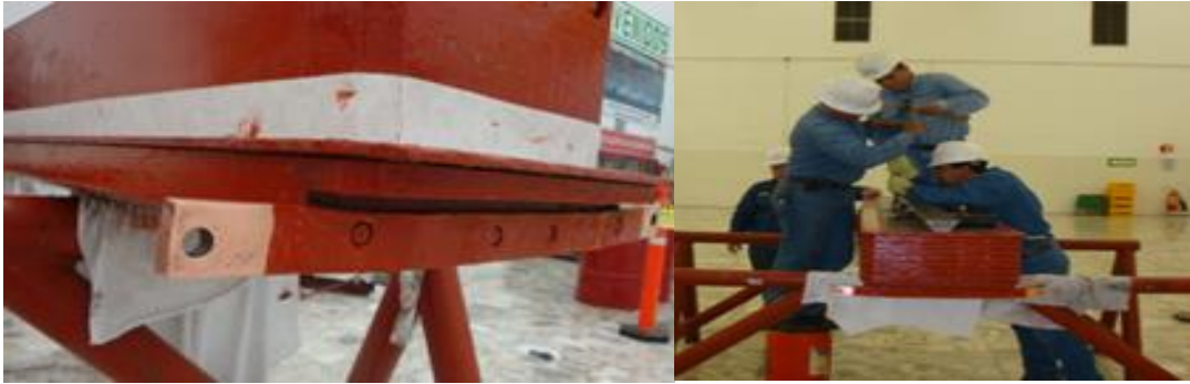
Figura 3.95 Barra colocada y pintada con barniz aislante, colocación de la bobina polar con su cinturón de agarre
