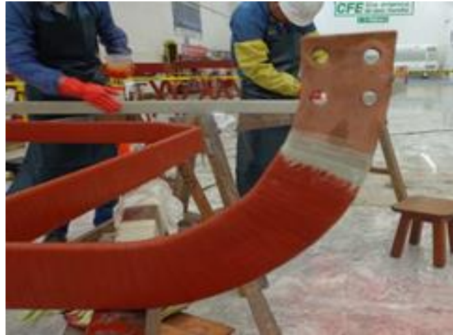
Figura 3.70 Aplicación del barniz aislante base 35
