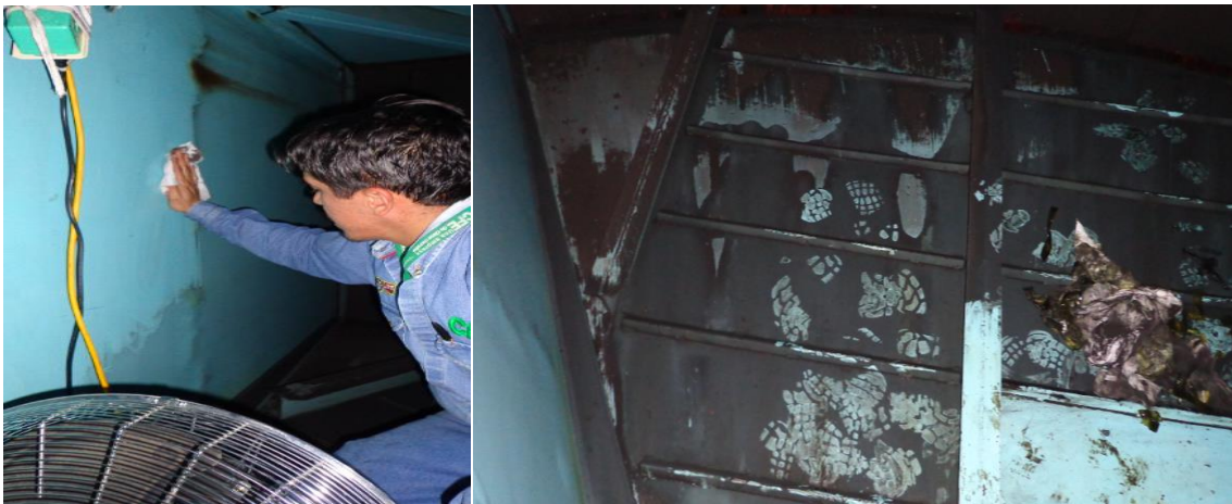
Figura 3.20 Limpieza con dieléctrol para una fácil evaporación
