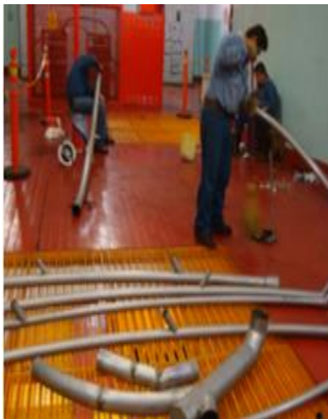
Figura 3.153 Corte de ductos para residuos de polvo
