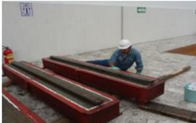
Figura 3.107 Limpieza a los polos utilizando dieléctrol
