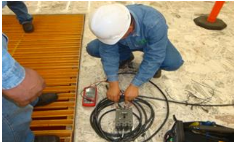
Figura 3.76 Verificación del potencial aplicado
