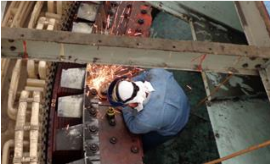
Figura 3.79 Quitando aspas de ventilación
