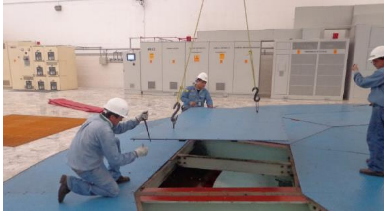
Figura 3.26 Se colocan las tapas antiderrapantes.
