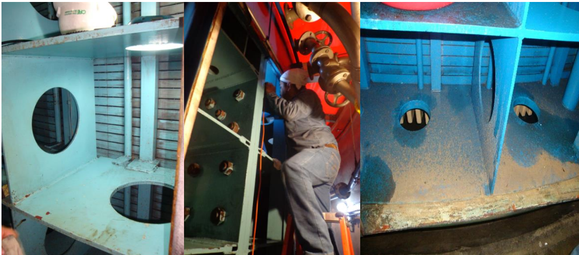
Figura 3.18 Limpieza de cubículo parte radiadores
