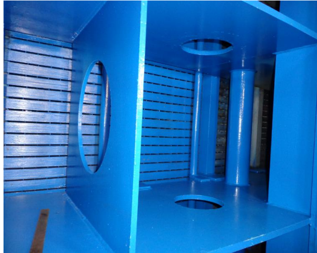
Figura 3.19 Limpieza terminada de cubículos de radiadores
