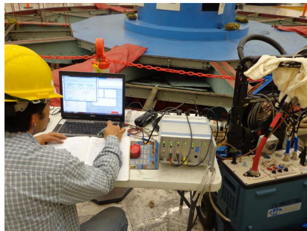
Figura 3.38 Personal de LAPEM realizando pruebas eléctricas al estator del generador
