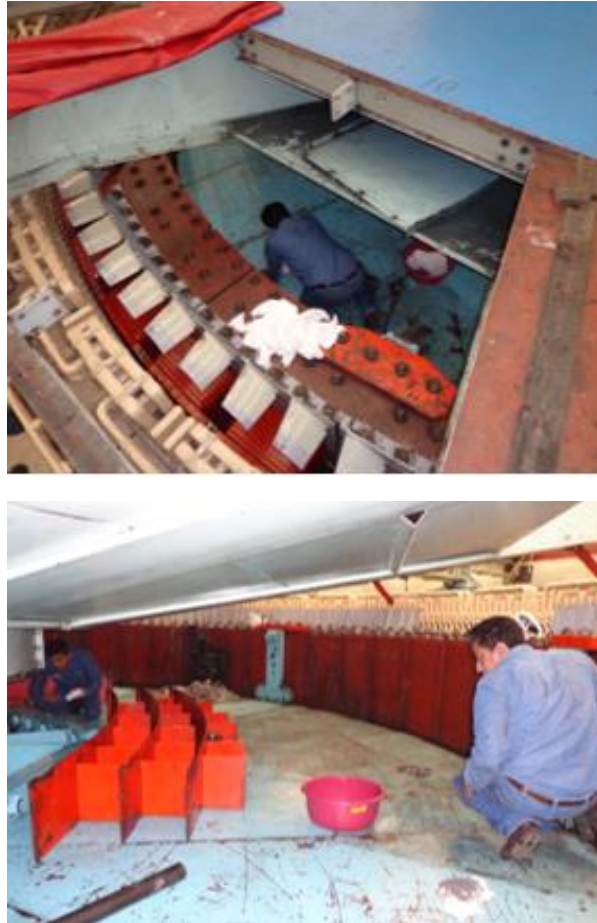
Figura 3.157 Limpieza con dieléctrol y trapos a la llanta del generador
