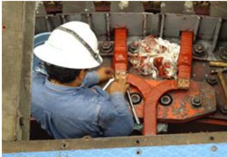
Figura 3.55 Desmontaje de las barras de excitación
