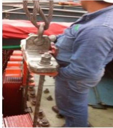
Figura 3.131 Quitando el mecanismo del polo.
