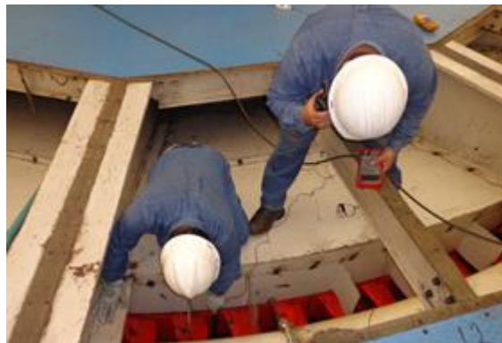
Figura 3.78 Medición de caída de tensión
