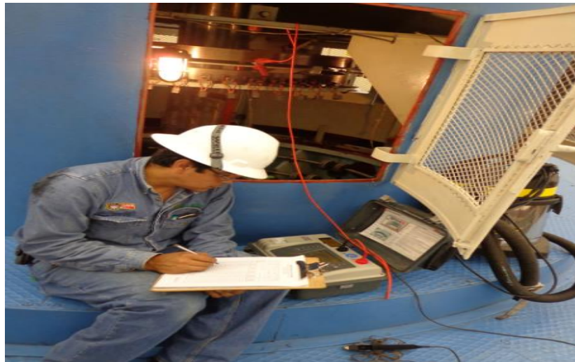
Figura 3.46 Iniciando prueba de campo del generador
