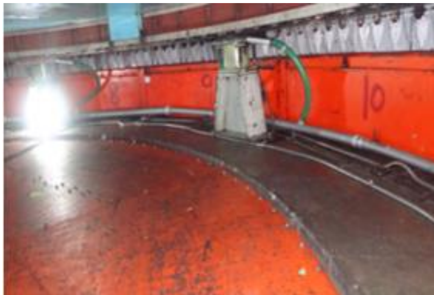
Figura 3.151 Limpieza en pista de frenado.
