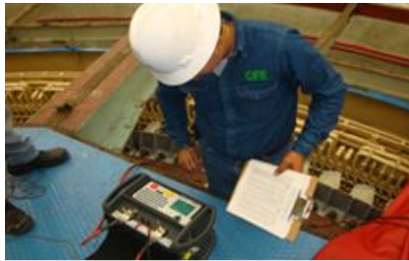
Figura 3.144 Iniciando la prueba de resistencia de contacto en la parte superior
