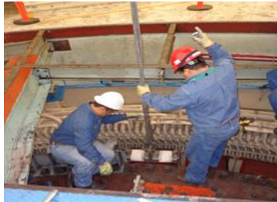
Figura 3.81 Desmontaje del polo No 35
