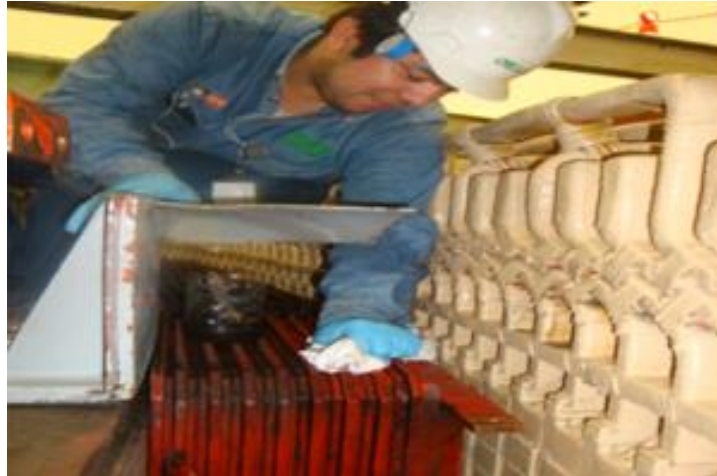
Figura 3.121 Limpieza de polo parte superior
