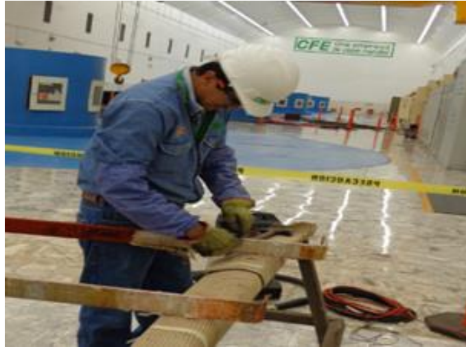
Figura 3.60 Quitando aislamiento de las barras de excitación
