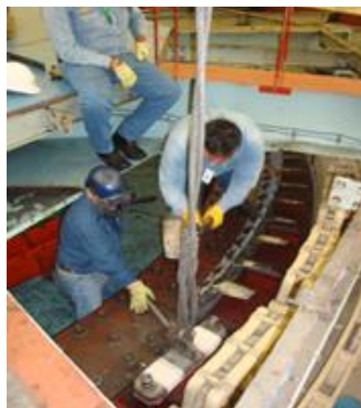
Figura 3.82 Golpeteo con marro a las cuñas que aprietan a los polos
