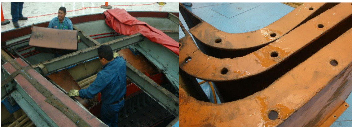
Figura 3.5 Desmontaje de las tolvas de fibra de vidrio parte superior
