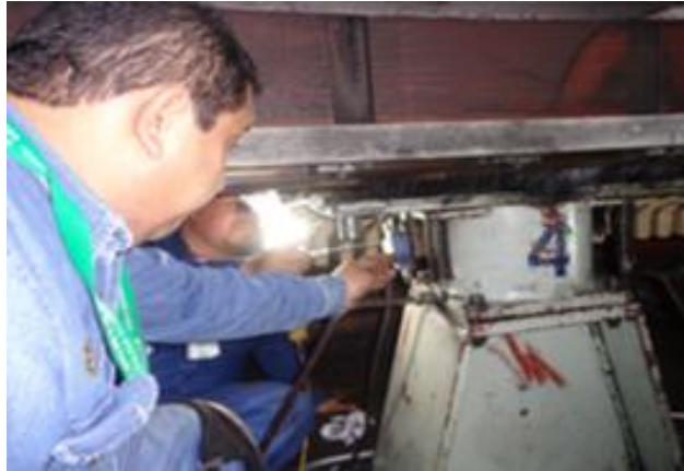
Figura 3.148 Se efectúa el mantenimiento a micros de gatos de frenado.
