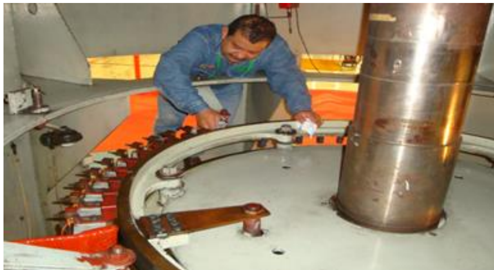
Figura 3.50 Mantenimiento a los anillos rozantes con dieléctrol
