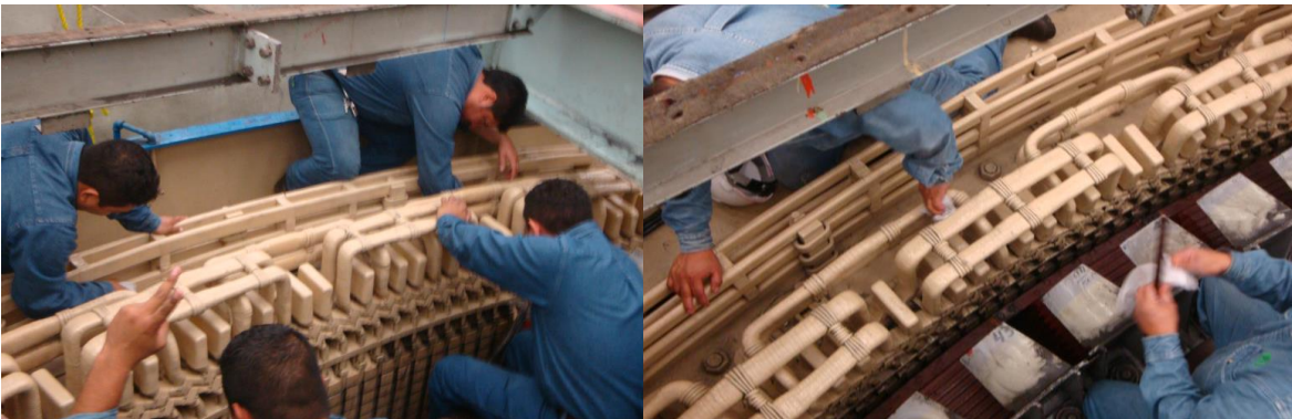
Figura 3.11 Limpieza de cabezales parte superior
