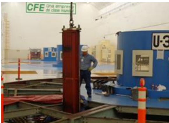
Figura 3.84 Izaje del polo no 35 y polos desmontados
