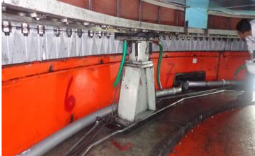
Figura 3.150 Verificaciones del frenado del generador
