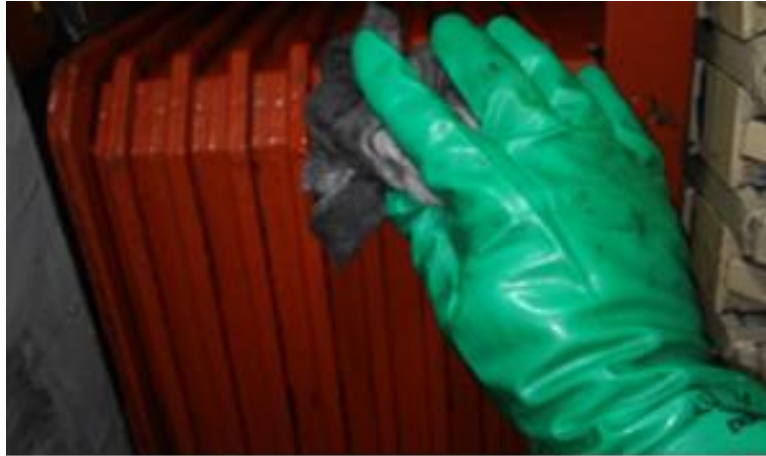
Figura 3.123 Se realiza limpieza a la parte inferior de los polos montados y aspas de ventilación
