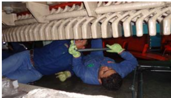
Figura 3.143 Colocación de tornillería nueva en la parte inferior de los polos
