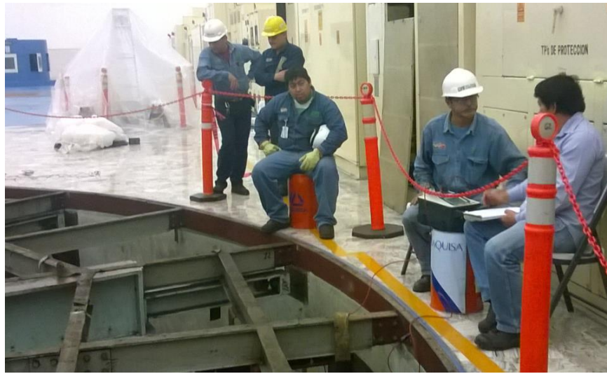
Figura 3.29 Personal de LAPEM con ayuda del departamento eléctrico realizando prueba de resistencia de aislamiento antes de la prueba de HIP-POT.
