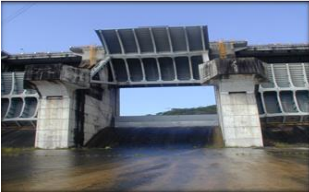
Anexo 6.13 Vertedor de emergencia
