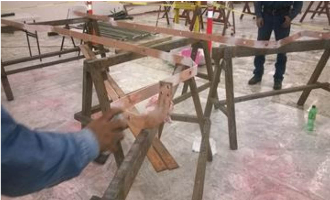
Figura 3.62 Aplicación de la prueba de líquidos penetrantes
