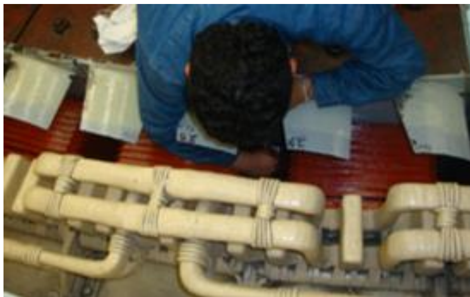
Figura 3.135 Apriete de tornillería nueva
