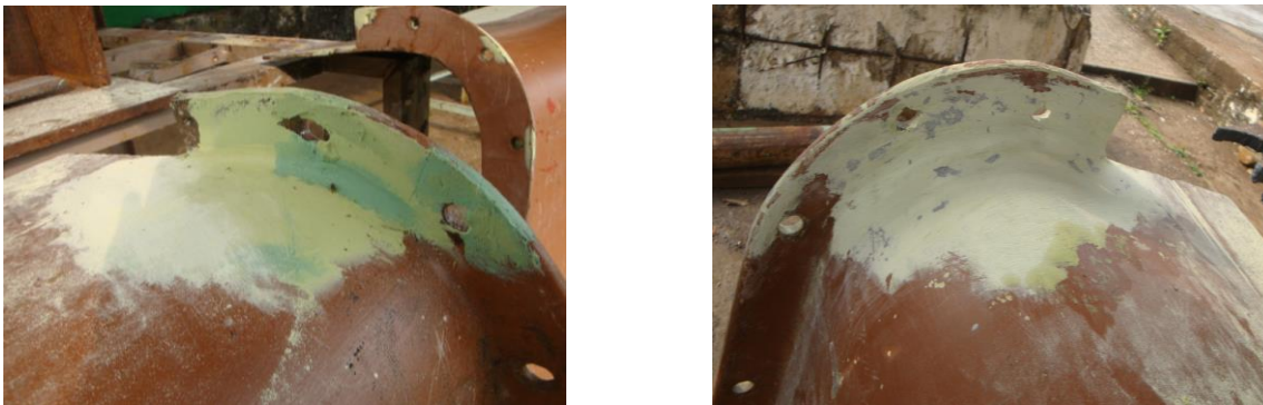
Figura 3.21 Rehabilitación de tovas de fibra de vidrio que están fisuradas
