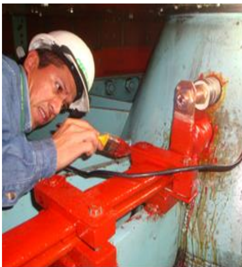
Figura 3.73 Colocación de las barras de excitación
