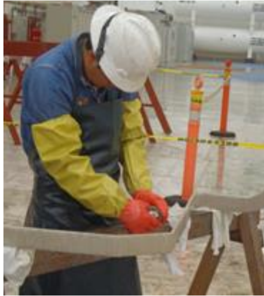
Figura 3.68 Colocación de cinta de mica
