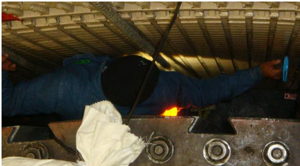
Figura 3.16 Sondeo del Acuíado del estator
