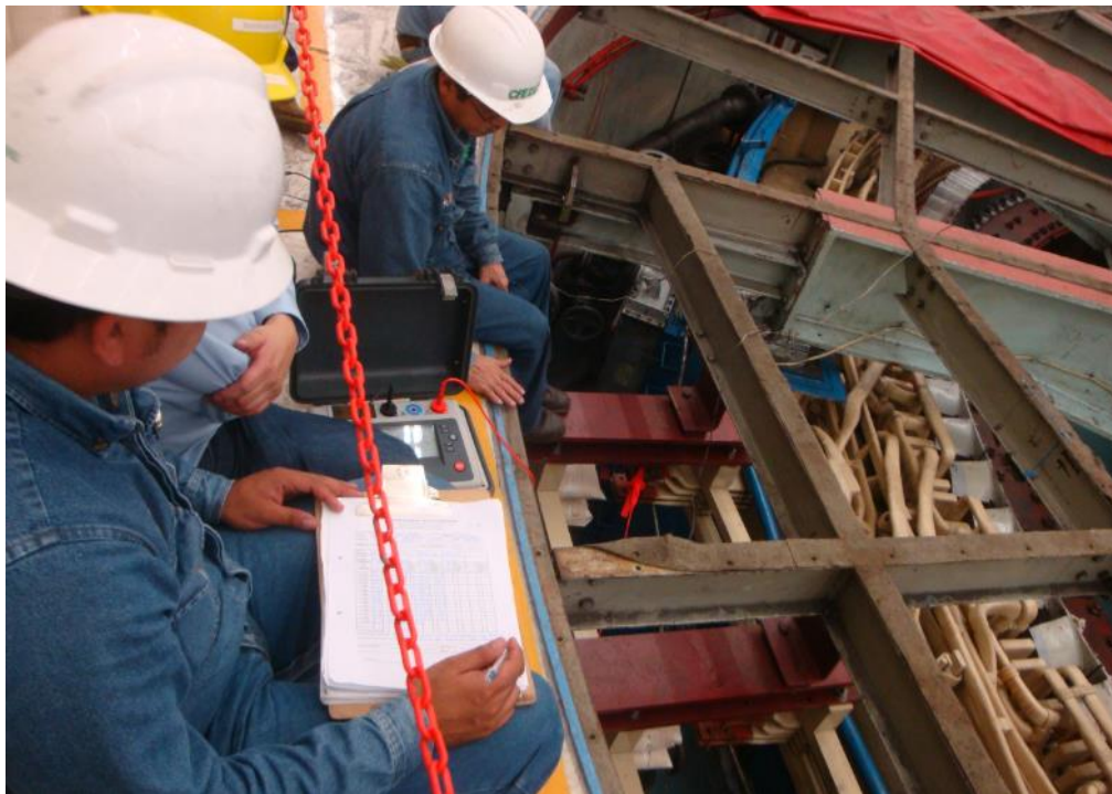
Figura 3.7 Prueba de resistencia de aislamiento a las fases del generador
