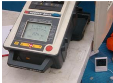
Figura 3.163 Medición de resistencia de aislamiento en el campo del generador.
