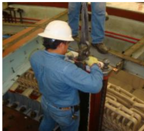
Figura 3.141 Desmontaje de polo 15
