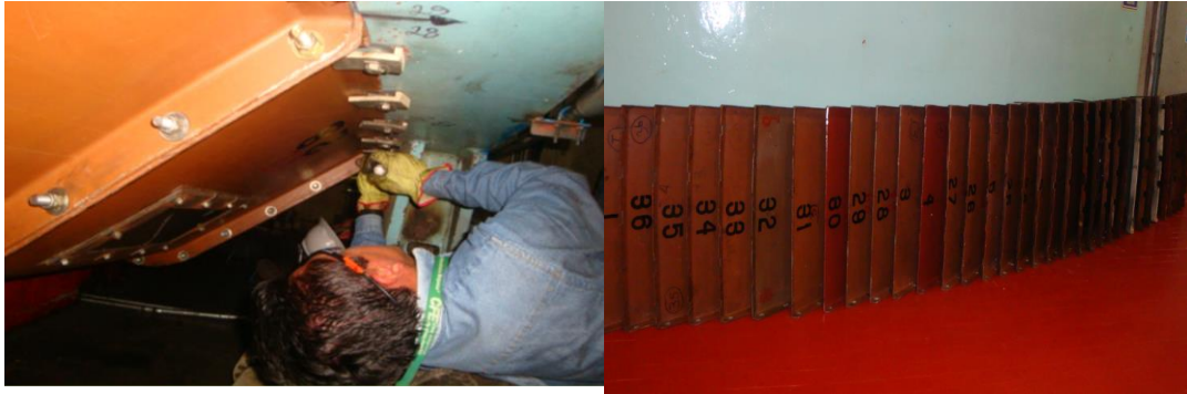
Figura 3.6 Desmontaje de las tolvas parte inferior
