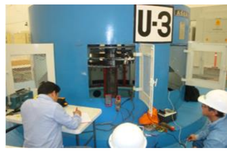
Figura 3.164 Realización de la prueba de impedancia estática.
