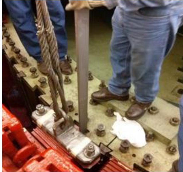
Figura 3.129 Colocación de la cuña de presión del polo.
