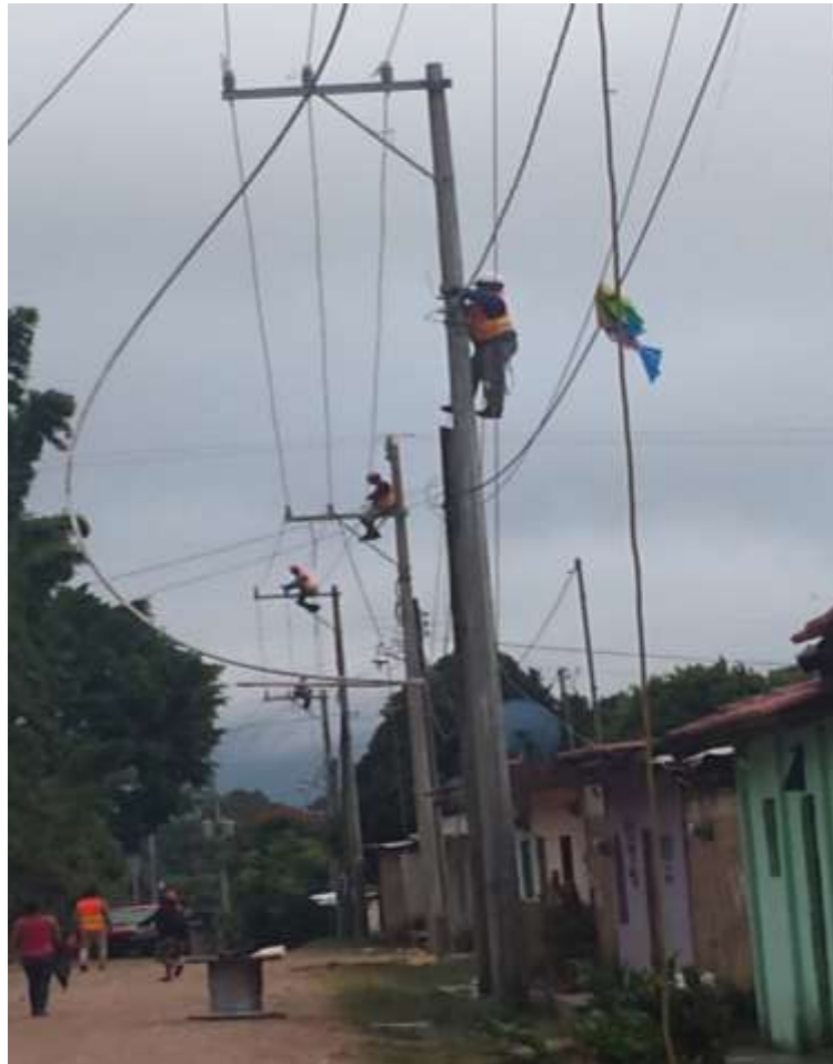
Fig. A.5 Tendido de conductor ACSR CAL. 3/0
