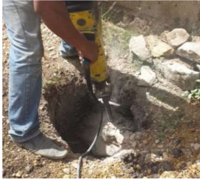
Fig. A.1 hechura de cepas para postes y retenidas con equipo hidráulico
