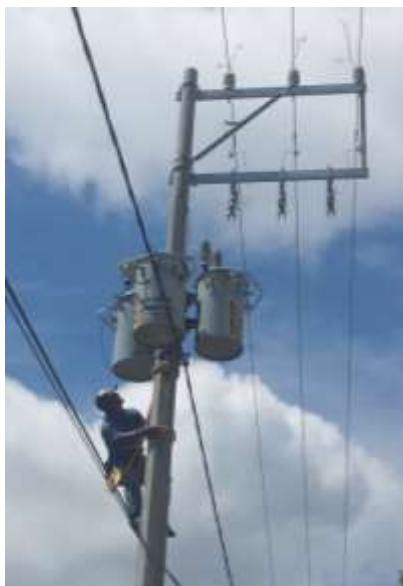
Fig. A.6 3 TR 25 KVA 1F YT, 1TR3B
