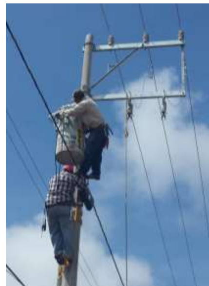
Fig. A.7 1 TR 37.5 KVA 2F, 1TR2B
