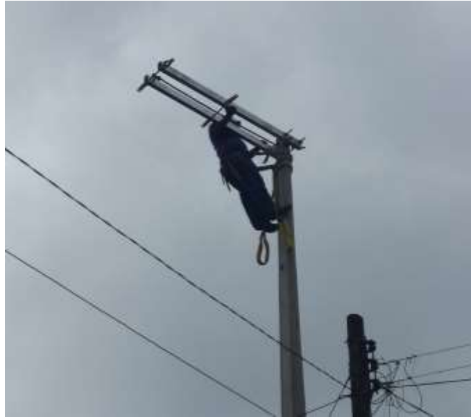
Fig. A.3 vestido de estructuras tipo voladas ejecutado con cuadrilla liniero
