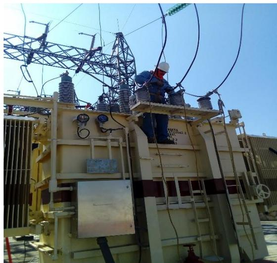
*Fig. 3.2 conexión de puesta a tierra*
