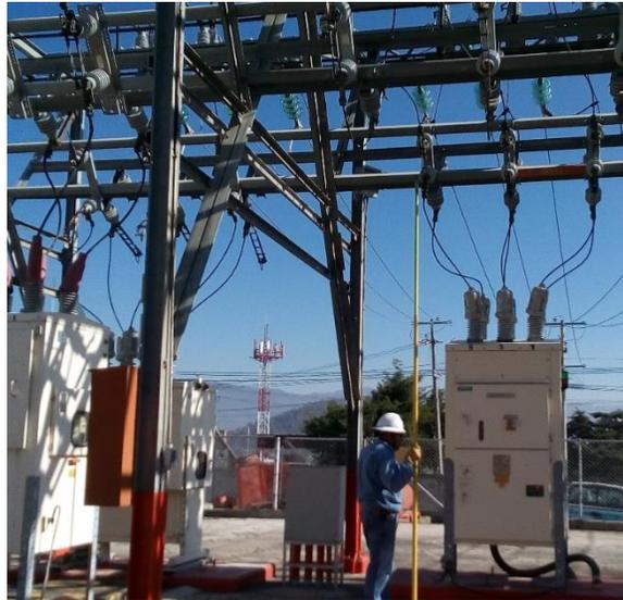
*Fig.3.1 apertura de cuchillas*
