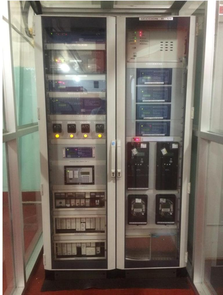
**Figura. 3.4** Gabinete de Protección y Medición.
