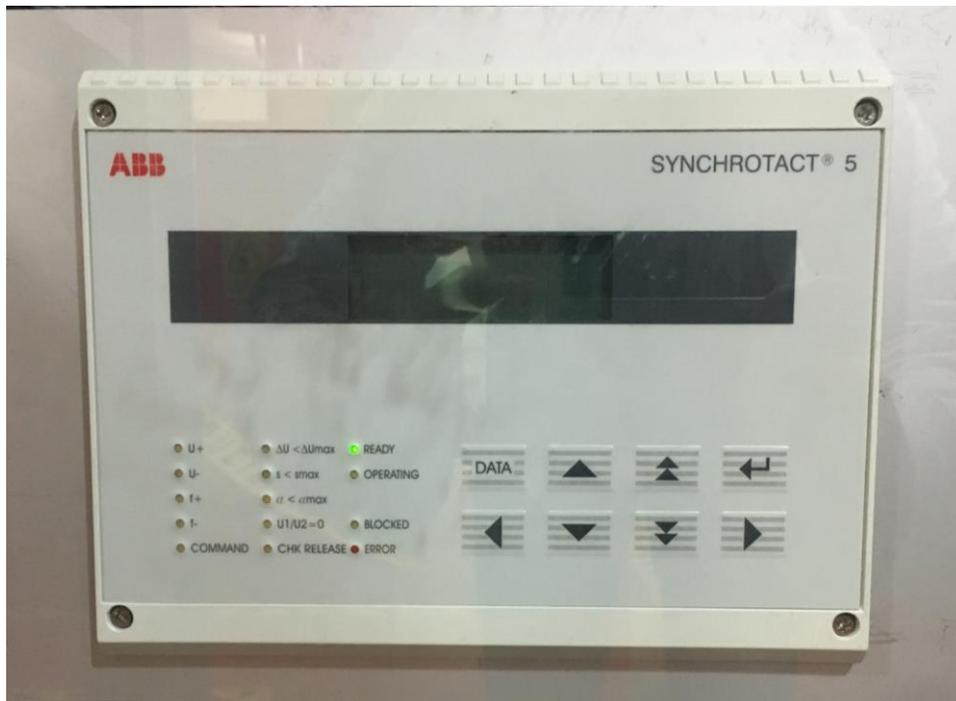
**Figura. 3.14** Sincronizador SYNCHROTACT 5 ABB
