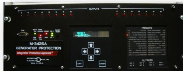
**Figura. 2.6** Relevador Multifunción de Generador M-3425A
