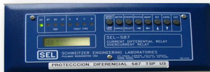
**Figura. 2.9** Relevador para diferencial de corriente SEL-587
