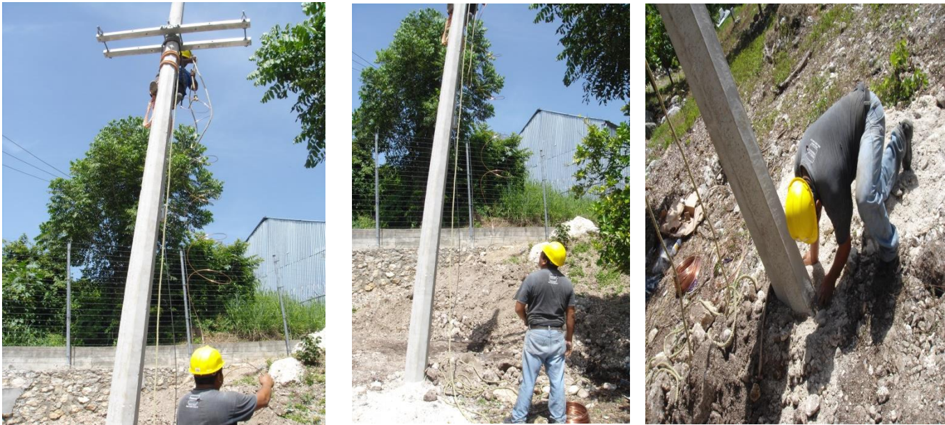
Fig. 3.1.22 Colocación de un sistema de tierra.
