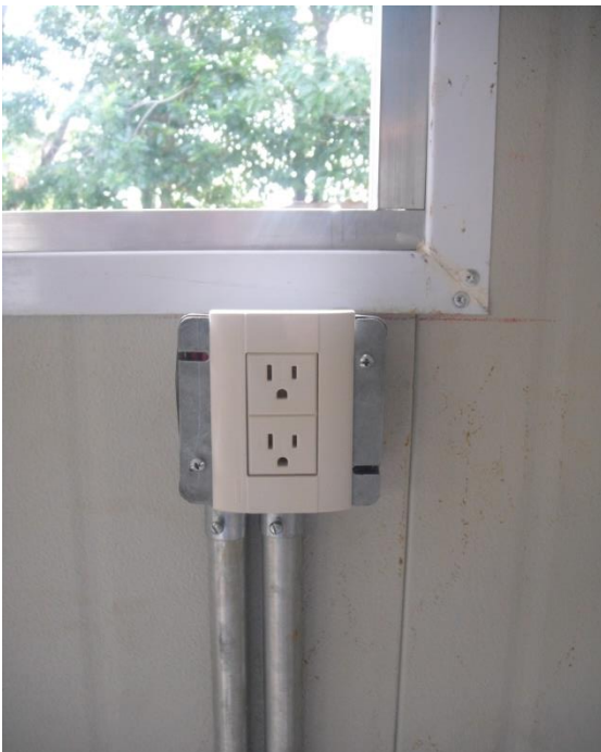
Fig. 3.3.4 contactos polarizados y apagadores.
