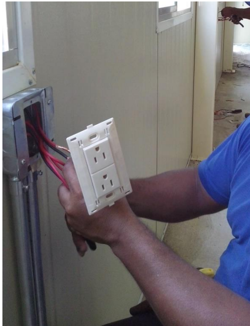
Fig. 3.2.7 Instalación de Tomacorrientes. CONTACTO POL Y AT. 127 V 200W.
