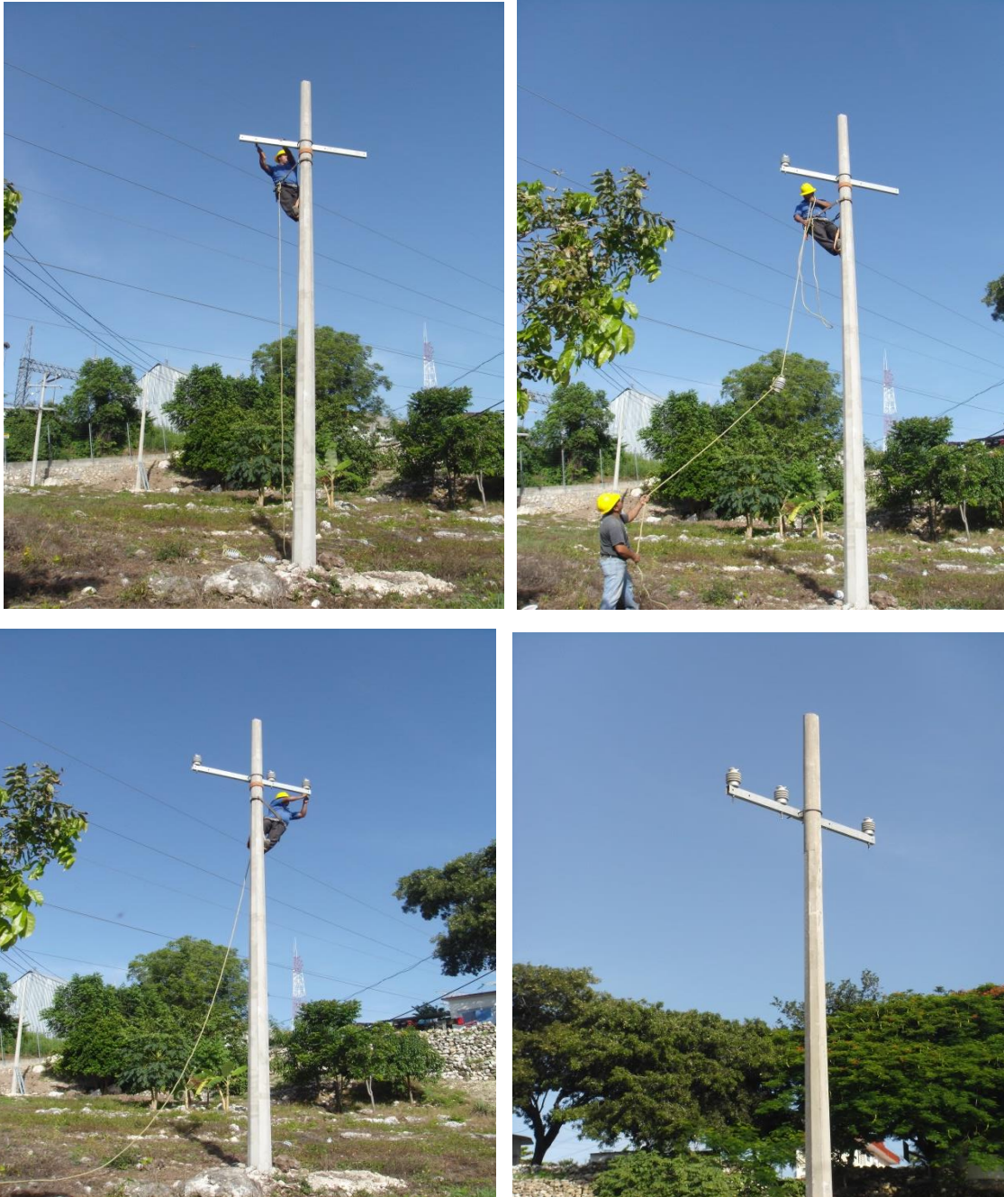
Fig. 3.1.13 Colocación de cruceta C4T y aislador tipo poste 13PC.
