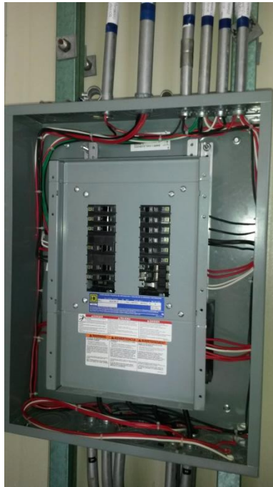
Fig. 3.2.10 Realización de estética al tablero de distribución.
