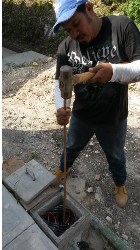
Fig. 3.2.3 Instalación de Sistema Protección (Tierra Física).
