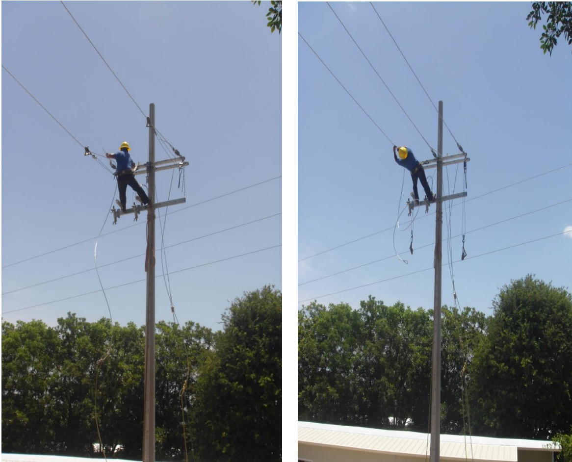
Fig. 3.1.18 Realización de Tensado de los Conductores.
