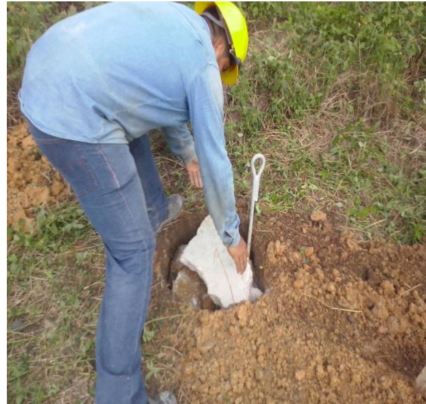
Fig. 3.1.9 Modo de colocación de un ancla.
