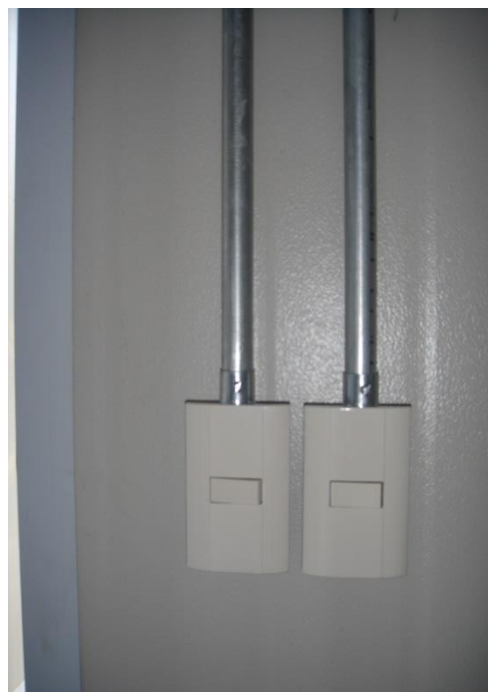
Fig. 3.3.4 contactos polarizados y apagadores.
