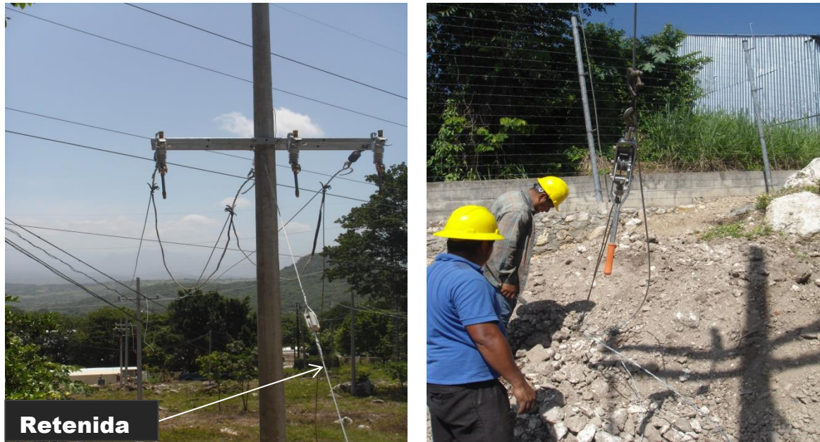
Fig. 3.1.14 Colocaciones de retenida.
