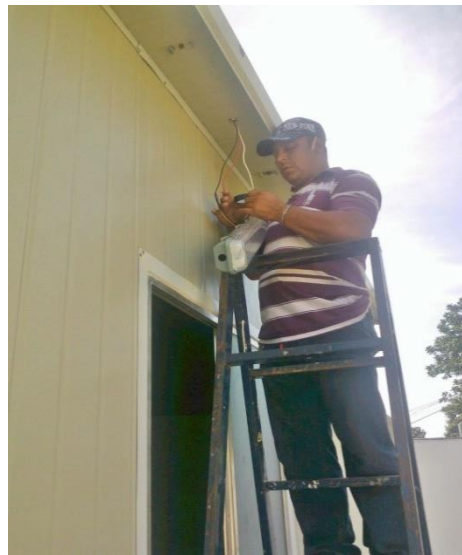
Fig. 3.2.7 Se Instaló Luminarias con sus respectivos Apagadores.
