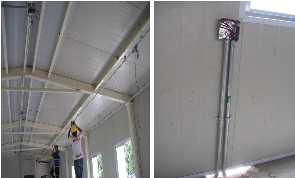
Fig. 3.2.6 colocación de cables para la instalación de accesorios.
