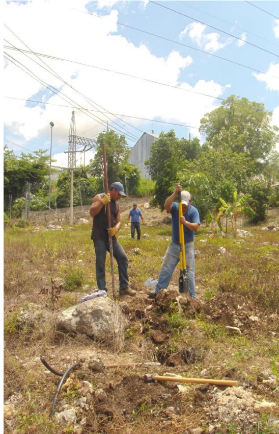
Fig. 3.1.5 Excavación de cepa para poste.
