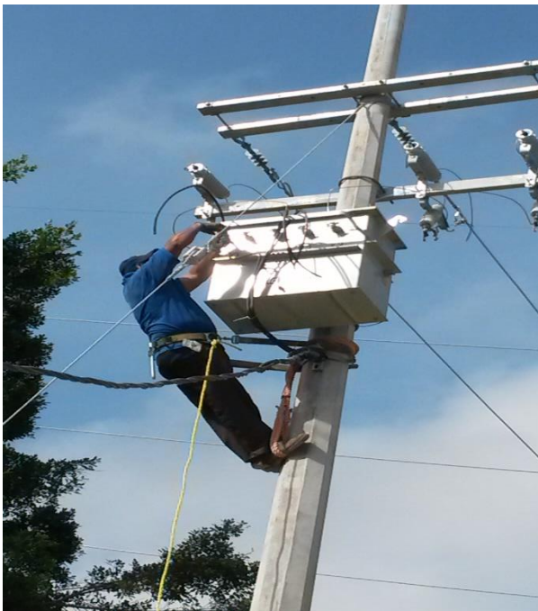
Fig. 3.2.1 Instalación de Acometida del Sistema de Baja Tensión.
