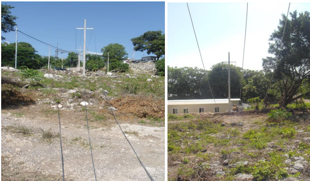
3.1.17 Tendido de los conductores y colocados en la cruceta.
