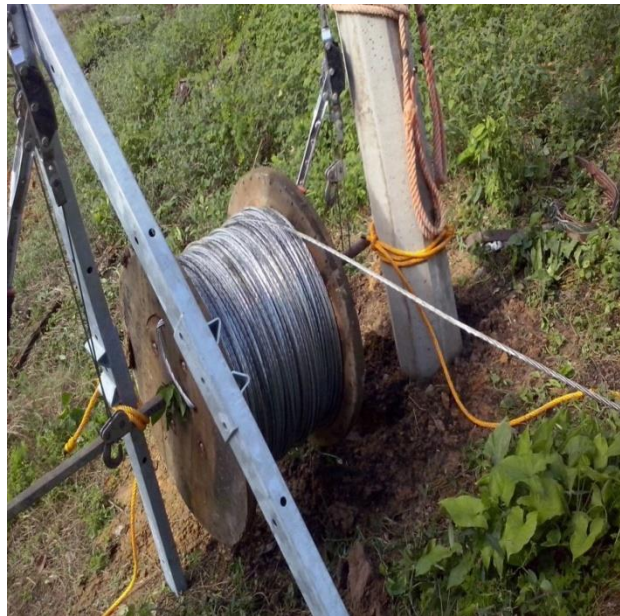
Fig. 3.1.16 Tendido de Cable.
