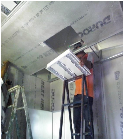
Fig. 3.2.7 Se Instaló Luminarias con sus respectivos Apagadores.
