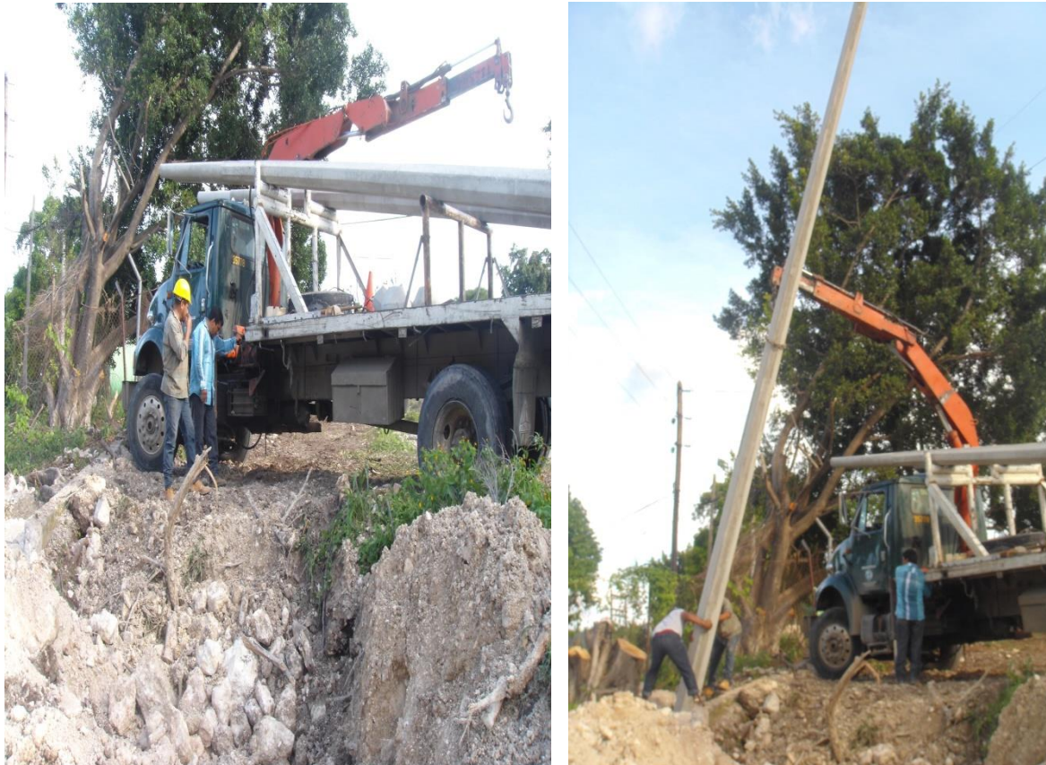
Figura 3.1.6 En la imagen izquierda se observa a la grúa lo cual ayudó en el traslado y a la colocación del poste; la imagen derecha se observa la colocación del poste en la cepa.
