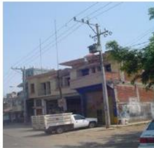
Figura 1.2.- la fotografía de la izquierda muestra una zona arbolada sobre el paso de red eléctrica con conductor desnudo, mientras que en la fotografía de la derecha se observa conductores muy cercanos a las partes altas de las viviendas, lo cual representa un peligro para los usuarios.
