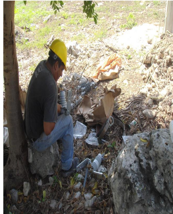
Fig.3.2.11 Las imágenes de arriba son el armado y colocación de la protecciones de sobre
