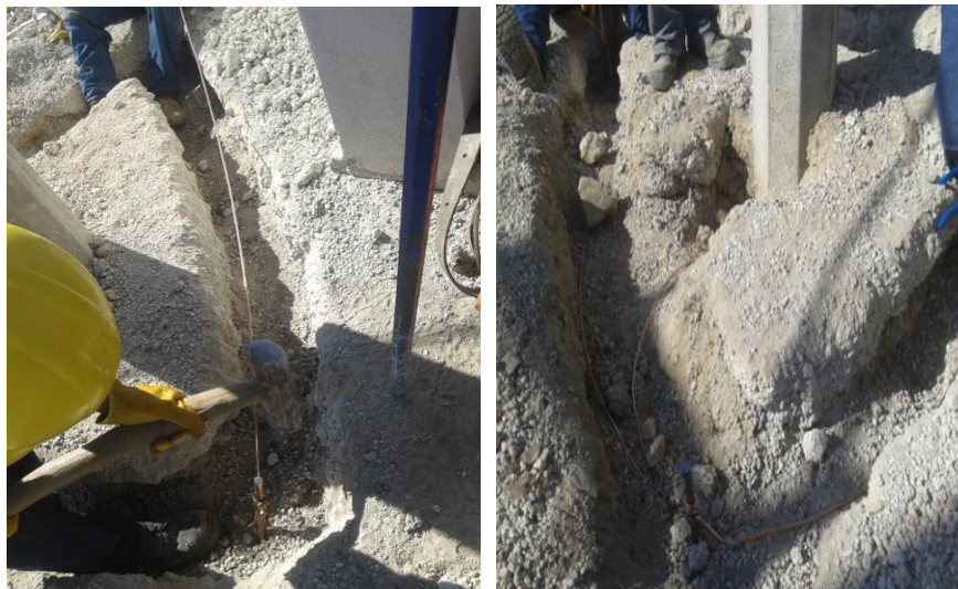
Fig. 3.1.22 Colocación de un sistema de tierra.
