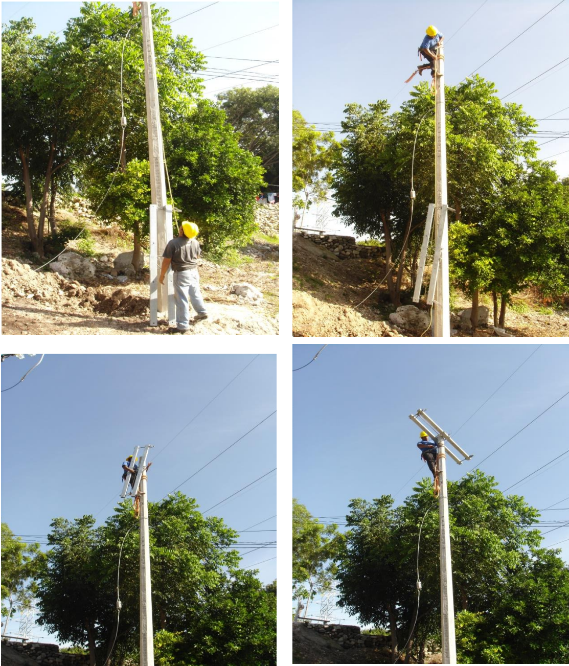
Fig. 3.1.12 Colocación de la cruzeta doble PT200, PT250.
