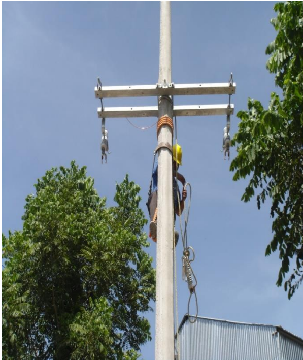
Fig.3.2.11 Las imágenes de arriba son el armado y colocación de la protecciones de sobre
