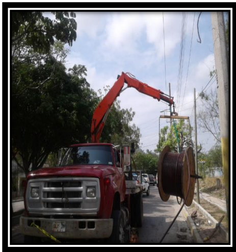
Figura 3.47.-Colocacion de carrete. Figura 3.48.-Inicio de tendido de cable.
