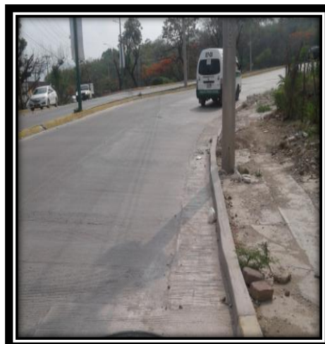
Figura 3.42.- Reposicion de guarnición.
