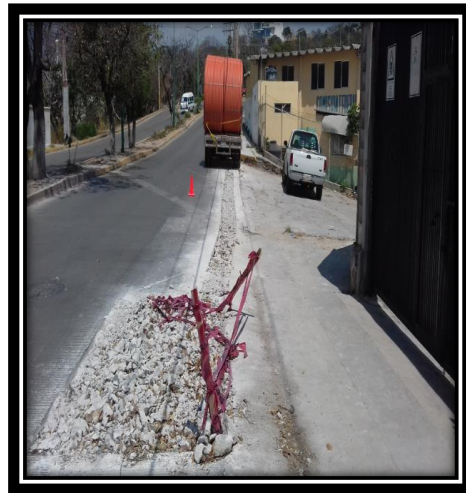
Figura 3.17.- Demolición para zanja.
