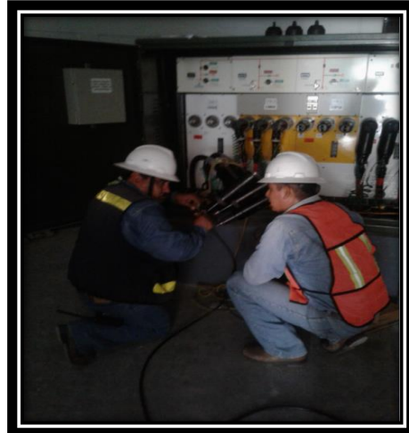
Figura 3.64.- Inspeccion de terminales. Figura 3.65.- Conexión para prueba VLF.
