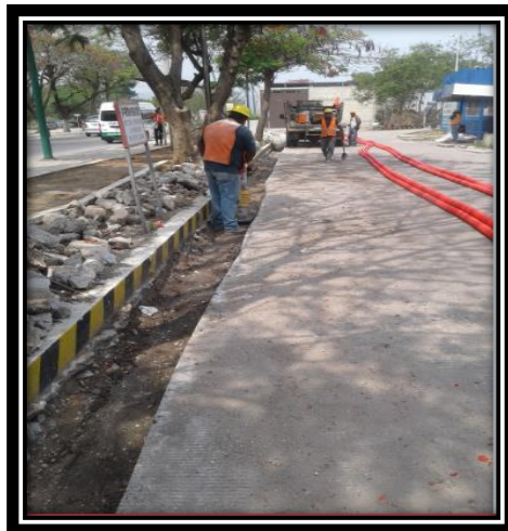
Figura 3.39.-Compactacion “arroyo”. Figura 3.40.-Compactacion “banqueta”.
