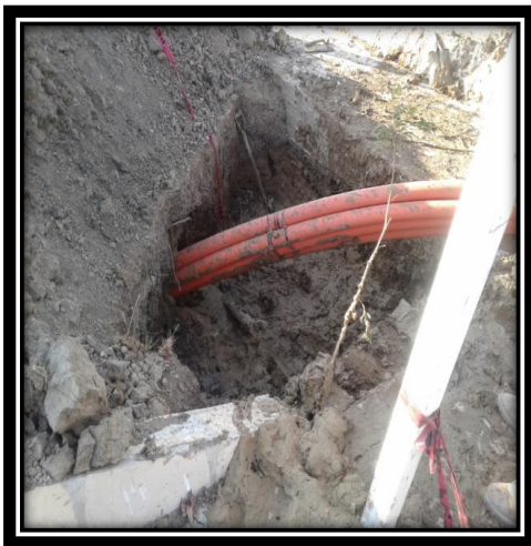
Figura 3.25.-Inicio de tendido de ductos. Figura 3.26.- Lodo producto de PHD.
