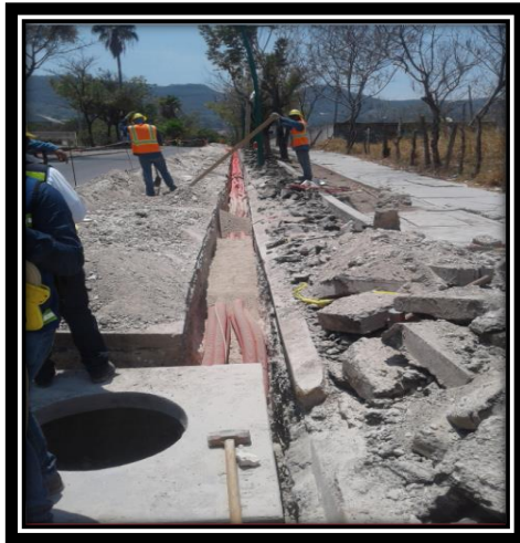
Figura 3.35.-Inicio de Relleno “arroyo”. Figura 3.36.-Inicio de relleno “banqueta”.
