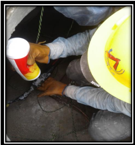
Figura 3.57.-Lubricado de cable. Figura 3.58.-Jalado de coca en registro.
