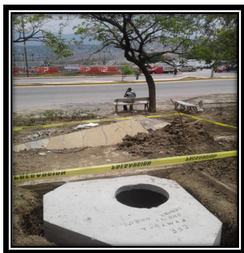
Figura 3.29.-Pozo tipo "L" banqueta. Figura 3.30.-Registro tipo "4" banqueta.
