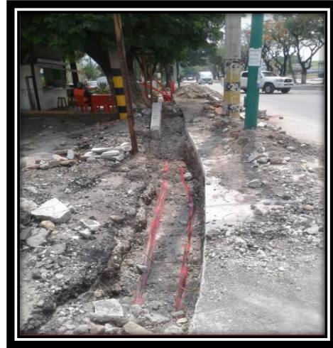
Figura 3.37.-Cinta peligro en “arroyo”. Figura 3.38.-Cinta peligro en “banqueta”.
