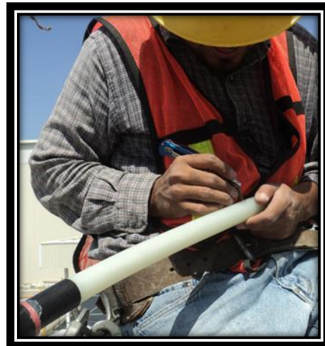
Figura 3.61.- Capa semiconductor.
