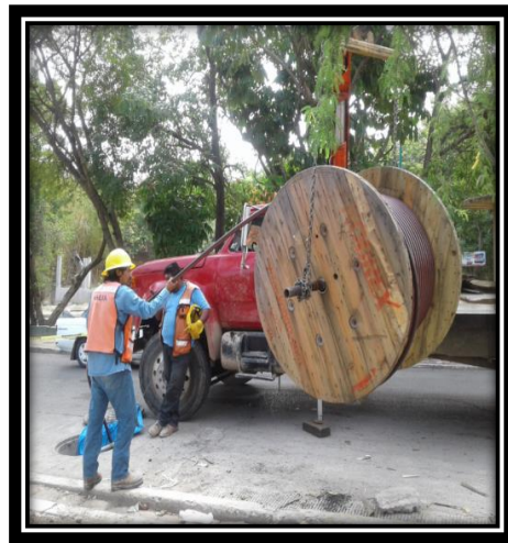
Figura 3.47.-Colocacion de carrete. Figura 3.48.-Inicio de tendido de cable.
