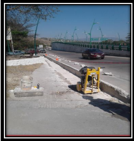
Figura 3.6.-Corte con disco. [Índice]
