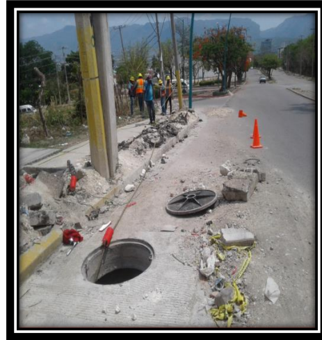
Figura 3.49.-Colocacion de rodillo. Figura 3.50.-Jalado de cable con polea.
