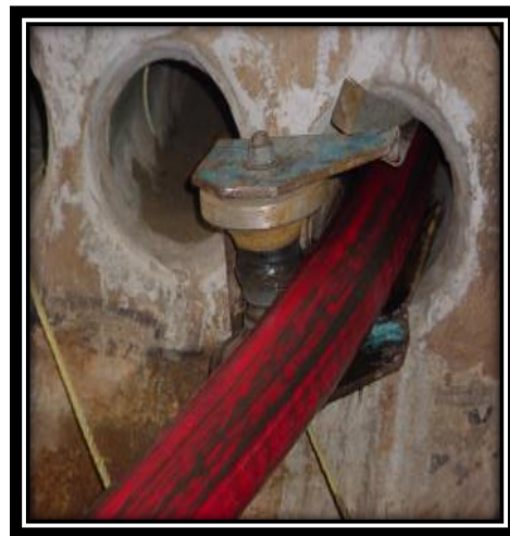
Figura 2.24.- Metodo de poleas y rodillos. Figura 2.25.- Rodillo para cable.
