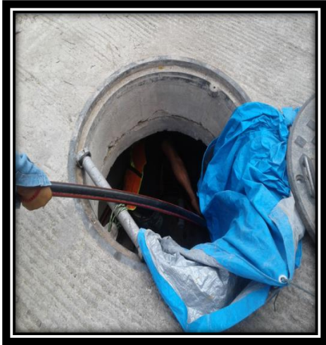
Figura 3.49.-Colocacion de rodillo. Figura 3.50.-Jalado de cable con polea.
