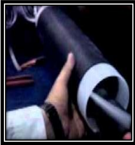
Figura 3.58.- Empalme termocontráctil.
