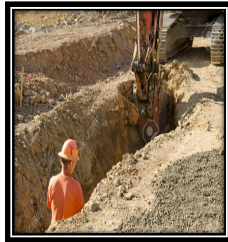
Figura 2.6.- Excavacion manual. Figura 2.7.- Excavacion con maquinaria.
