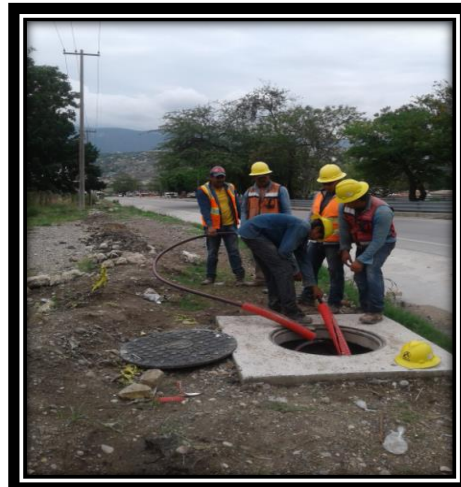
Figura 3.57.-Lubricado de cable. Figura 3.58.-Jalado de coca en registro.
