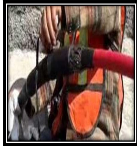
Figura 3.59.- Instalacion de empalme.
