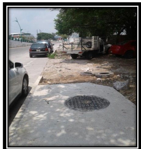
Figura 3.46.-Tapa 84B en pozo.
