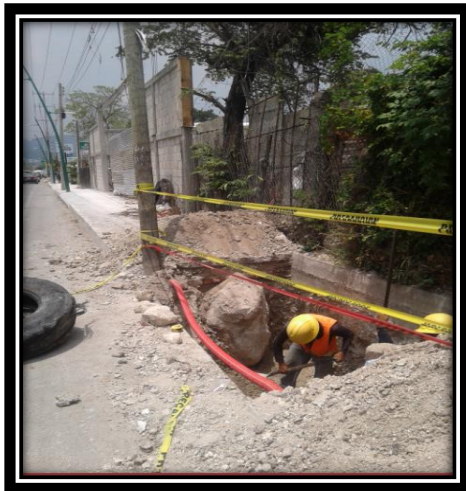
Figura 3.18.- Pozo en banqueta. Figura 3.19.- Excavación de pozo terminada.
