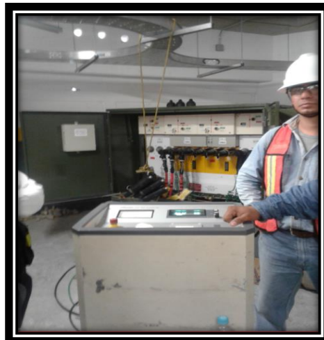
Figura 3.67.- Inicio de prueba VLF.
