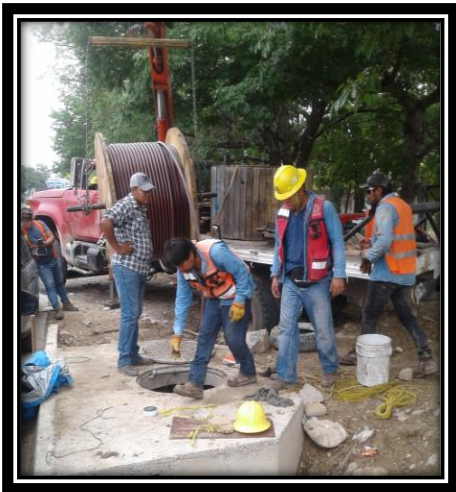
Figura 3.53.-Utilización de grúa.
