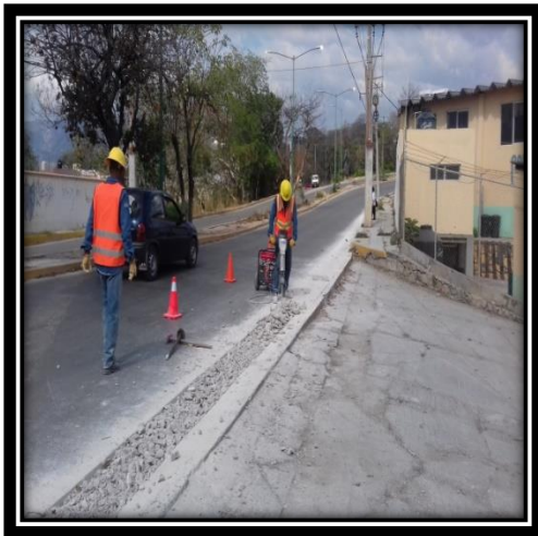
Figura 3.10.- Demolición de concreto.
