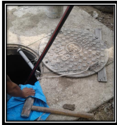
Figura 3.54.-Colocacion de rodillo.
