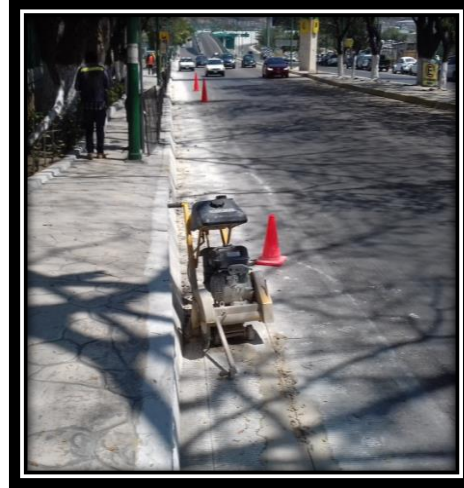
Figura 3.9.- Corte en arroyo con disco.
