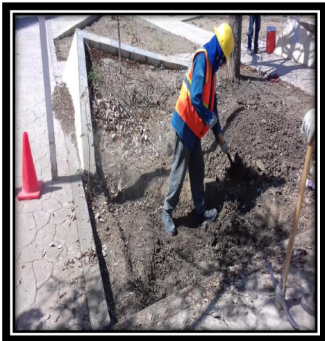
Figura 3.16.- Excavación de zanja.
