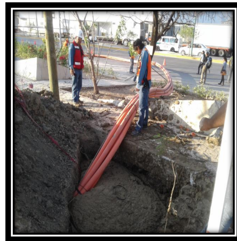
Figura 3.25.-Inicio de tendido de ductos. Figura 3.26.- Lodo producto de PHD.
