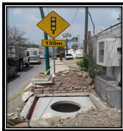
Figura 3.29.-Pozo tipo "L" banqueta. Figura 3.30.-Registro tipo "4" banqueta.
