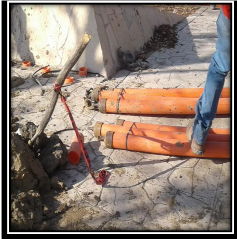
Figura 3.23.-Acopladores para ducto. Figura 3.24.-Conexión ducto-escariadora.
