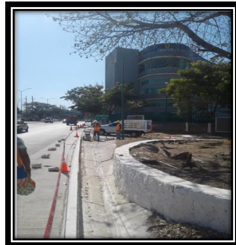
Figura 3.7.-Demolición en banqueta.
