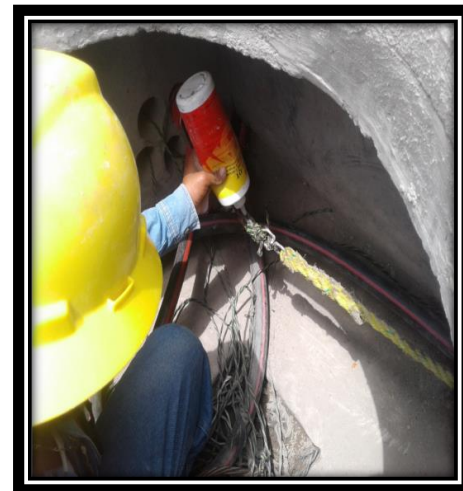
Figura 3.51.-Inspeccion de cable. Figura 3.52.-Colocacion de lubricante.
