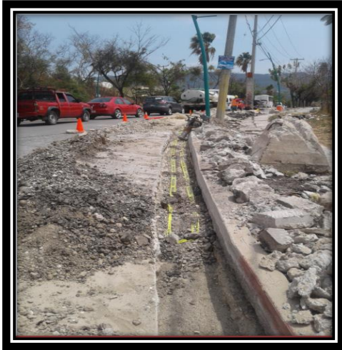
Figura 3.37.-Cinta peligro en “arroyo”. Figura 3.38.-Cinta peligro en “banqueta”.
