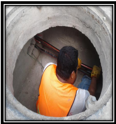
Figura 3.51.-Inspeccion de cable. Figura 3.52.-Colocacion de lubricante.
