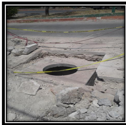
Figura 3.27.-Pozo tipo "P" arroyo. Figura 3.28.-Registro tipo "4" arroyo.
