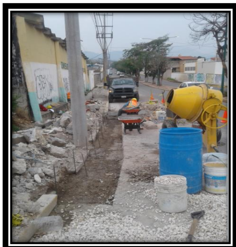
Figura 3.41.- Reposición de concreto.
