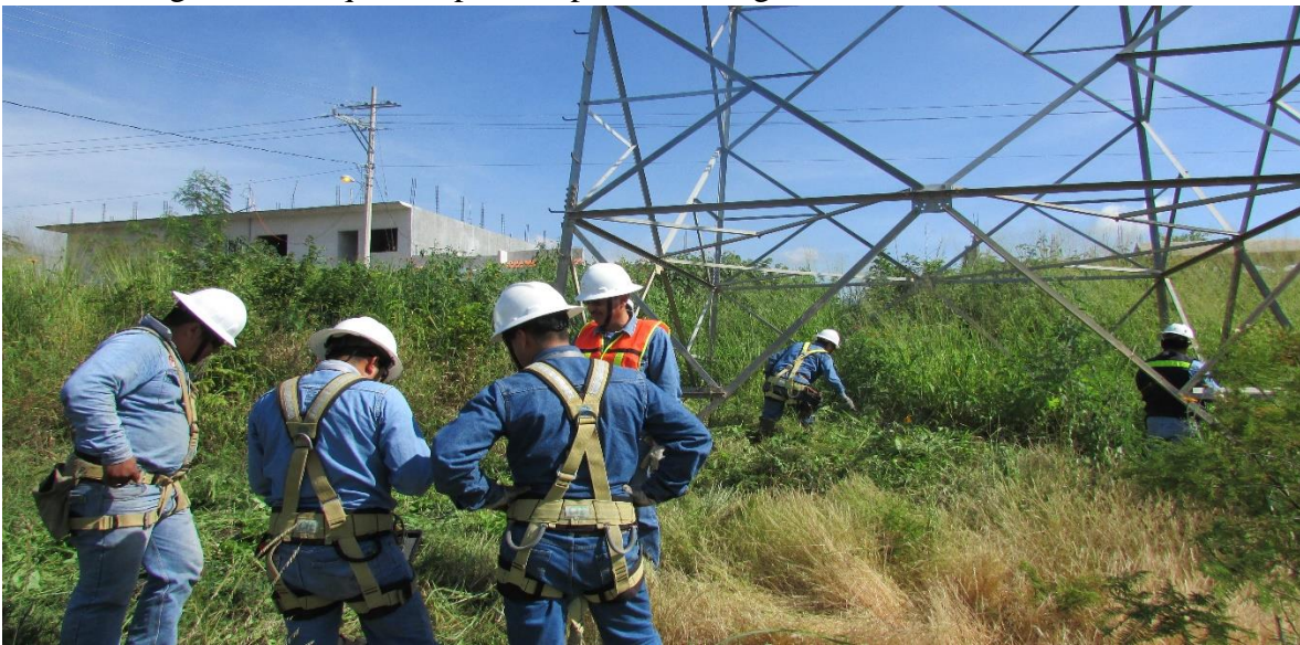
Figura 24. Limpieza del botón panel y patas de la estructura.
