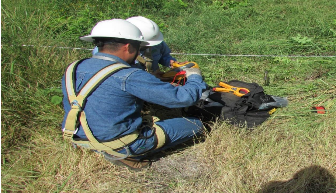
Figura 27. Conexión del Megger.
