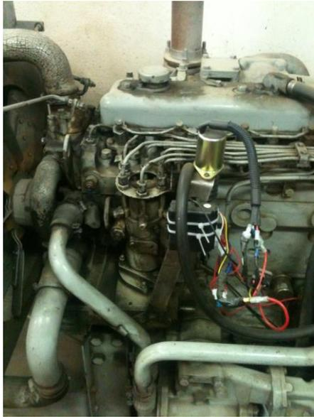
FIGURA 2.12. MOTOR DE PLANTA DE EMERGENCIA DE 75 KW DE 8 CILINDROS
