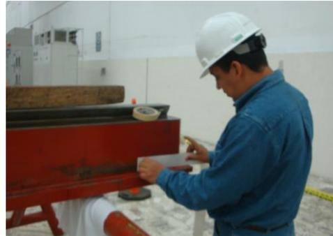
**Figura 4.47 desarmado de polo 35 para darle mantenimiento**
