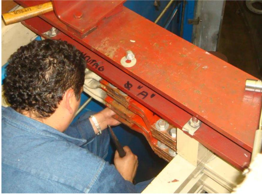
**Fig. 4.1.19 A. Conexiones de las trenzas lado Fases**
