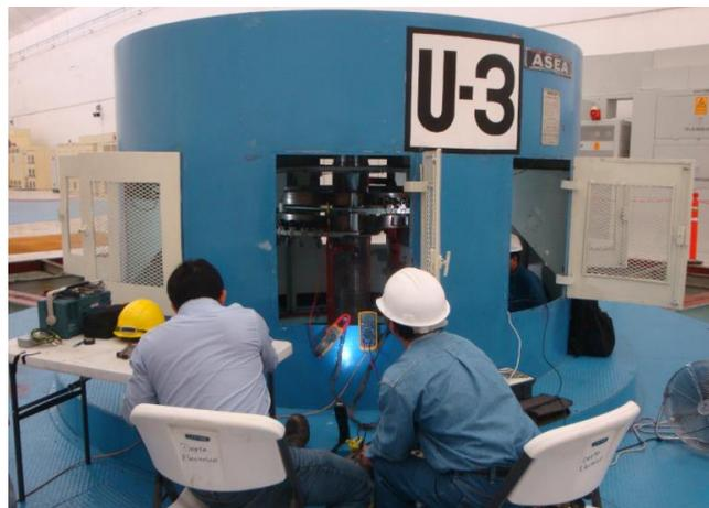
**Realización de prueba de impedancia dinámica**
