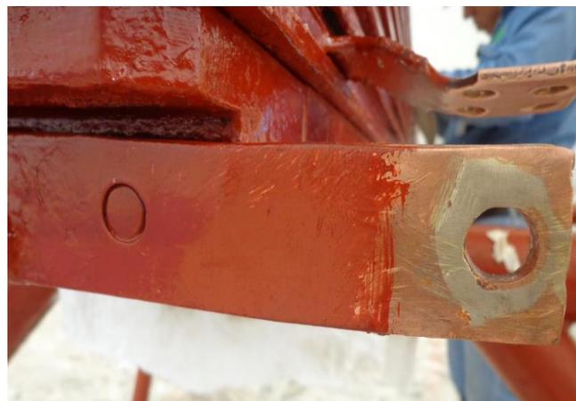
**Fig. 4.88 Barra amortiguadora rehabilitada**
