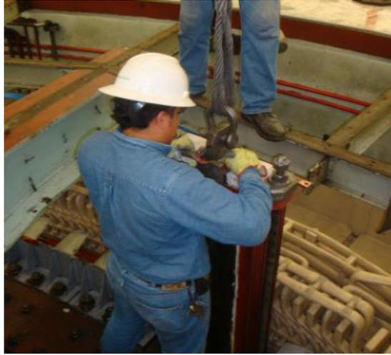
**Fig. 4.86 Desmontaje de polo 15**
