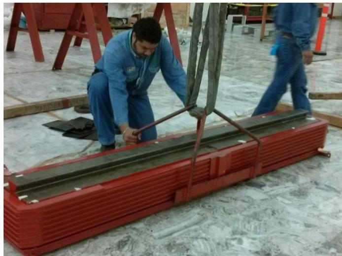
***Fig. 4.63 Ajuste de polo aplicando el silicón.***
