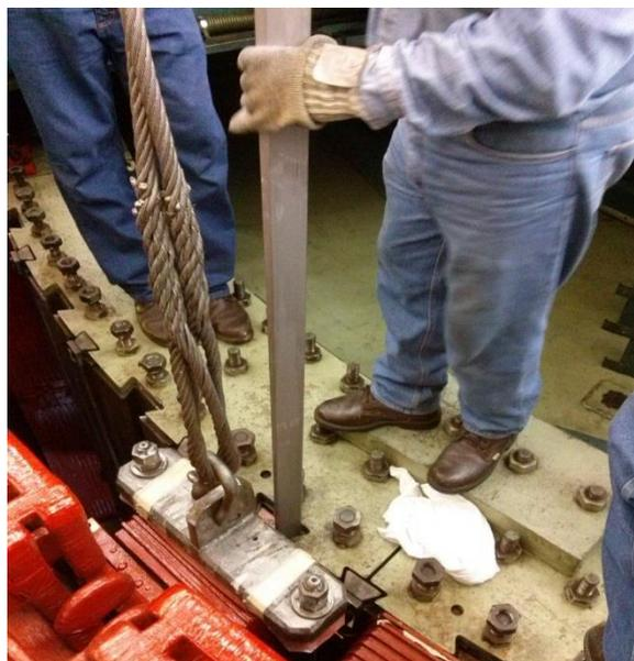
**Fig. 4.77. Colocación de la cuña de presión del polo.**
