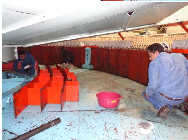
**Fig. 4. 96 Limpieza con dieléctrol y trapos a la llanta del generador**
