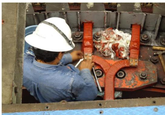
**Figura 4.9 Desmontaje de las barras de excitación**
