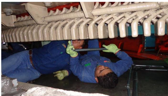
**Fig. 4.89. Colocación de tornillería nueva en la parte inferior de los polos**
