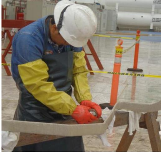
**Figura 4.21 aplicación de la cinta de fibra de vidrio**
