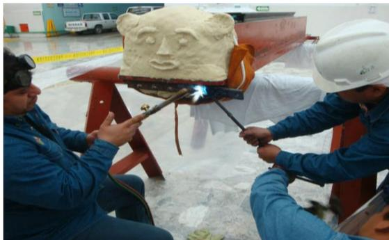
**Figura 4.39 desoldado de la barra amortiguadora**
