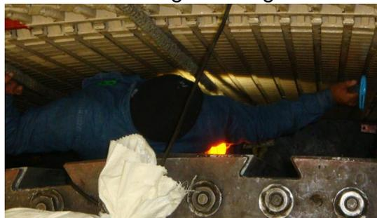
**Fig. 4.1.13 Sondeo del Acañado del estator**
