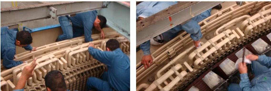
**Fig. 4.1.9 limpieza de cabezales parte superior**
