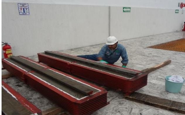
**Fig. 4.55 Limpieza a los polos utilizando dieléctrol**
