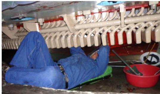
**Fig. 4.84 Conexión de barras amortiguadoras y orejas polares lado inferior**
