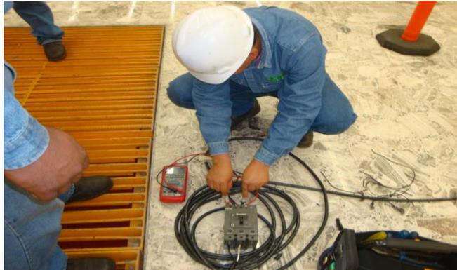
**Figura 4.27. Verificación del potencial aplicado**
