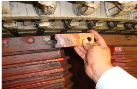
**Figura 4.36 Barra Amortiguadora Fisurada.**
