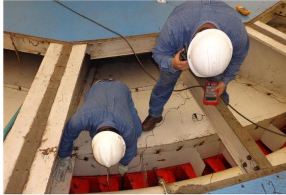
**Figura 4.29. Medición de caída de tensión**
