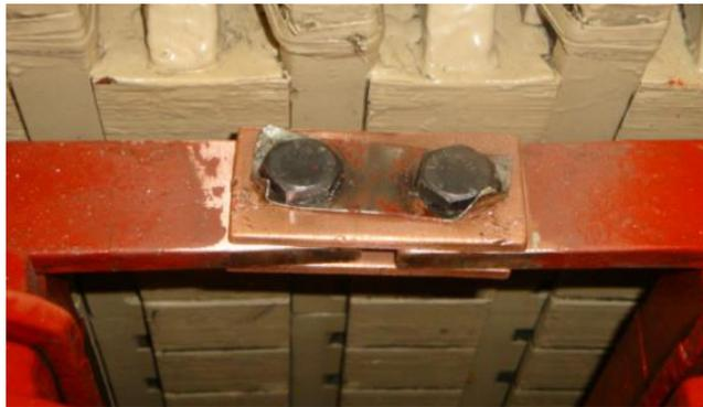
Se continúa con el cambio de tornillería en parte superior de polos (tornillería conexiones Polares y devanado amortiguador).
