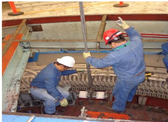
**Figura 4.32. Desmontaje del polo No 35**
