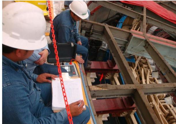
Fig. 4.2.1 prueba de resistencia de aislamiento a las fases del generador
