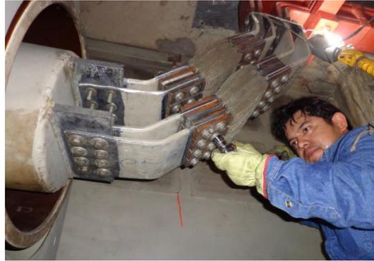
**Fig. 4.1.19 Conexiones de las trenzas lado bus de fase aislada**
