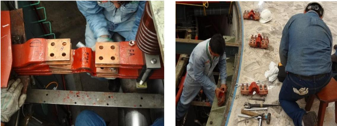
**Fig. 4.1.8 Desconexión de las trenzas del generador**
