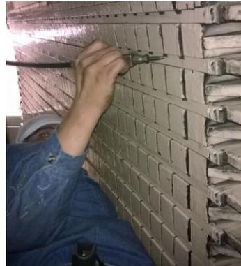
**4.1.12 Sopleteo a ranuras del estator**
