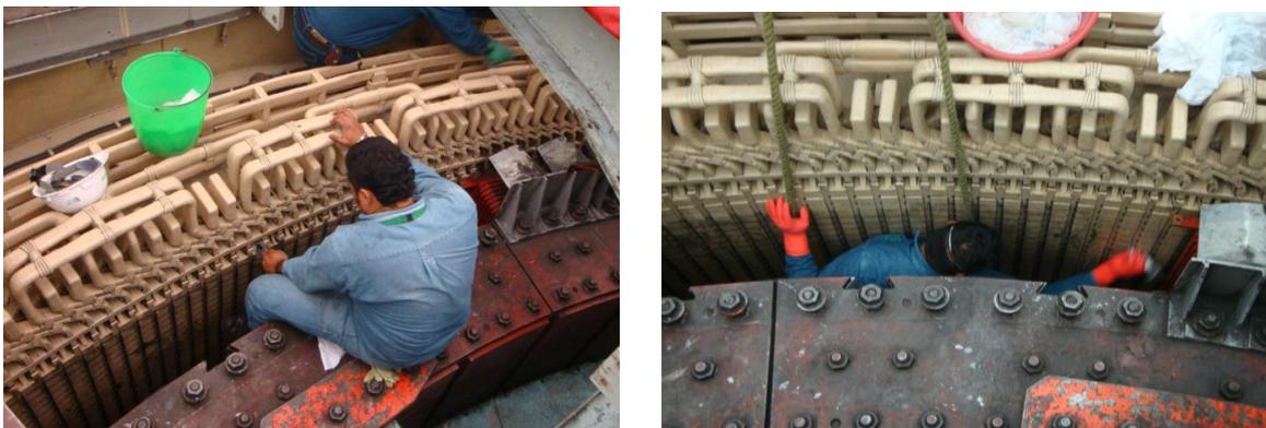
**Fig. 4.1.10 limpiezas con dieléctrol al laminado del estator**
