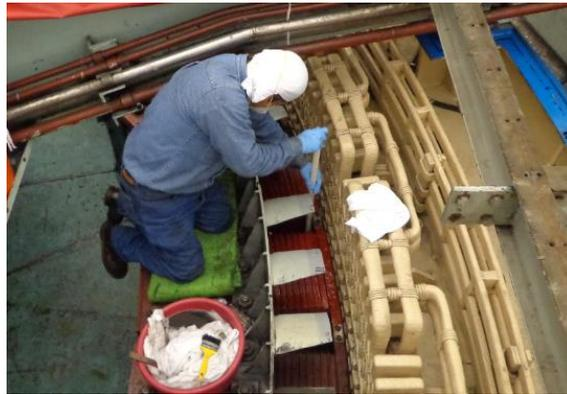
**Figura 4.68. Limpieza de los polos montados parte superior y aspas de ventilación.**
