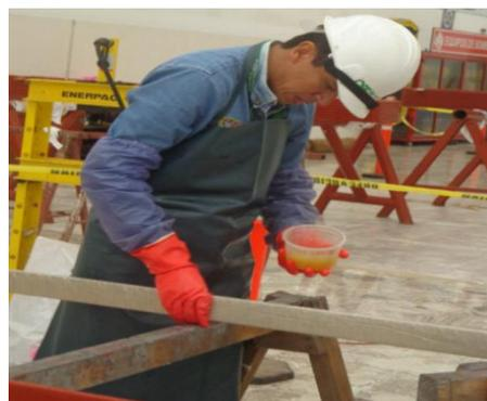
**Figura 4.20 aplicación de la resina epoxica**
