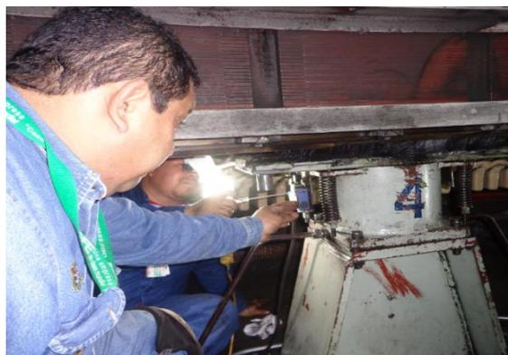
**Fig. 4.92 Se efectúa el mantenimiento a micros de gatos de frenado.**
