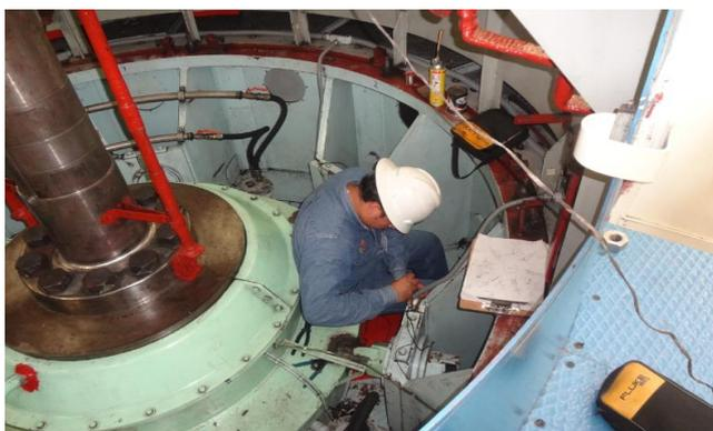
Reubicación de cableado correspondiente a soportes aislantes de chumacera guía generador, fijación de tablillas y conexión de cableado en área de soportes.
