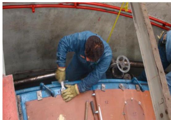
**Fig. 4.1.20 colocaciones de tolvas de fibra de vidrio tanto en la parte superior como la inferior**
