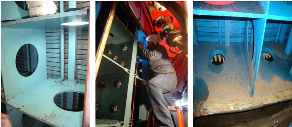
**Fig. 4.1.15 Limpieza de cubículo parte radiadores**
