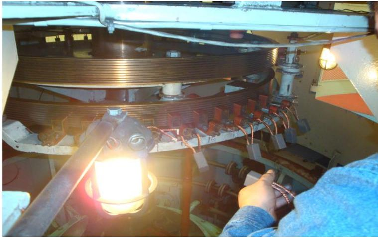
**Figura 4.7. Medición de carbones y reemplazo**
