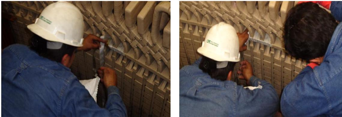
**Fig. 4.1.10 Encintado con cinta de fibra de vidrio a partes deterioradas**
