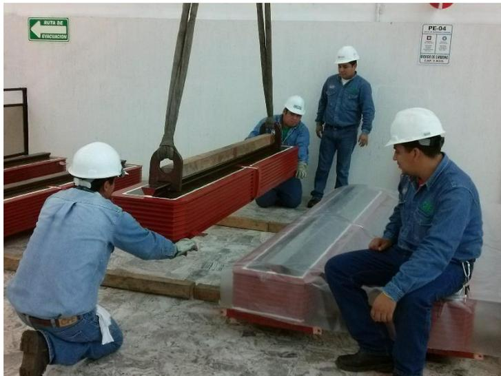
**Fig. 4.65 Colocación de polo terminado.**
