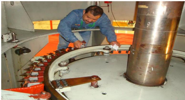
**Figura 4.7. Mantenimiento a los anillos rozantes con dieléctrol**
