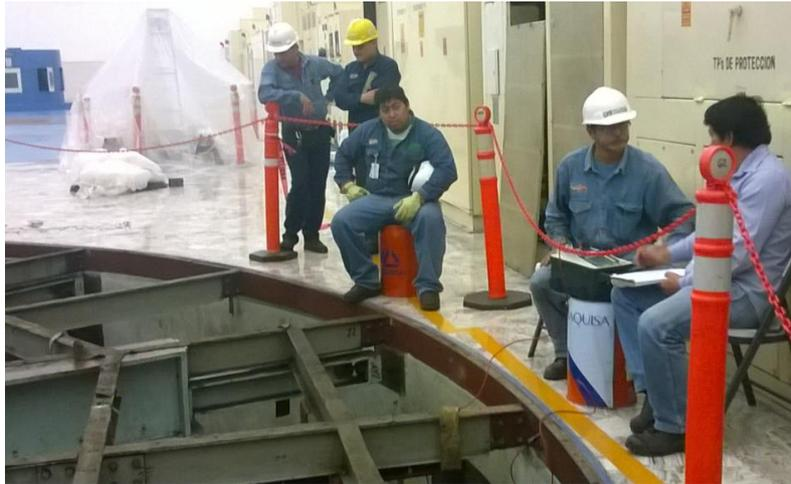
**Fig. 4.2.3 personal de Lapem con ayuda del depto. Eléctrico realizando prueba de resistencia de aislamiento antes de la prueba de HIP-POT.**
