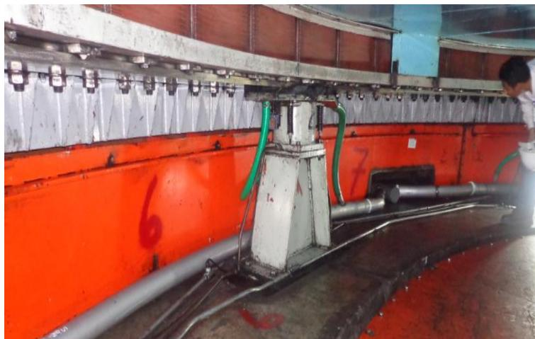
**fig. 4. 93 verificaciones del frenado del generador**
