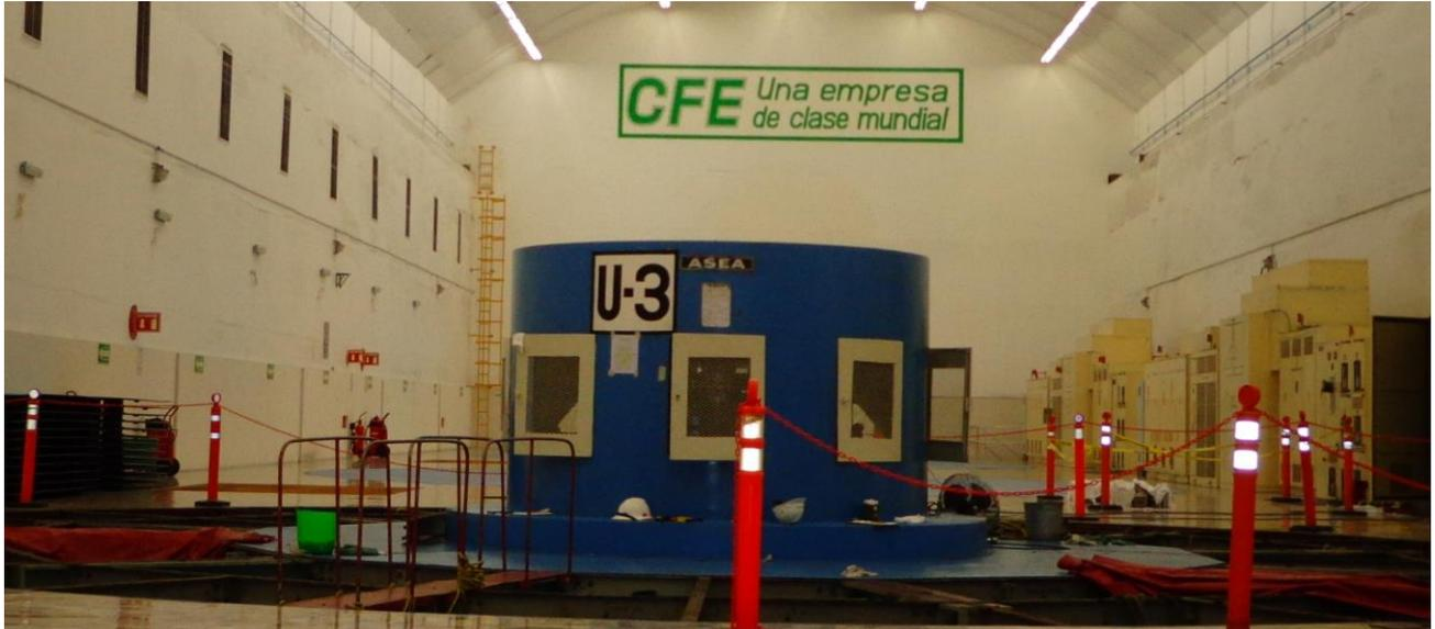
**Fig. 3.5.1 Generador Síncrono de 180 MW**
